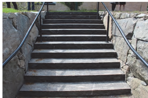
Figur 72 och 73. Trappa tillverkad i kinesisk kalksten, Dark lime.
