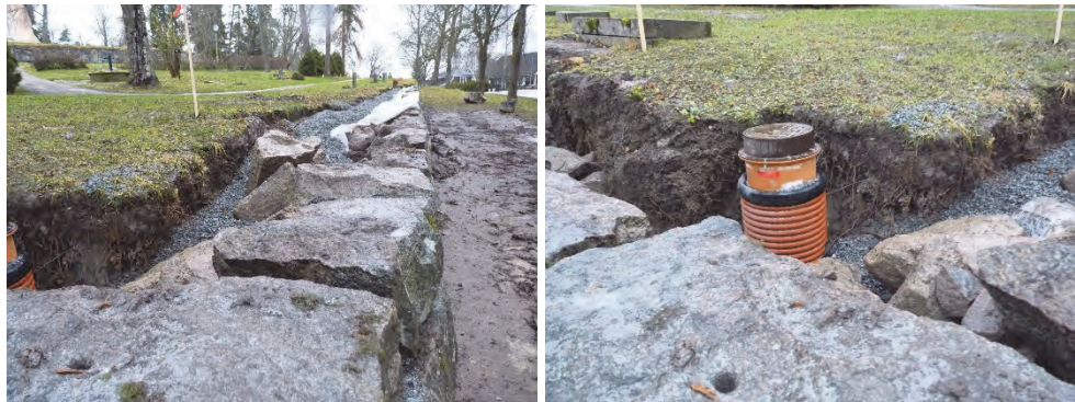
Figur 31. Östra muren omläggning pågår. Till vänster i bilden anas en nytillkommen brunn. Foto: Helén Sjökvist.
