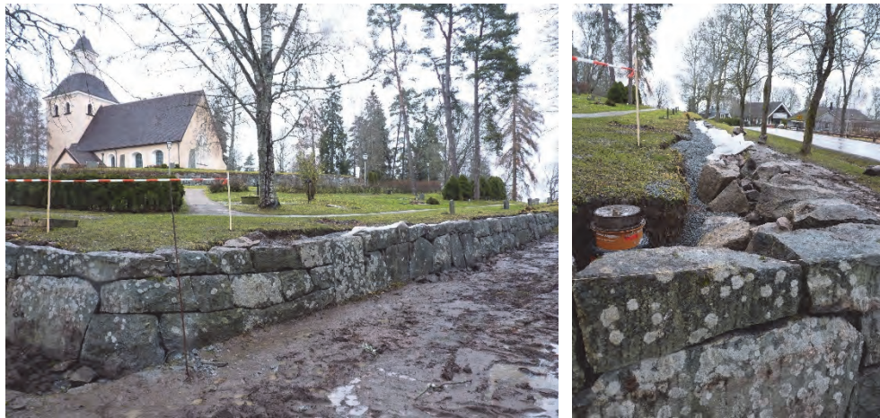
Figur 29. Västra muren omlagd. Foto: Helén Sjökvist.
