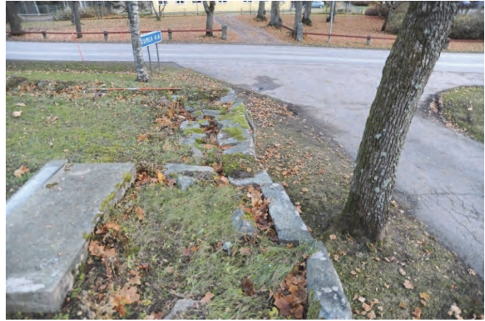
Figur 15. Södra murens ovansida sedd mot öster, före omläggning. Foto: Svensk Klimatstyrning. Figur 16. Södra murens östligaste del före omläggning. Foto: Svensk Klimatstyrning.
