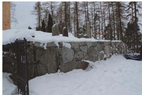
Figur 56. Delar av den äldre muren i norr är nedplockad för att komma i liv med den äldre muren. Foto: Lisa Skanser.
