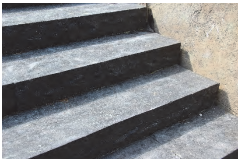
Figur 72 och 73. Trappa tillverkad i kinesisk kalksten, Dark lime.
