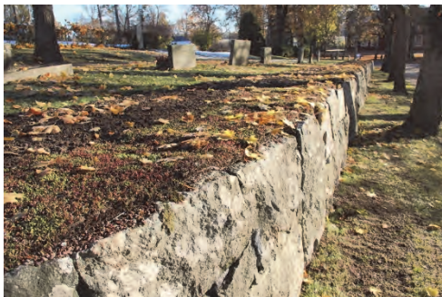
Figur 37. Södra muren efter sedumläggning. Foto: Lisa Skanser.
