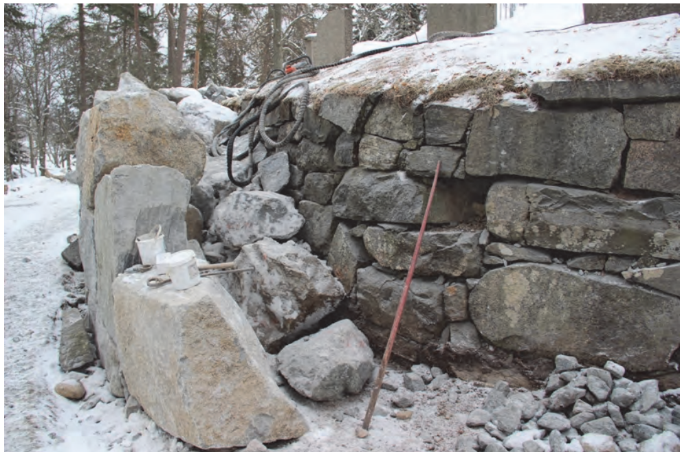
Figur 51. Murning av stödmuren i det nordvästra hörnet pågår. Den äldre muren ligger kvar bakom. Mellanliggande parti mellan de nya skalmurarna fylls med relativt stora stenar. Foto: Lisa Skanser.
