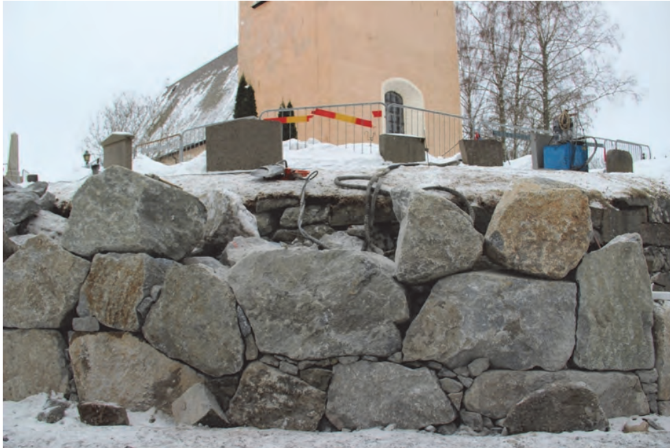
Figur 52. Murning av stödmuren i det nordvästra hörnet pågår. Den äldre muren ligger kvar bakom. Den nya muren har i huvudsak betydligt större och något rundare stenblock än den äldre muren. Andelen små mellanliggande skolstenar är också betydligt större än tidigare. Foto: Lisa Skanser.
