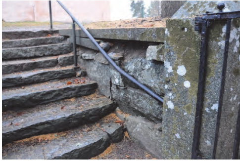
Figur 69. Trappans vänstra sida och rücke före åtgärder. Foto: Svensk Klimatstyrning.
