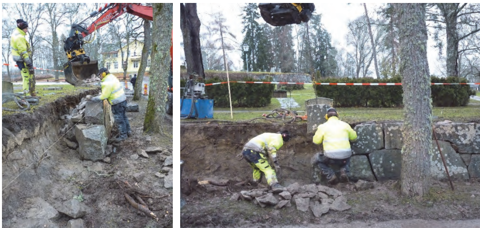
Figur 23. Omläggning av den södra muren. Utrymmet bakom skalmuren återfylls med i huvudsak befintligt stenmaterial. Foto: Helén Sjökvist. Figur 24. Omläggning av den södra muren. Foto: Helén Sjökvist.
