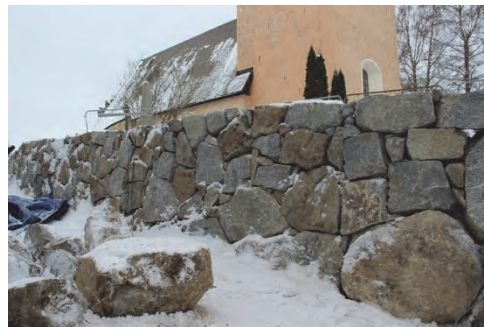
Figur 53. Läggnig av stödmur pågår i det nordvästra hörnet. Foto: Lisa Skanser.
