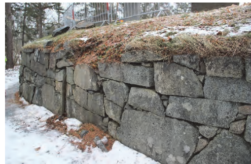
Figur 49. Västra kyrkogårdsmuren före åtgärder. Efter den röda linjen skall den nya stödmuren vinklas ut. Foto: Helén Sjökvist.
