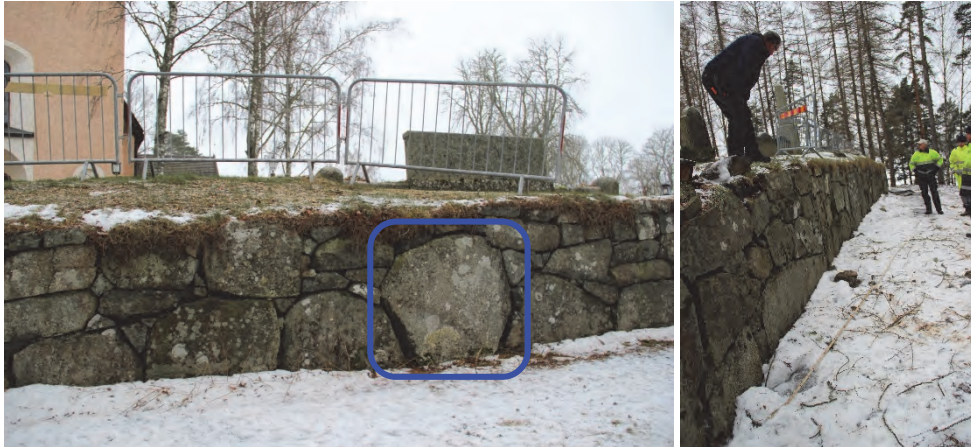
Figur 42. Muren väster om kyrkan. Från den markerade stenen och mot norr planerades muren vinklas utåt. Foto: Helén Sjökvist.
