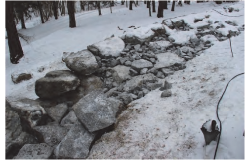
Figur 57. Anslutning mellan ny och gammal mur. Foto: Lisa Skanser.
