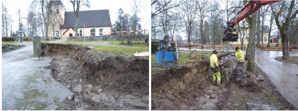
Figur 27. Muren vid södra entrén nedmonterad. Foto: Helén Sjökvist.
