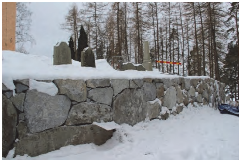
Figur 55. Norra muren, ny stödmur Foto: Lisa Skanser.
