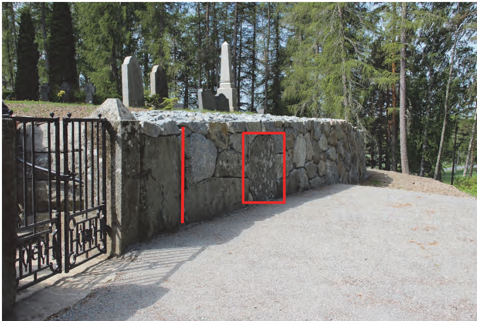
Figur 63. Ny stödmur sneddass ut från den röda linjen. Röd fyrkant markerar en sten som ligger i ungefärligt ursprungligt läge. Foto: Lisa Skanser.
