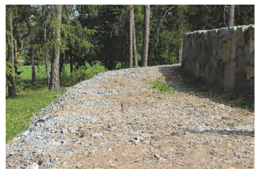
Figur 59. Västra partiet av den nya stödmuren färdigställd men utan sedumtäckning. Foto: Lisa Skanser.
