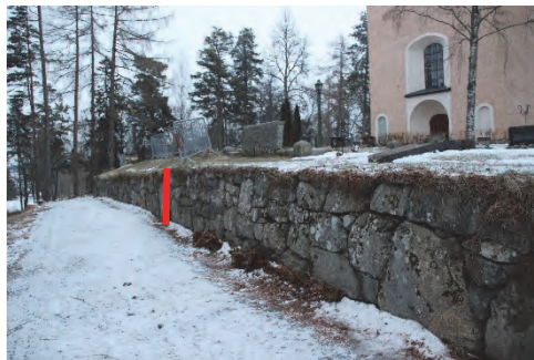
Figur 49. Västra kyrkogårdsmuren före åtgärder. Efter den röda linjen skall den nya stödmuren vinklas ut. Foto: Helén Sjökvist.
