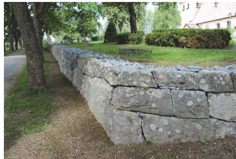
Figur 35. Östra muren färdigställd, innan sedumtäckning. Foto: Lisa Skanser.
