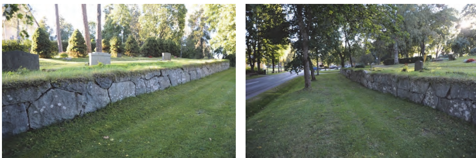
Figur 21. Västra muren sedd mot norr före omläggning. Foto: Svensk Klimatstyrning. Figur 22. Västra muren sedd mot söder före omläggning. Foto: Svensk Klimatstyrning.
