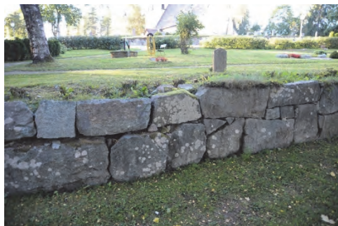
Figur 19. Västra murens södra del med sättningar före omläggning. Foto: Svensk Klimatstyrning. Figur 20. Västra murens södra del före omläggning. Foto: Svensk Klimatstyrning.
