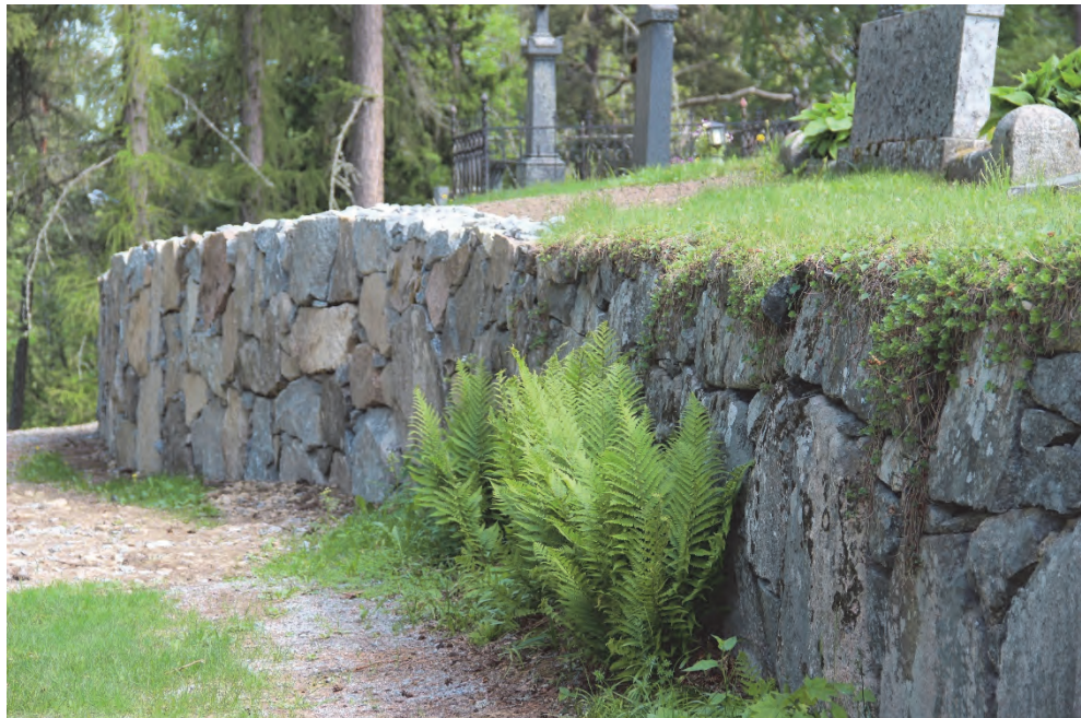
Figur 59. Västra partiet av den nya stödmuren färdigställd men utan sedumtäckning. Foto: Lisa Skanser.
