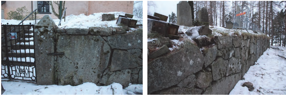
Figur 44. Grindöppning före åtgärder.
