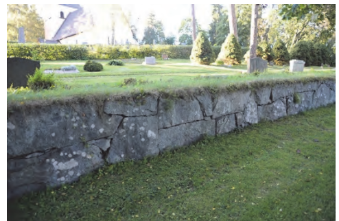
Figur 19. Västra murens södra del med sättningar före omläggning. Foto: Svensk Klimatstyrning. Figur 20. Västra murens södra del före omläggning. Foto: Svensk Klimatstyrning.
