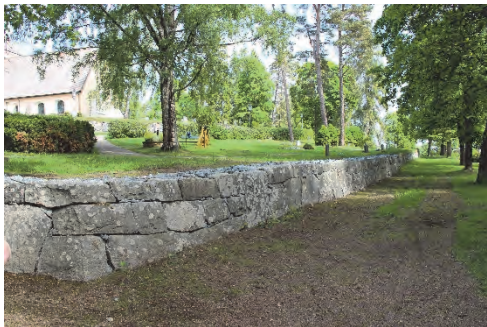
Figur 35. Östra muren färdigställd, innan sedumtäckning. Foto: Lisa Skanser.
