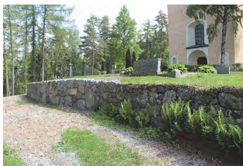
Figur 60. Ny stödmur sedd från sydväst. Foto: Lisa Skanser.
