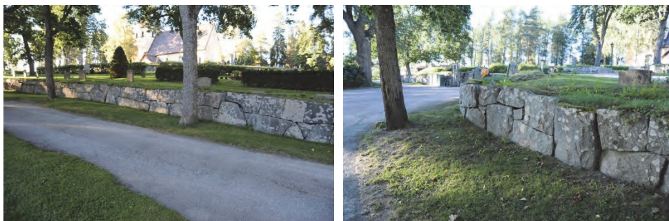
Figur 11. Södra muren före omläggning. Foto: Svensk Klimatstyrning.
