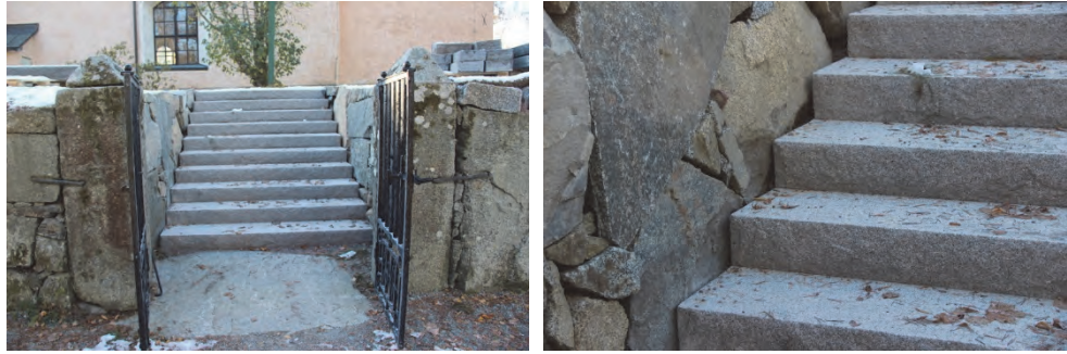
Figur 74 och 75. Ny trappa utförd i bohusgranit. Foto: Lisa Skanser.
