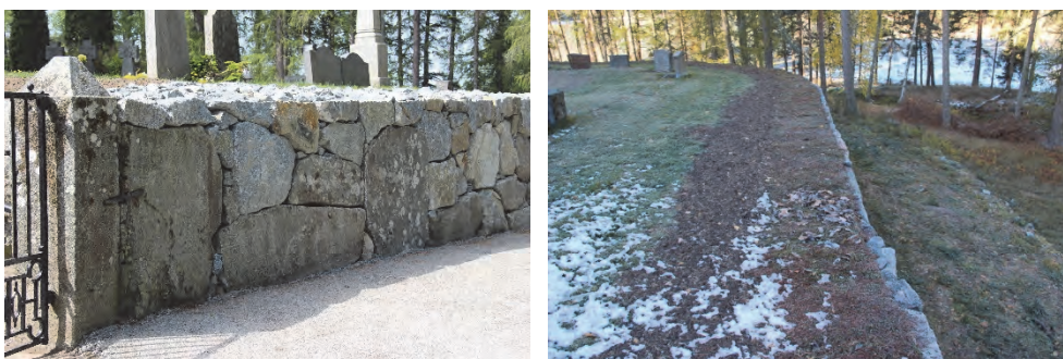
Figur 64. Anslutning mot gammal mur vid norra trappan. Foto: Lisa Skanser.
