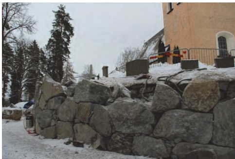
Figur 53. Läggnig av stödmur pågår i det nordvästra hörnet. Foto: Lisa Skanser.
