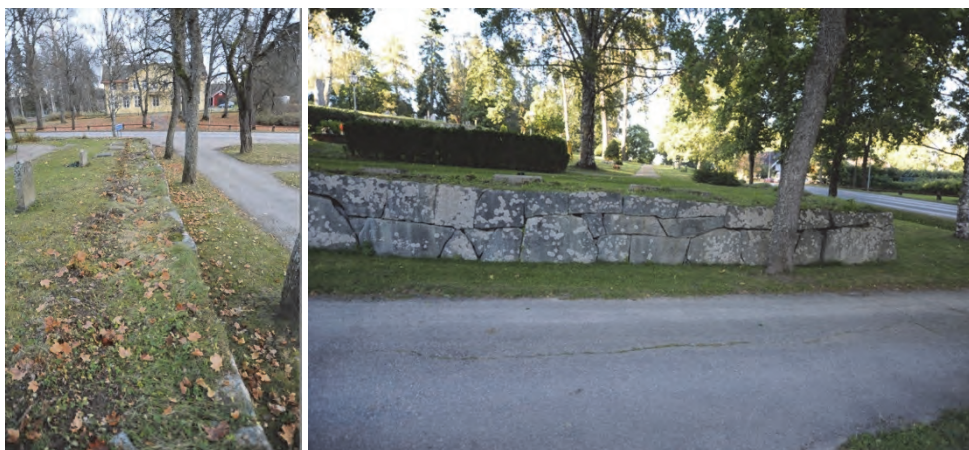
Figur 13. Södra murens ovasida sedd mot öster före omläggning. Foto: Svensk Klimatstyrning.
