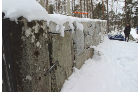
Figur 57. Anslutning mellan ny och gammal mur. Foto: Lisa Skanser.
