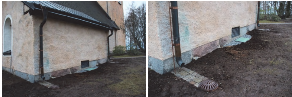
Figur 14. Takavvatning på sakristian efter åtgärder. Foto: Lisa Skanser.
