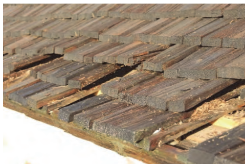
Figur 25. Skadat takspån på tornhuven borttaget inför montering av krokar till hängrännor. Foto: Lisa Skanser.
