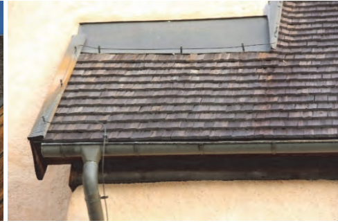
Figur 21. Långhustaket före åtgärder. Vattentrycket befarades bli för hårt på en koncentrerad punkt på spåntaket med den föreslagna lösningen där stuprör ledde ned tornets takvatten till långhustaket vid den blå cirkeln. Röd linje markerar behovet av överrinningskydd på hängrännan. Foto: Lisa Skanser.
