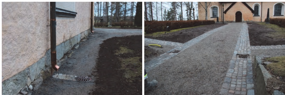
Figur 16. Norra fasaden med stuprör och gatstensbelagd ränna till kupsilsil. Marken är återställd till tidigare grusat utförande. Foto: Lisa Skanser.
