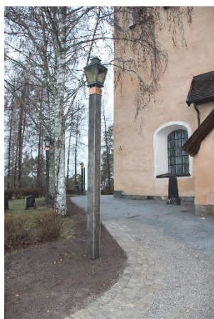
Figur 36 och 37. Nya stolpar för kyrkogårdsbelysningen med nytt kopparfäste och tjärad inklädnad av bräder. Armaturen är renoverad och återanvänd. Foto: Lisa Skanser.
