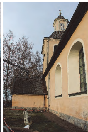
Figur 10. Arbete pågår med brunn med kupolsil samt dränerande singel. Foto: Lisa Skanser. Figur 11. Södra fasadens schakt igenfyllt efter grävarbeten. Foto: Lisa Skanser.
