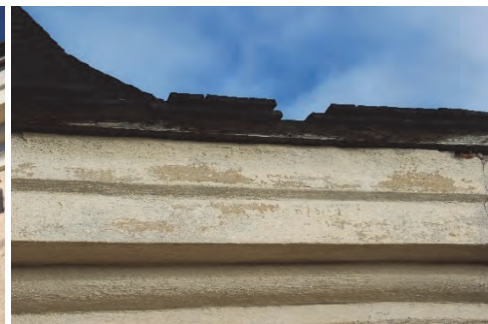
Figur 23. En av puts-skadorna i tornets takgesims. Foto: Lisa Skanser.
