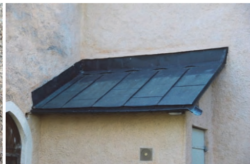
Figur 27. Ersättningspån som fanns på plats. Ytterligare införskaffades från Hälsinge takspån.
