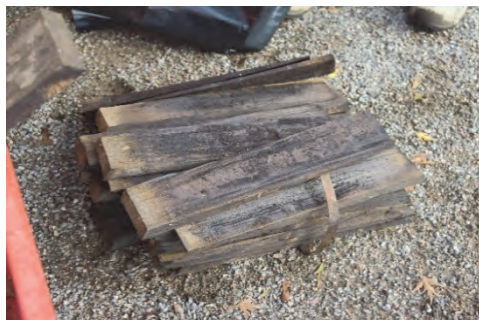
Figur 27. Ersättningspån som fanns på plats. Ytterligare införskaffades från Hälsinge takspån.
