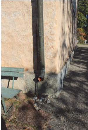
Figur 6. Kyrkans sydöstra hörn med stuprörsutkastare och dränering. Foto: Lisa Skanser. Figur 7. Kyrkans norra fasad före åtgärder. Foto: Lisa Skanser.
