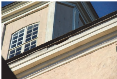
Figur 23. En av puts-skadorna i tornets takgesims. Foto: Lisa Skanser.
