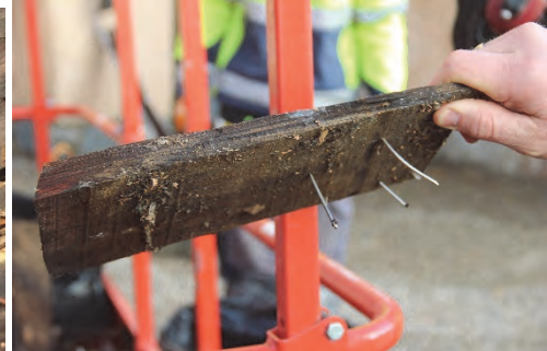
Figur 25. Skadat takspån på tornhuven borttaget inför montering av krokar till hängrännor. Foto: Lisa Skanser.
