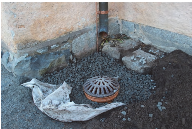
Figur 10. Arbete pågår med brunn med kupolsil samt dränerande singel. Foto: Lisa Skanser. Figur 11. Södra fasadens schakt igenfyllt efter grävarbeten. Foto: Lisa Skanser.
