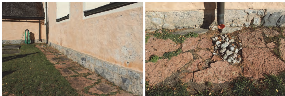
Figur 4. Kalkstensplattor lagda utmed södra fasaden. Före åtgärder. Foto: Lisa Skanser.
