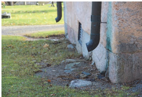
Figur 8. Norra fasaden före åtgärder. Grusad gång invid grunden till skillnad från södra sidans kalkstensbeläggning. Foto: Lisa Skanser. Figur 9. Sakristians utkastare före åtgärder. Gräsmattan går emot grunden. Foto: Lisa Skanser.
