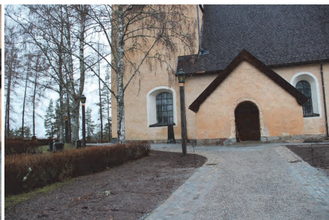
Figur 36 och 37. Nya stolpar för kyrkogårdsbelysningen med nytt kopparfäste och tjärad inklädnad av bräder. Armaturen är renoverad och återanvänd. Foto: Lisa Skanser.
