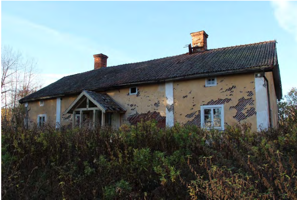
13118_053. Östra fasaden, sedd från nordost.
