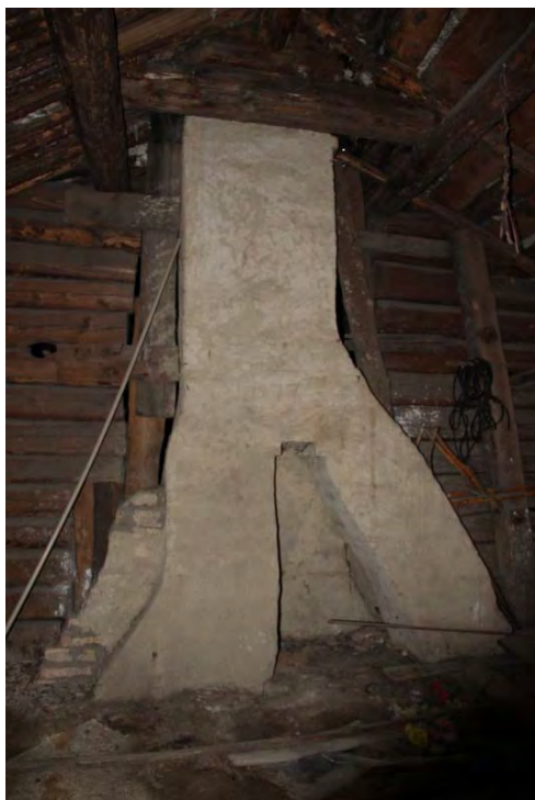
13118_251. Rum 207, murstock i väggen mot rum 205.
