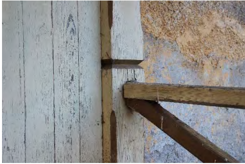
13118_118. Spontad panel på fasaden innanför förstuvisten. 13118_063. Trälagningar har gjorts i stolparnas nedre delar.
