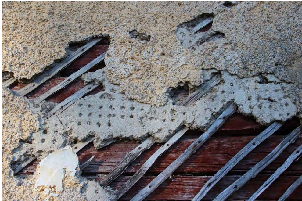
13118_061. Reveteringens uppbyggnad med putsribbor, hålad lerklining och utanpåliggande spritputs.
