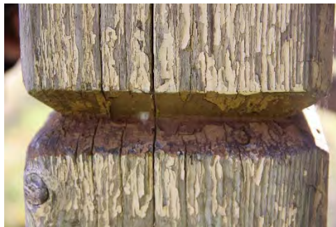
13118_271. Den tidigare blå färgsättningen på detaljerna syns under den slagnande färgen. 13118_272. Här syns detaljernas gulbruna kulör och den blå kan anas under.
