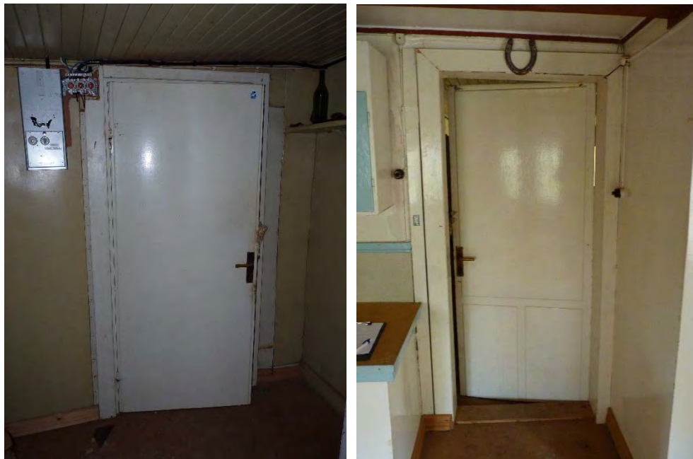
13118_291. Dörr mellan rum 101 och 102, fotograferad från 101. Masonitklädd, gångjärn med kullrig knapp.
