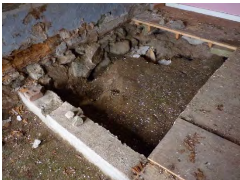
13118_393. Rum 104, betongbjälklag under det delvis uppbrutna golvet.
