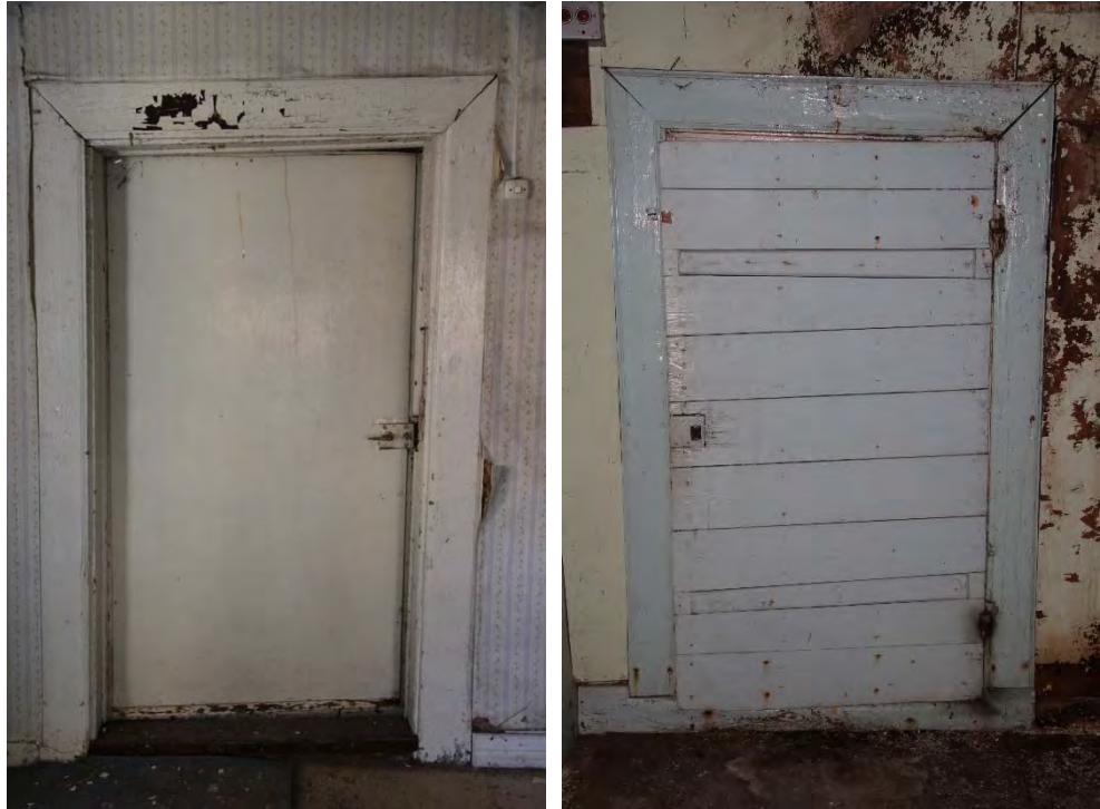
13118_209. Masonitklädd dörr mot rum 108 fotad från 107.
