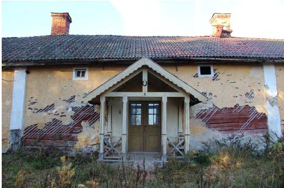
13118_054. Förstukvisten vid östrafasaden.
