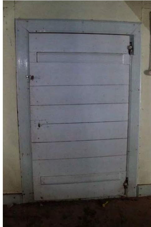
13118_207. Dörr mot rum 104 fotograferad från 101. Profilhyvlade naror och handsmidda gångjärn.
