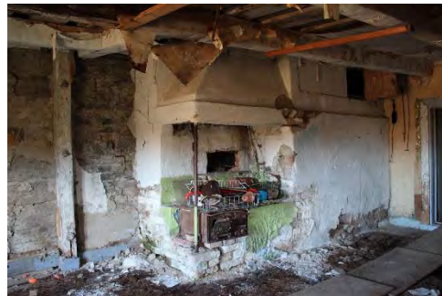
13118_149. Rum 105 mot nordöst, murspis längs östra delen av norra väggen.
