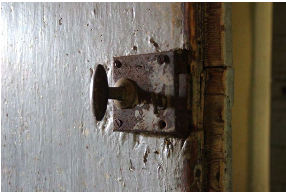
13118_140. Dörr mot rum 105. På insidan, mot rum 105, sitter ett sekundärt kammarlås med kort låsbuss och spolformat vred.
