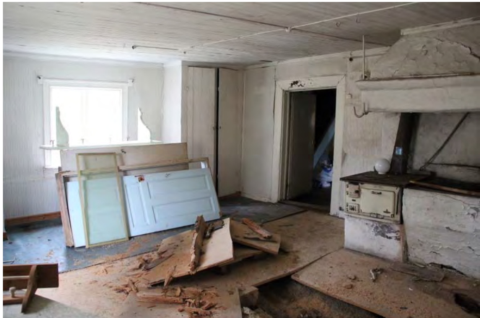
13118_013. Rum 107 mot sydöst.
