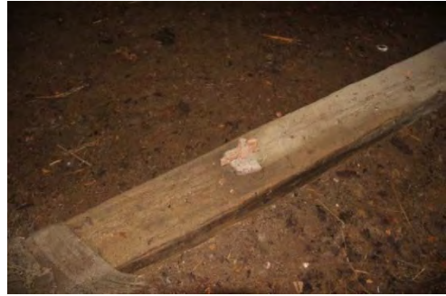
13118_244. Rum 205, bjälke väster om rummets mitt. Bult genom bjälklag.
