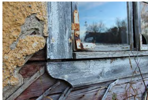
13118_093. Fönster med ornerat foder och beslag från andra hälften av 1800-talet.
