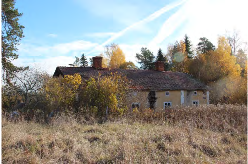
13118_124. Västra fasaden täcks delvis av ett buskage, bilden taget från nordväst.
