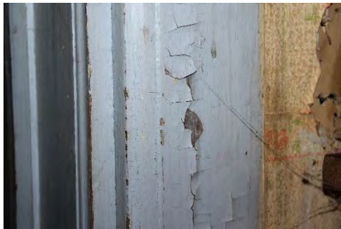
13118_187. Rum 105, handhyvlat dörrfoder med äldre färgskikt synligt i krackeleringen.
