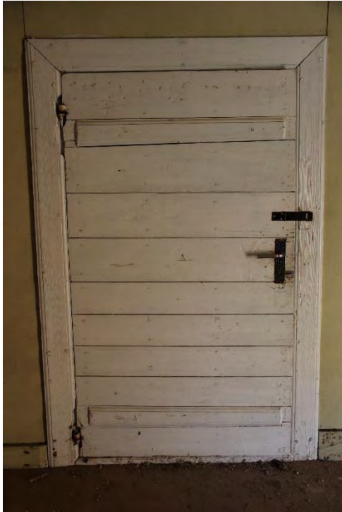
13118_207. Dörr mot rum 104 fotograferad från 101. Profilhyvlade naror och handsmidda gångjärn.
