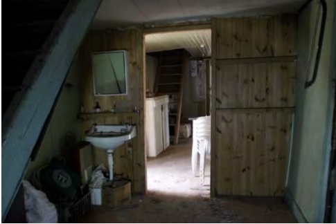
13118_030. Rum 108, mot söder.
