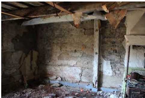
13118_152. Rum 104, norra väggens västra del, följare i skarv mellan timrad och murad del.
