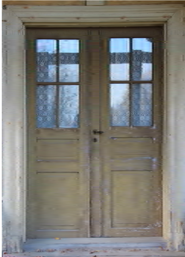
13118_116. Spegelindelad pardörr i entrén.
