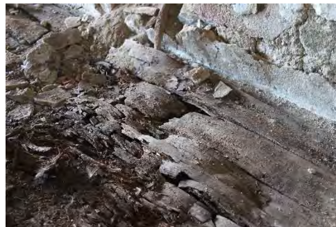
13118_152. Rum 104, norra väggens västra del, följare i skarv mellan timrad och murad del.
