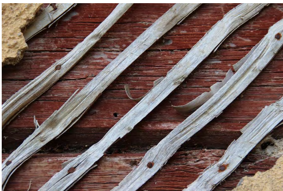
13118_076. Den rödslammade timmerstommen har sekundärt blivit reveterad, här syns de klyvna slanorna som spikats på timret för att reveteringen ska fästa.
