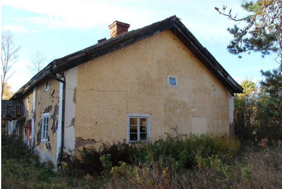
13118_079. Norra gaveln. Blinderingen täcker ett igensatt fönster.
