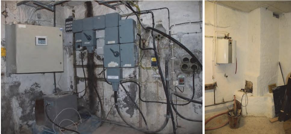
Figur 29. Källaren under sakristian. Svärtningen av väggen beror på att någon vid något tillfälle tagit bort röret för piscinan som leddes ned från sakristian till pumpgropen. Under lång tid rann alltså det vin man hällde i piscinan ned på elskåpet. Foto: Lisa Skanser.
