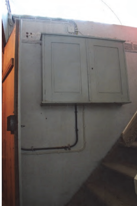
Figur 19. Befintligt skåp för elcentral är placerat i trappan i tornrummet. utrustningen innanför luckorna har demonterats. Foto: Lisa Skanser.
