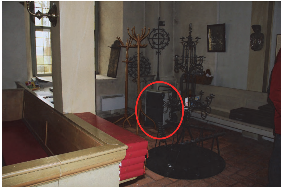
Figur 14. Avfuktaren inställd löst under läktarens södra del. Foto: Helén Sjökvist.
