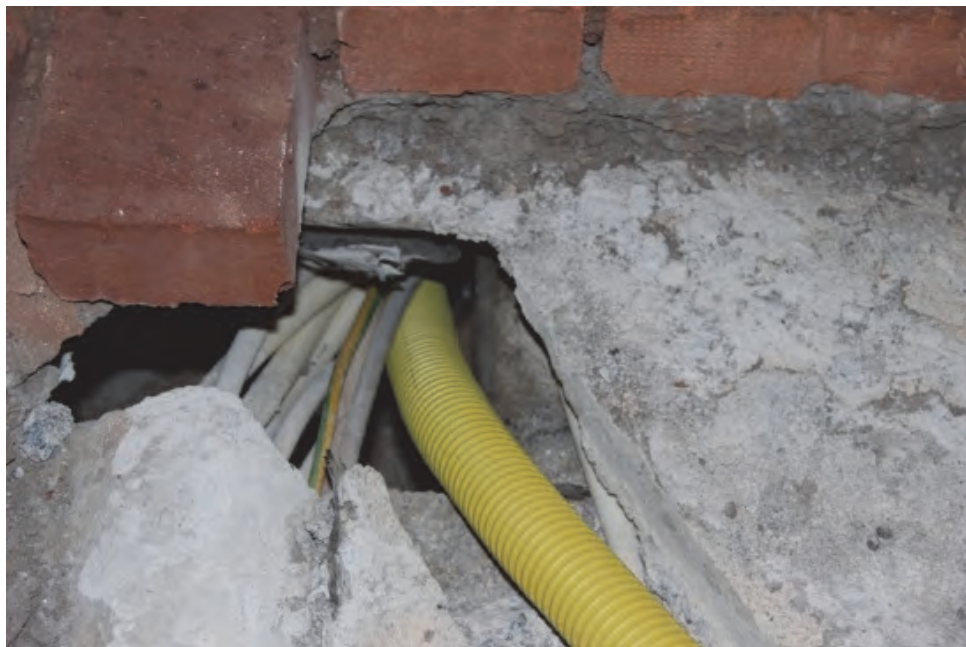
Figur 6. Håltagning och ny slang för kabeldragning. Foto: Lisa Skanser.
