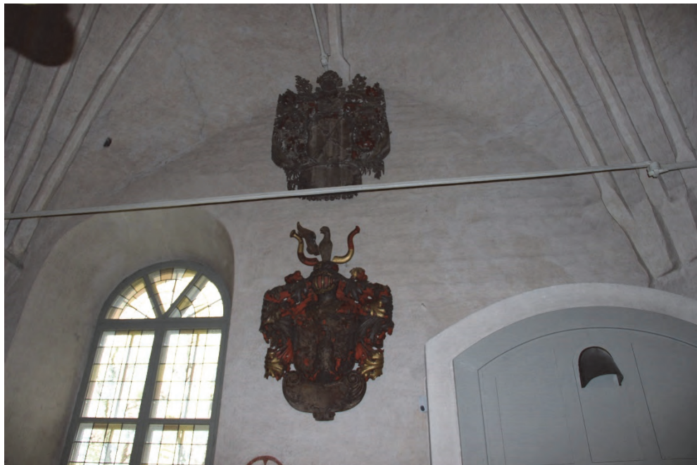
Figur 33. Ny placering av epitafer på södra väggen vid sydentrén. Foto: Helén Sjökvist.
