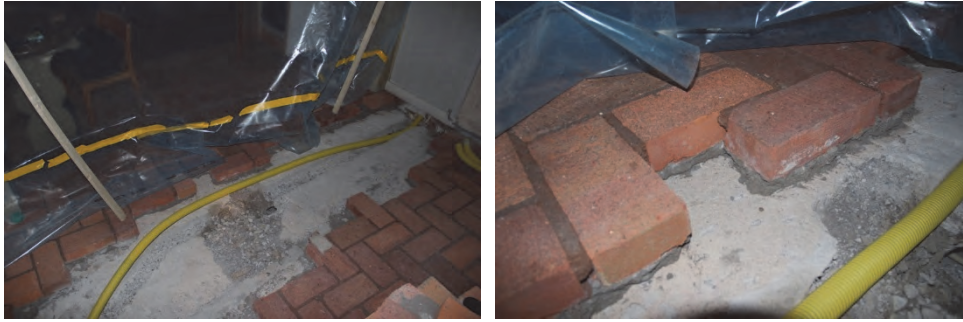
Figur 7. Upptaget golv sett mot sydväst. Foto: Lisa Skanser.
