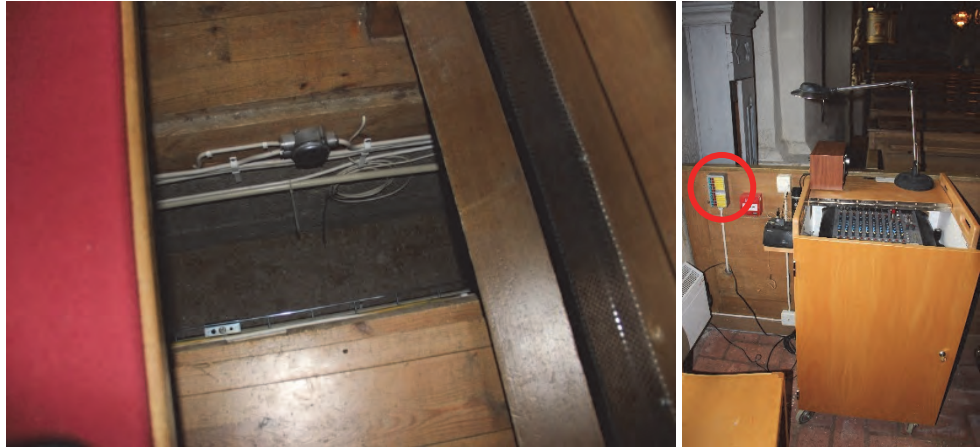
Figur 12. Trägolv demonterat i norra bänkkvarteret för att komma åt underliggande kabelkanal. Foto: Lisa Skanser.
