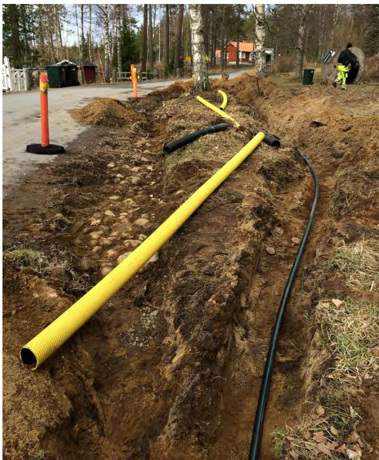
Figur 3. I schaktet till vänster ses stenpackning 5 och 6 (till höger om sandhögen som ligger på vägen). Det alternativa schaktet till höger (teleschaktet) visar inga rester av stenpackningar. Foto från SSV av Christian Gatti.
