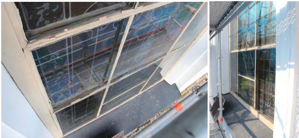
Figur 53 och 54. Korfönstret före åtgärder, bågen sluter bättre an mot karmen. Foto: Lisa Skanser.
