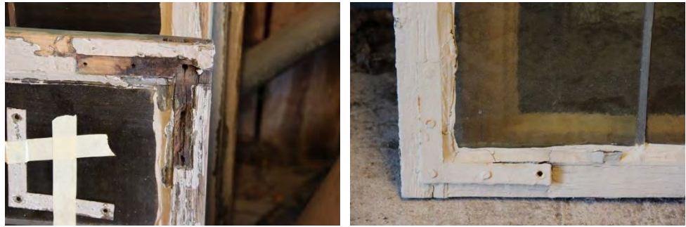
Figur 15. Träskador i bågens bottenstycke och i slitsen i nedre delen av sidostycke. Foto: Lisa Skanser.
