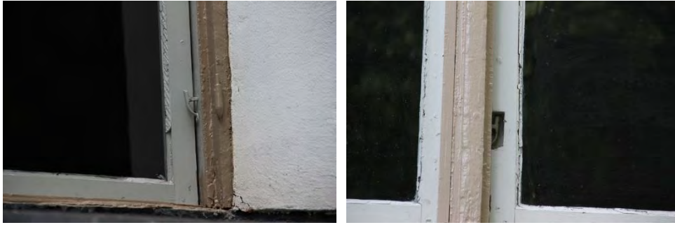
Figur 21 och 22. Kitt saknas, glaset målat före åtgärd. Nu kittades de vid renoveringen Foto: Lisa Skanser.
