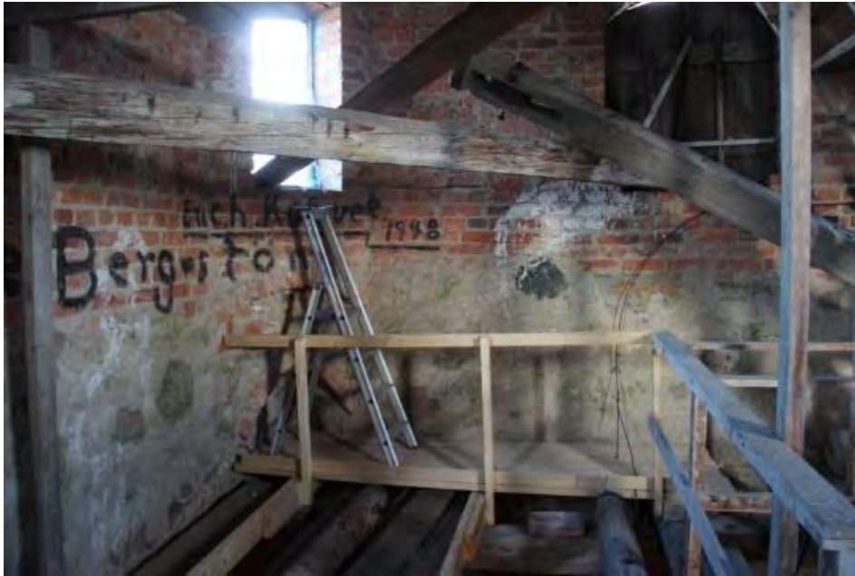
Figur 63. Gångbrygga till vertikalt tornfönster. Foto: Lisa Skanser.
