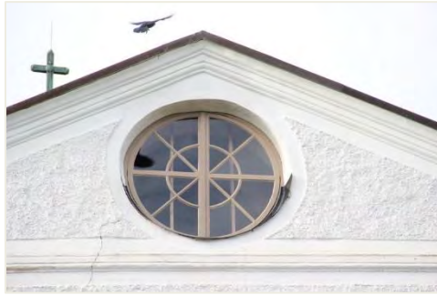
Figur 57. Vindsfönster mot öster samt puts-skada åtgärdade. Foto: Lisa Skanser.
