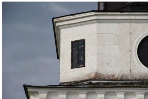
Figur 9. Tornets övre del före åtgärder. Foto: Lisa Skanser.
