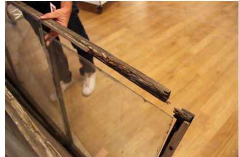
Figur 31. Äldre sammanfogning som gått isär. Foto: Lisa Skanser.
