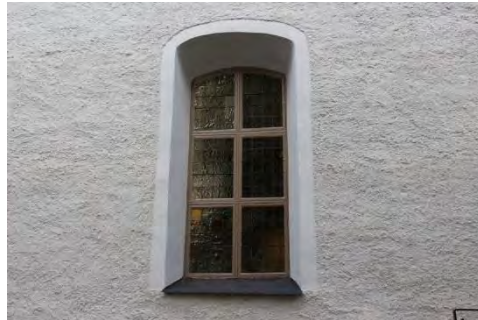
Figur 45. Fönster på södersidan åtgärdat. Foto: Lisa Skanser.
