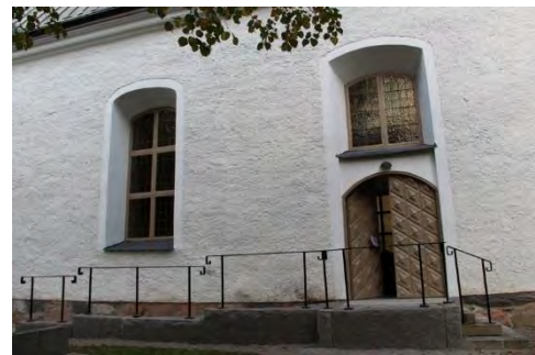
Figur 48. Södersidans port och överljusfönster efter åtgärder. Foto: Lisa Skanser.
