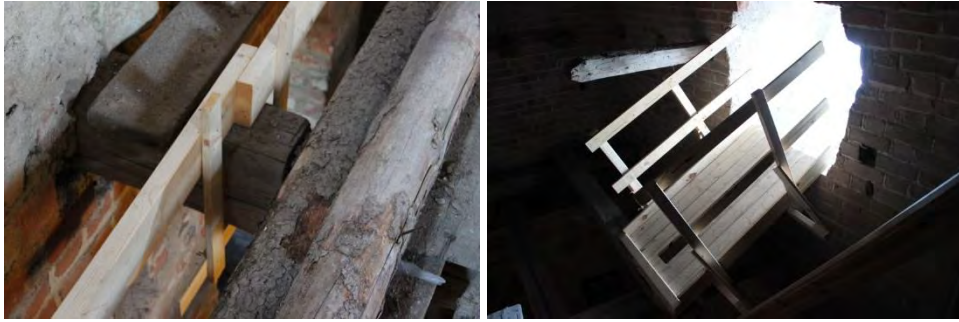
Figur 61. Gångbrygga till övre, runt tornfönster. Foto: Lisa Skanser.
