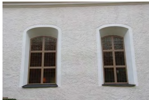
Figur 42. Fönster på norra långsidan färdigställda. Foto: Lisa Skanser.
