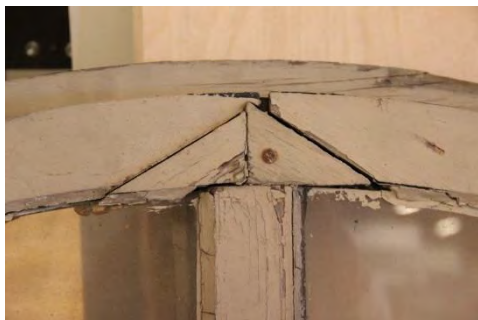
Figur 35. Äldre lagning korffönster. Foto: Lisa Skanser.
