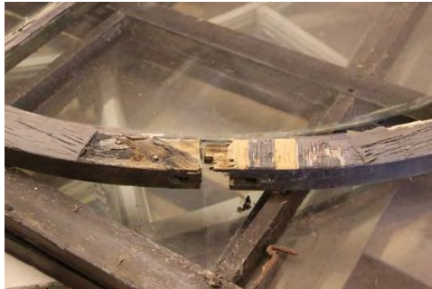
Figur 31. Äldre sammanfogning som gått isär. Foto: Lisa Skanser.
