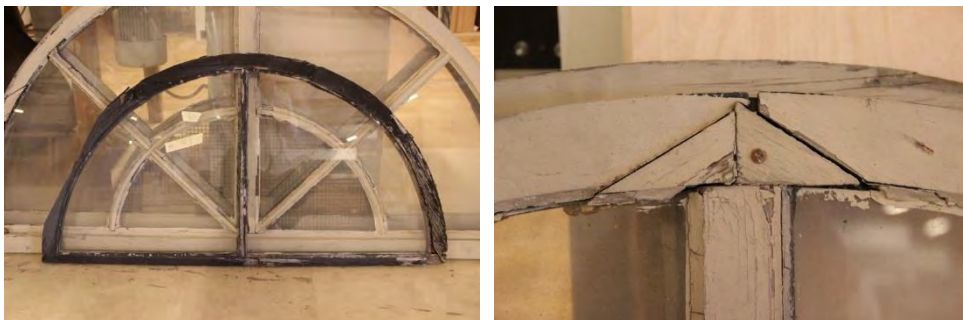
Figur 27. Del av runt tornfönster (främst) samt korfönster (bakgrund). Foto: Lisa Skanser. Figur 28. Äldre lagning på korfönster. Foto: Lisa Skanser.
