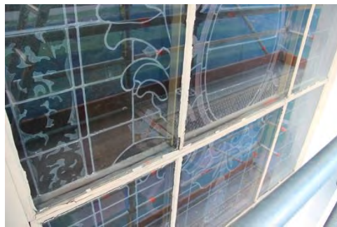
Figur 7. Löst sittande och sprucket kitt. Korfönster. Foto: Lisa Skanser.
