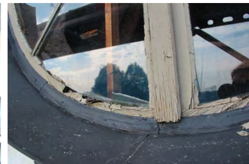
Figur 7. Löst sittande och sprucket kitt. Korfönster. Foto: Lisa Skanser.
