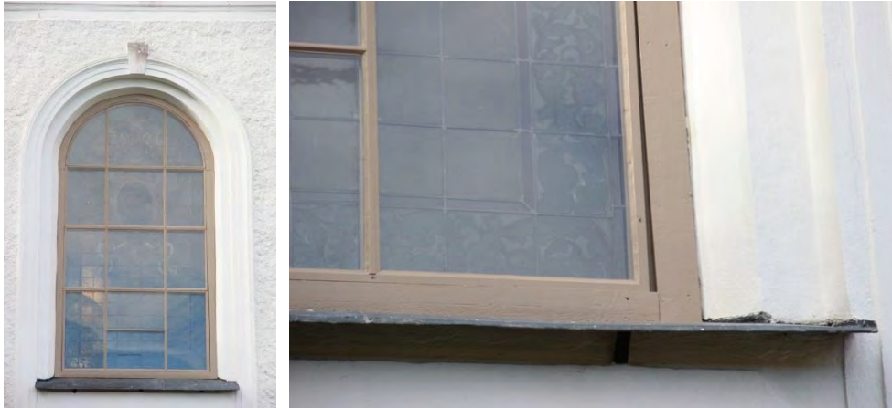
Figur 51. Korfönstret färdigställt. Foto: Lisa Skanser.
