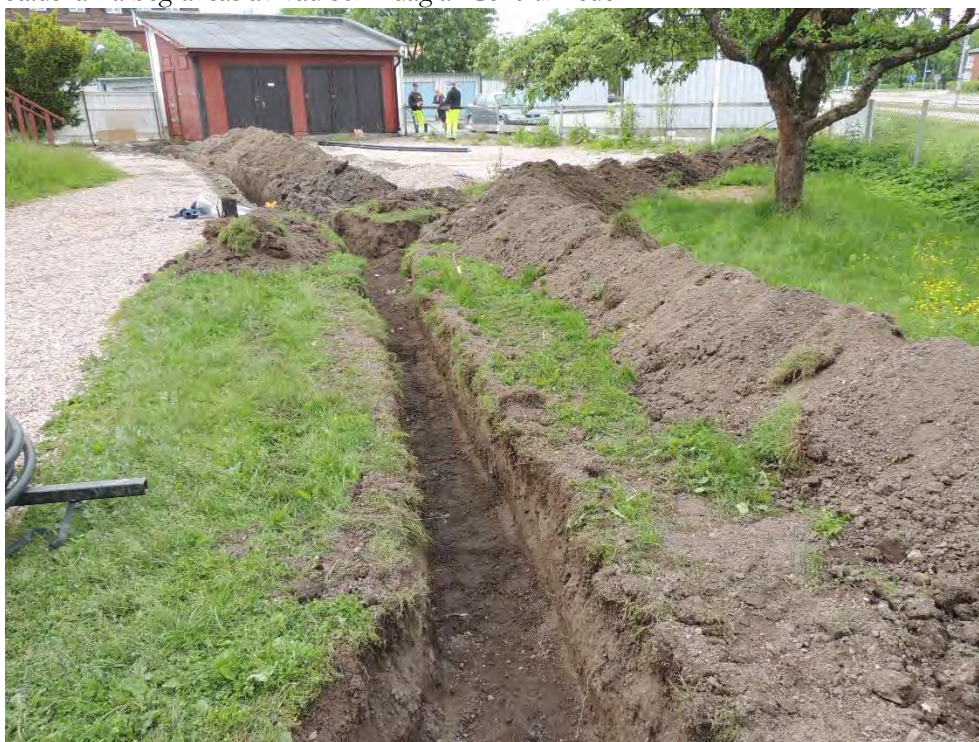
Figur 3. Delschakt 1. Odd Fellows-husets gårdsplan med öppna schakt för bergvärme (foto från norr I. Harrysson)
