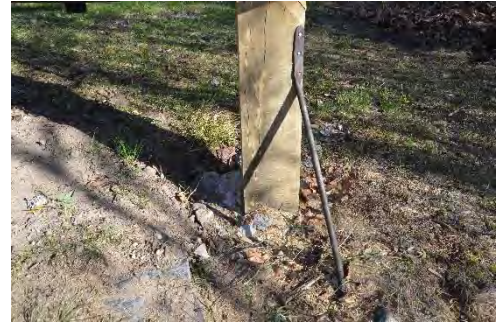
Figur 13. Stagningen av stolpen längst åt väster, efter åtgärd. De äldre stagen återamvändes. Foto: Tobias Mårud.
