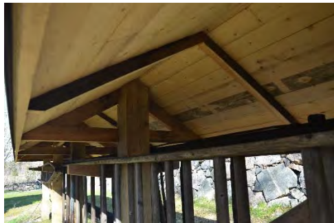
Figur 15. Mellan takstolarna tillkom sparrar för att ytterligare stötta takkonstruktionen. Foto: Tobias Mårud.
