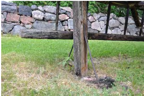
Figur 7. Exempel på stagning av konstruktionen, här stolpen längst åt väster. Foto: Tobias Mårud.
