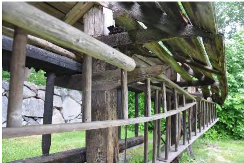
Figur 9. Bilden visar ett av oken som bär stegarna, samt en av takstolarna. Foto: Tobias Mårud.
