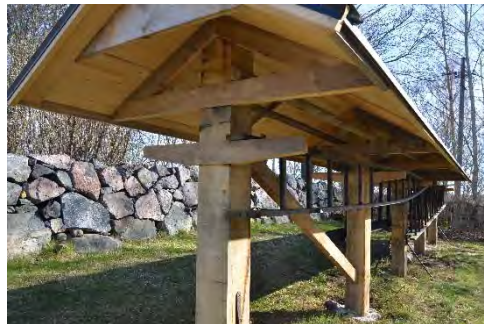
Figur 9. Bilden visar ett av oken som bär stegarna, samt en av takstolarna. Foto: Tobias Mårud.
