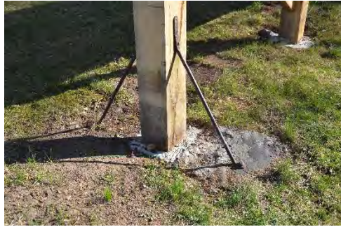
Figur 13. Stagningen av stolpen längst åt väster, efter åtgärd. De äldre stagen återamvändes. Foto: Tobias Mårud.
