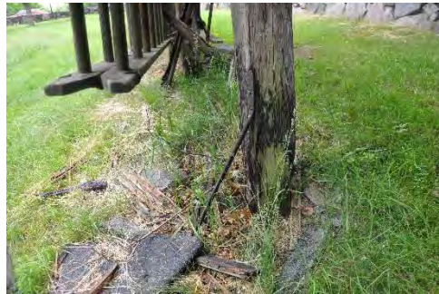
Figur 7. Exempel på stagning av konstruktionen, här stolpen längst åt väster. Foto: Tobias Mårud.
