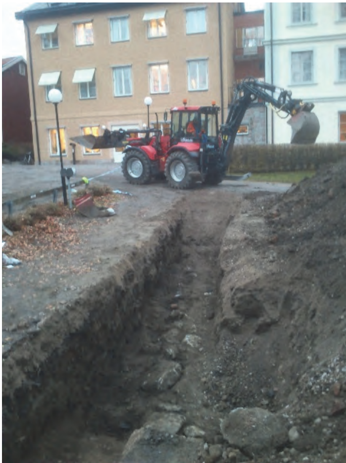
Figur 20. I schakt 3 påträffades en syllstensrad tillhörande en huslämning som dateras 1700–1800-tal. Fotograferat från sydväst av Jonas Ros.
