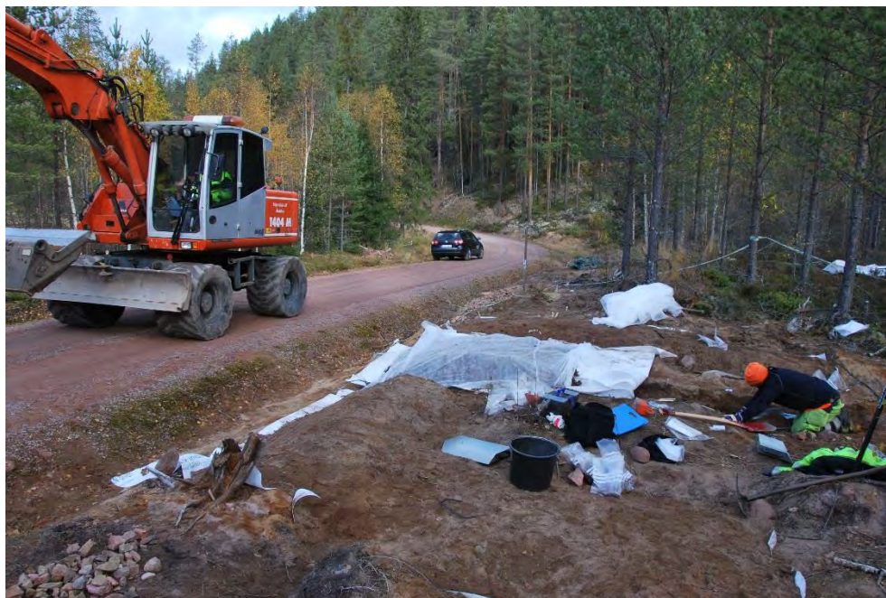
Figur 14. Restaureringen av boplatsvallen skedd med hjälp av grävmaskin som hämtade jord från dumphögar i närområdet. Undersökningen av östra delen av profilschaktet pågick fortfarande när angränsande schakt fylldes igen. Foto Fredrik Hallgren.
