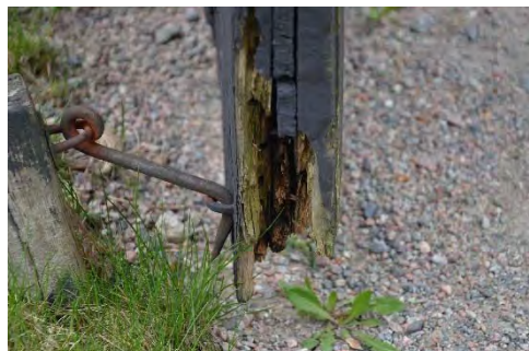
Figur 26. Rötskada i nederkant på södra dörrbladets utsida. Foto: Tobias Mårud.
