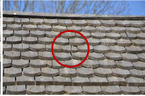
Figur 12. Exempel på ett av få skadade takspån, detta på södra takfallet. Foto: Tobias Mårud.
