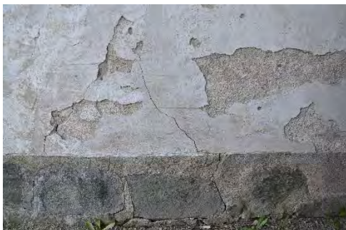
Figur 42. Detalj av inre östra fasaden visar putsavfall och sprickor. Foto: Tobias Mårud.
