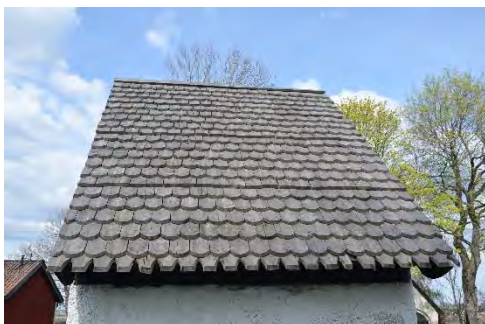
Figur 10. Södra takfallet. Foto: Tobias Mårud.
