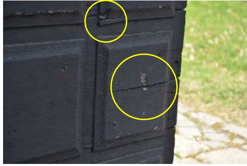
Figur 28. Mekanisk skada på norra dörrbladets utsida. Foto: Tobias Mårud.
