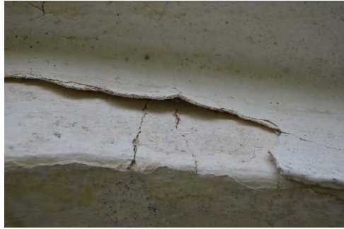
Figur 44. Avfärgning släpper från slätputsade ytor. Foto: Tobias Mårud.
