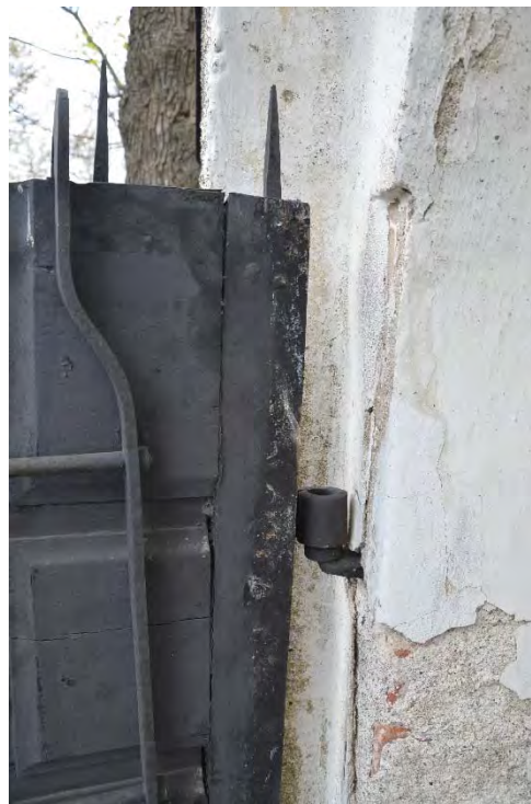
Figur 51. Mögel och rost från kontakt med fasaden, östra dörrbladet. Foto: Tobias Mårud.
