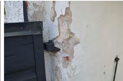
Figur 16. Putsskada som visar på minst nio skikt med puts och avfärgning. Foto: Tobias Mårud.
