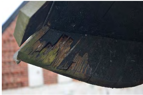
Figur 14. Rötskada i nordöstra vindskivans avslut. Foto: Tobias Mårud.
