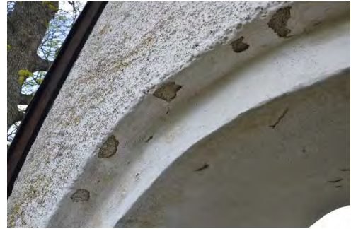
Figur 44. Avfärgning släpper från slätputsade ytor. Foto: Tobias Mårud.
