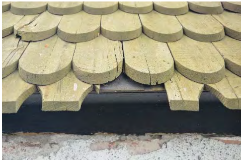
Figur 38. Det är främst i nederkant av taket som skadade spån förekommer, här på östra takfallet. Foto: Tobias Mårud.
