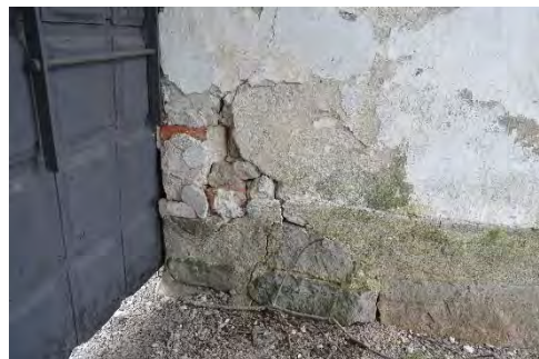
Figur 42. Detalj av inre östra fasaden visar putsavfall och sprickor. Foto: Tobias Mårud.
