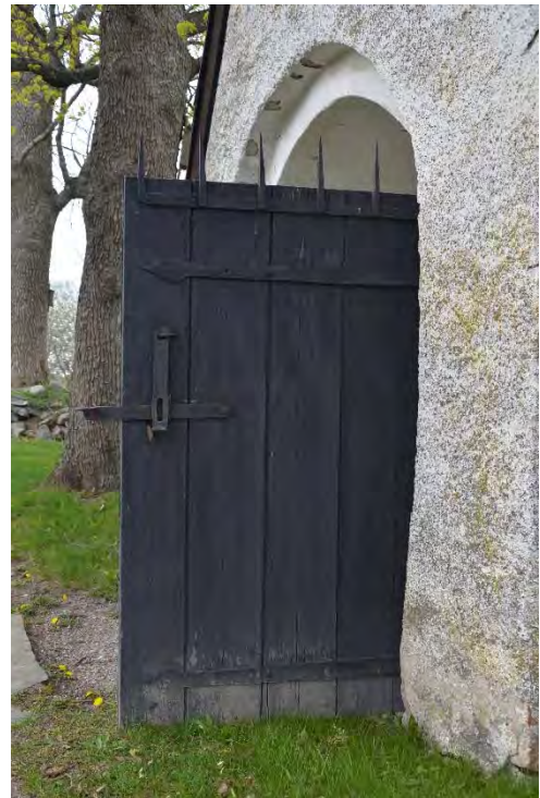
Figur 48. Västra dörrbladets insida. Observera smutsningen från regnstänk i nederkant. Foto: Tobias Mårud.
