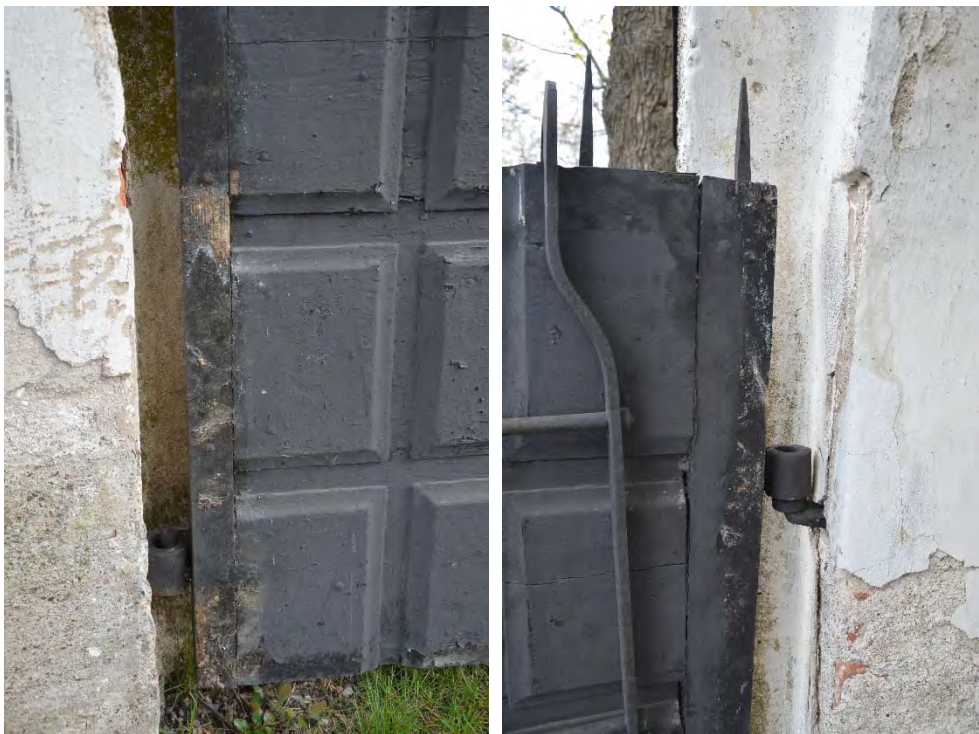
Figur 51. Mögel och rost från kontakt med fasaden, östra dörrbladet. Foto: Tobias Mårud.
