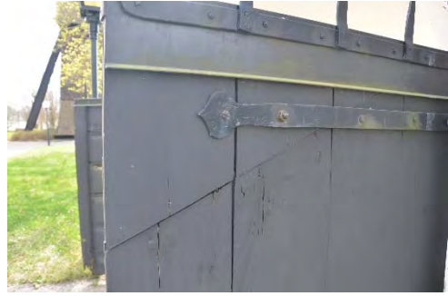
Figur 28. Mekanisk skada på norra dörrbladets utsida. Foto: Tobias Mårud.
