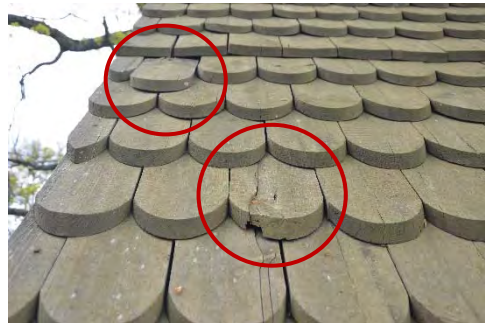
Figur 38. Det är främst i nederkant av taket som skadade spån förekommer, här på östra takfallet. Foto: Tobias Mårud.
