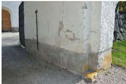
Figur 18. KC-putsen i sockeln orsakar skador i det övre väggfältets kalkputs. Foto: Tobias Mårud.
