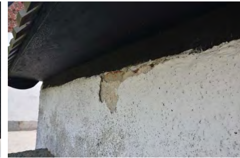
Figur 14. Rötskada i nordöstra vindskivans avslut. Foto: Tobias Mårud.
