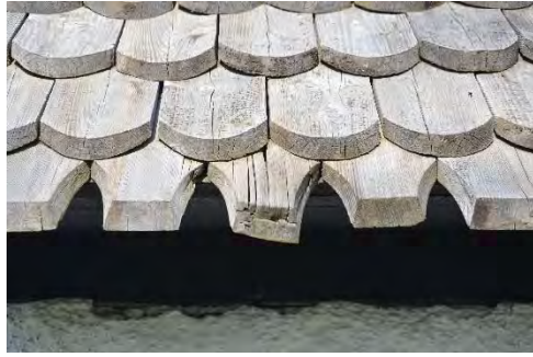
Figur 12. Exempel på ett av få skadade takspån, detta på södra takfallet. Foto: Tobias Mårud.
