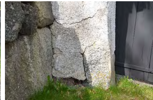
Figur 18. KC-putsen i sockeln orsakar skador i det övre väggfältets kalkputs. Foto: Tobias Mårud.
