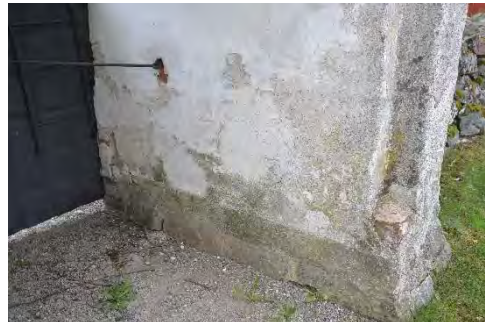
Figur 40. Den inre östra fasaden, med fogstruken sockel. Foto: Tobias Mårud.
