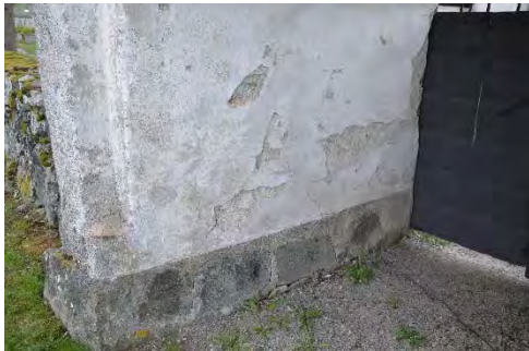
Figur 40. Den inre östra fasaden, med fogstruken sockel. Foto: Tobias Mårud.
