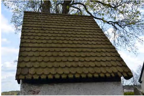
Figur 36. Västra takfallet. Foto: Tobias Mårud.
