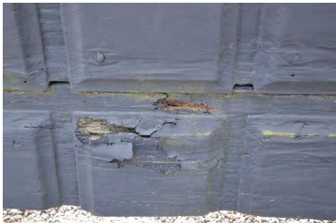
Figur 24. Detalj av södra dörrbladets utsida med färg som skapar bubblor och släpper samt underliggande (torr) rötskada. Foto: Tobias Mårud.
