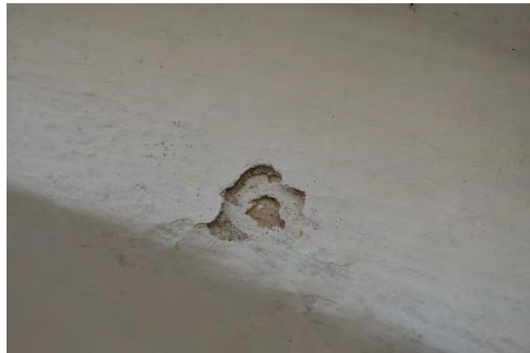
Figur 16. Putsskada som visar på minst nio skikt med puts och avfärgning. Foto: Tobias Mårud.
