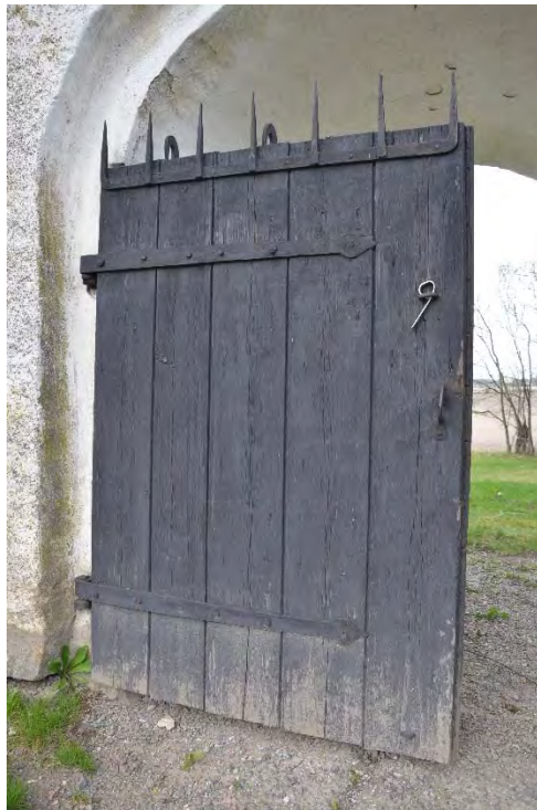
Figur 48. Västra dörrbladets insida. Observera smutsningen från regnstänk i nederkant. Foto: Tobias Mårud.
