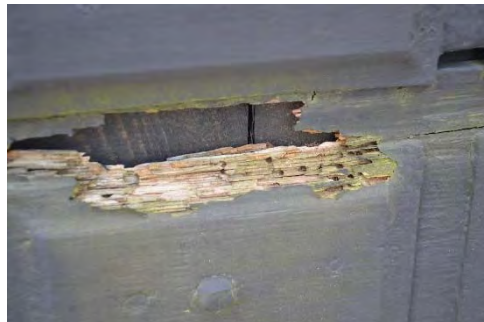
Figur 24. Detalj av södra dörrbladets utsida med färg som skapar bubblor och släpper samt underliggande (torr) rötskada. Foto: Tobias Mårud.
