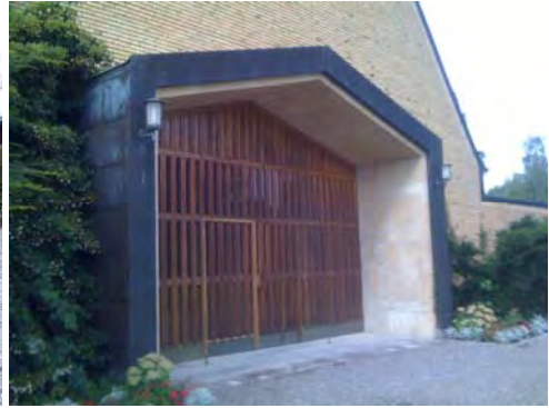
Figur 24. Stora entrén belyses inifrån för att undvika uppsättning av nya armaturer exteriört. Foto: Helén Sjökvist.
