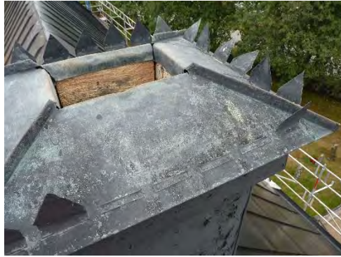
Figur 34 & 35. Plåtbeslagningen av skorstenens krön uppvisade en del mekaniska skador och glipande skarvar. Den invändigt nedtill igenmurade röckanalen saknade nästan helt fogbruk och rester av fågelreden fanns i botten. Foto: Tobias Mårud.
