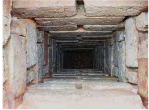
Figur 34 & 35. Plåtbeslagningen av skorstenens krön uppvisade en del mekaniska skador och glipande skarvar. Den invändigt nedtill igenmurade röckanalen saknade nästan helt fogbruk och rester av fågelreden fanns i botten. Foto: Tobias Mårud.
