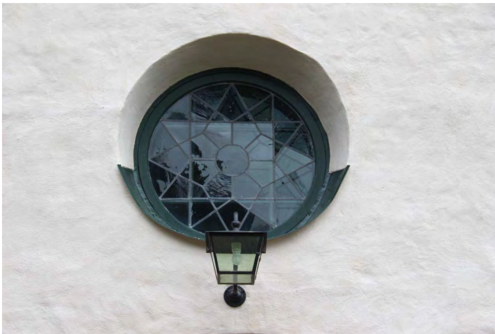
Figur 49. Västra gavelns fönster och armatur efter åtgärd. Foto: Tobias Mårud.
