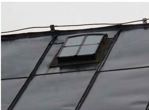
Figur 40, 41 & 42. Ny takstege monterades på vaktmästarkontorets västra takfall, stegen på östra takfallet togs bort, och en ny stege ersatte den tidigare på långhusets södra takfall (vänstra bilden). Ett av långhusets två äldre takfönster på norra takfallet, innan och efter åtgärd (de två bilderna till höger). Foto: Tobias Mårud.
