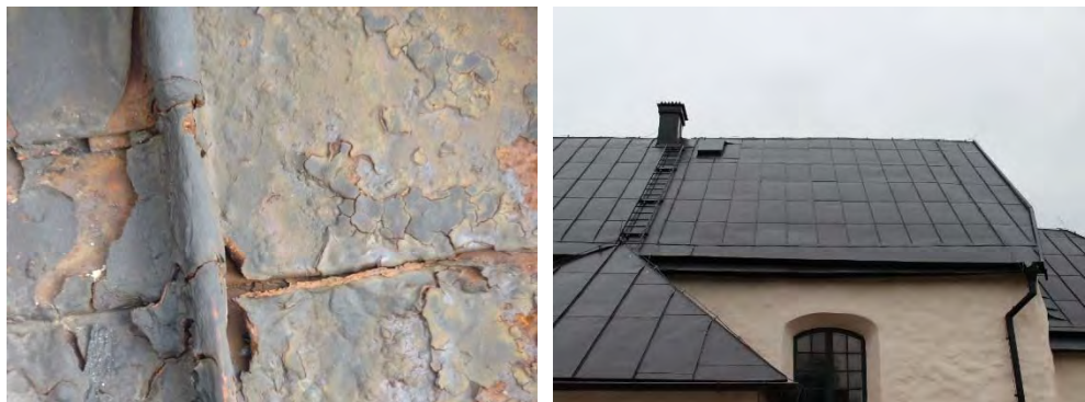
Figur 26 & 27. Detalj av takplåten innan åtgärd (vänster bild). Det omlagda taket, med sakristian skymtande till höger och vaktmästarkontorets södra takfall i förgrunden till vänster. Foto: Helén Sjökvist och Tobias Mårud.
