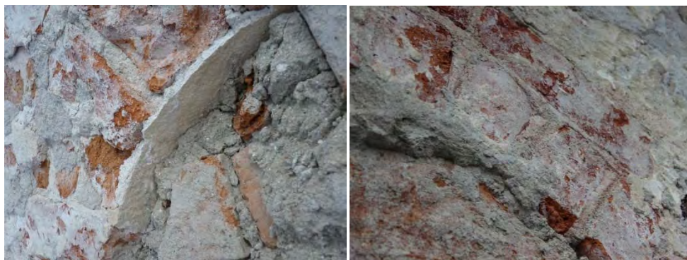
Figur 63 & 64. Puts-skikt från tidigare omfattning på befintligt fönster (vänster bild). Omfattningen till det igenmurade fönstret i långhusets södra fasad uppvisar stora likheter med omfattningen till vapenhusets portal med åsfogar, ristningar och kvadermålad puts. Foto: Tobias Mårud och Lisa Skanser.
