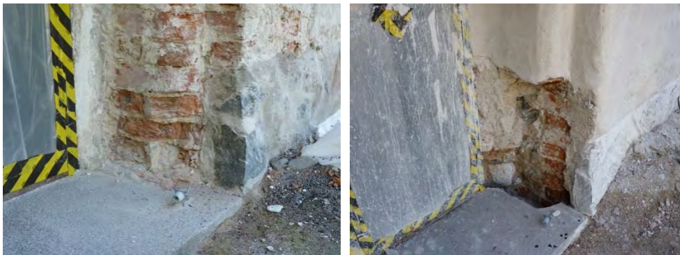
Figur 18 & 19. Västportalens södra sida efter friläggning av murverket (bilden till vänster). Högra bilden visar samma del efter avlägsnande av skadat tegel. Foto: Tobias Mårud.
