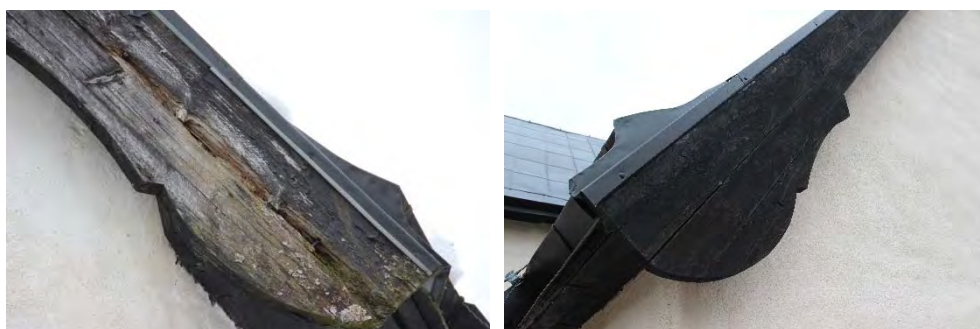
Figur 43 & 44. Exempel på vindskivor innan och efter åtgärd. Vänstra bilden visar vindskivan från norra sidan av långhusets östra gavel innan åtgärd och högra bilden vindskivan på västra sidan av vapenhusets gavel efter åtgärd. Foto: Tobias Mårud.
