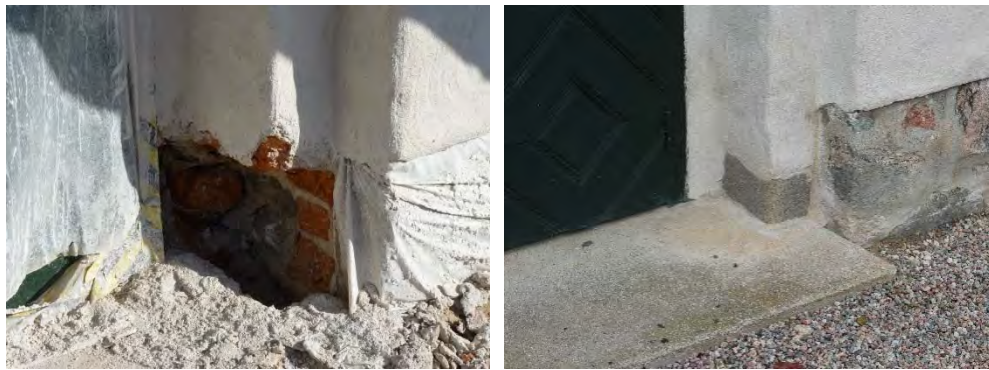
Figur 24 & 25. Östra sidan av vapenhusets portal efter avlägsnande av skadat tegel och efter genomförda åtgärder. Foto: Tobias Mårud.
