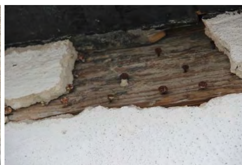
Figur 15, 16 & 17. Utmed takfoten i fasadernas överkant löper putsbärare i form av träreglor. Dessa var innan åtgärd antingen klädda med en vassmatta (bilden till vänster) eller så var spikar inslagna för att få fäste för putsen (bilden till höger). Här hade putsen drabbats av omfattande sprickbildning. Träreglarna frilades från vassmattan, spikarna avlägsnades, virket täcktes med byggpapp och armeringsnät varefter det putsades. Foto: Lisa Skanser & Tobias Mårud
