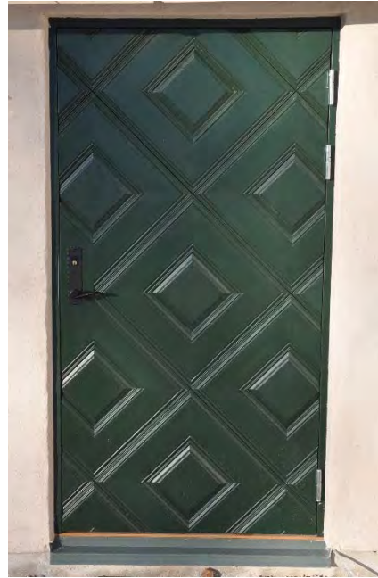
Figur 50 & 51. Södra delen av dörröppningen i vaktmästarkontorets östra fasad var tidigare igensatt med en trävägg, den revs och istället uppfördes en murad vägg av tegel i samma bredd som murverket i övrigt. I den egentliga dörröppningen monterades en ny dörr utformad med tanke på kyrkans andra två entréer. Foto: Tobias Mårud.
