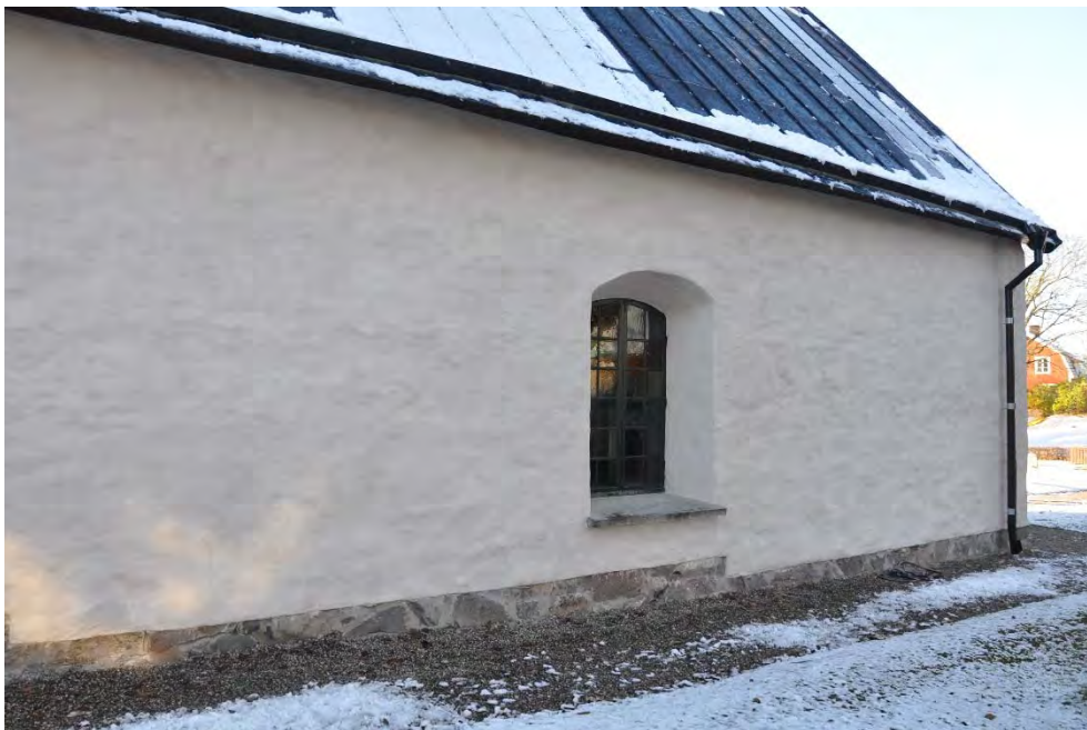
Figur 12. Med slevdragen puts framträder murverket och skapar en levande fasad. Bilden visar en nyputsad men ännu ej anfärgad fasad. Foto: Tobias Mårud.
