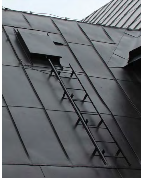
Figur 38 & 39. Takluckan på vapenhusets östra takfall var försedd med en opassande hög sarg, detta åtgärdades, resultatet syns på högra bilden. Foto: Tobias Mårud.
