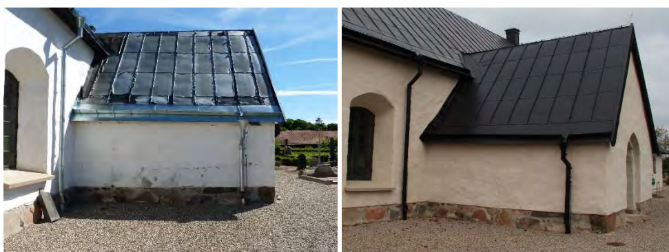
Figur 32 & 33. Vapenhusets västra takfall innan och efter åtgärd. Foto: Tobias Mårud.
