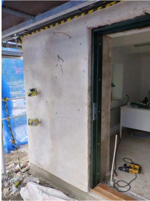
Figur 50 & 51. Södra delen av dörröppningen i vaktmästarkontorets östra fasad var tidigare igensatt med en trävägg, den revs och istället uppfördes en murad vägg av tegel i samma bredd som murverket i övrigt. I den egentliga dörröppningen monterades en ny dörr utformad med tanke på kyrkans andra två entréer. Foto: Tobias Mårud.
