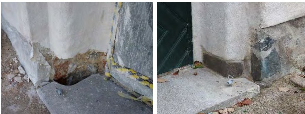
Figur 20 & 21. Västportalens norra sida efter avlägsnande av skadat tegel (bilden till vänster). Den profilhuggna sockelstenen sitter på plats och murverket är putsat. Foto: Tobias Mårud.
