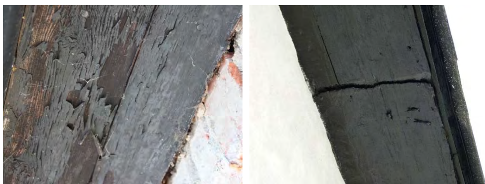
Figur 45 & 46. Takfotsbräda målad med felaktig färg (vänster bild) vilken skrapades bort varefter de målades med pigmenterad tjära (höger bild). Foto: Tobias Mårud.
