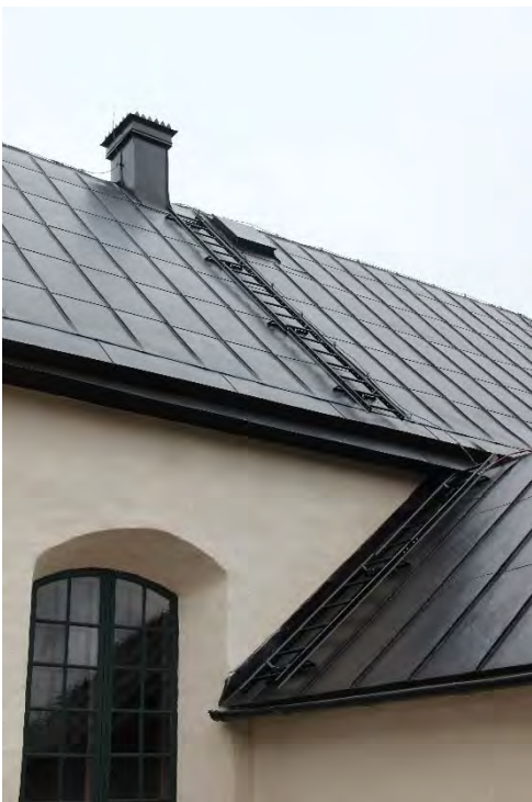
Figur 40, 41 & 42. Ny takstege monterades på vaktmästarkontorets västra takfall, stegen på östra takfallet togs bort, och en ny stege ersatte den tidigare på långhusets södra takfall (vänstra bilden). Ett av långhusets två äldre takfönster på norra takfallet, innan och efter åtgärd (de två bilderna till höger). Foto: Tobias Mårud.
