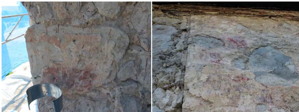
Figur 58 & 59. Kvaderimitation på sakristians nordöstra hörn (vänster bild) och vid byggskearv som tidigare var långhusets nordöstra hörn(höger bild). Foto: Lisa Skanser.
