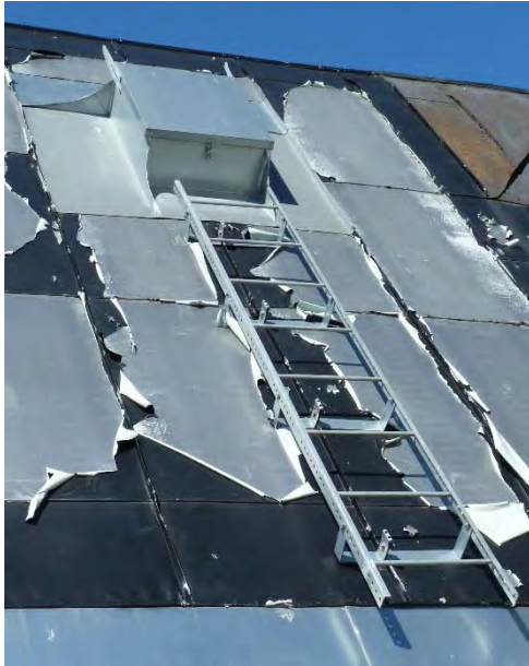
Figur 38 & 39. Takluckan på vapenhusets östra takfall var försedd med en opassande hög sarg, detta åtgärdades, resultatet syns på högra bilden. Foto: Tobias Mårud.
