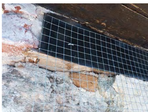
Figur 15, 16 & 17. Utmed takfoten i fasadernas överkant löper putsbärare i form av träreglor. Dessa var innan åtgärd antingen klädda med en vassmatta (bilden till vänster) eller så var spikar inslagna för att få fäste för putsen (bilden till höger). Här hade putsen drabbats av omfattande sprickbildning. Träreglarna frilades från vassmattan, spikarna avlägsnades, virket täcktes med byggpapp och armeringsnät varefter det putsades. Foto: Lisa Skanser & Tobias Mårud
