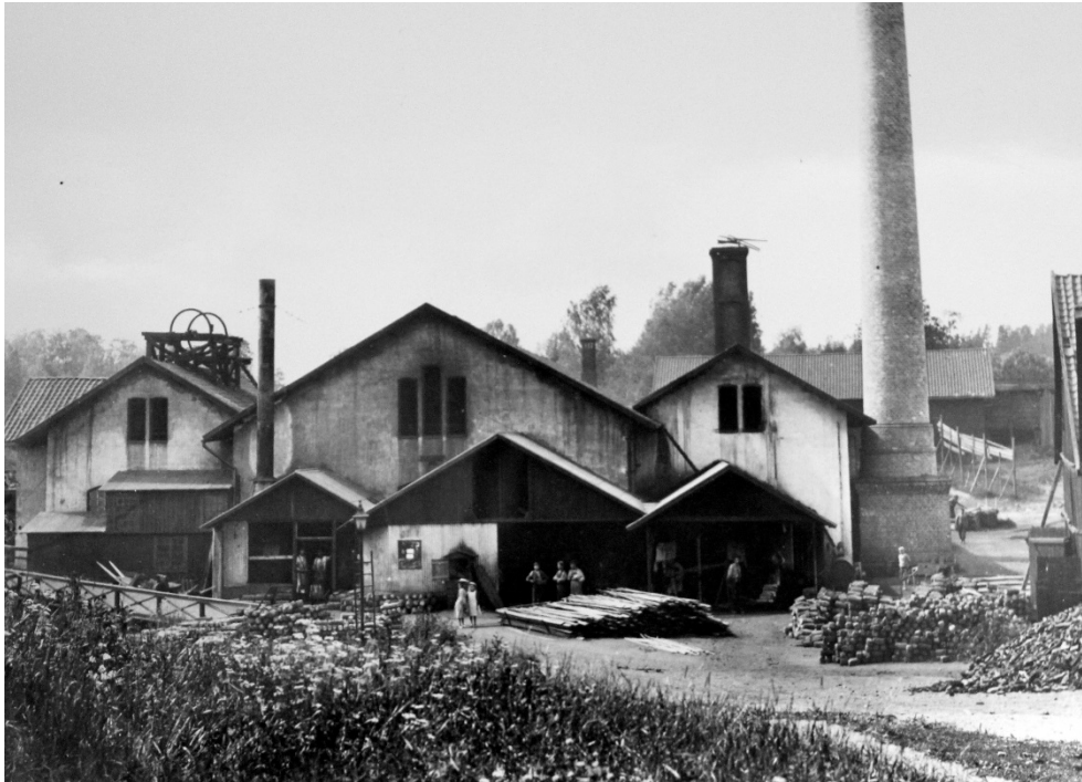
Figur 6. Hammarsmedjan sedd från sydöst 1923. Källa: ATA.
