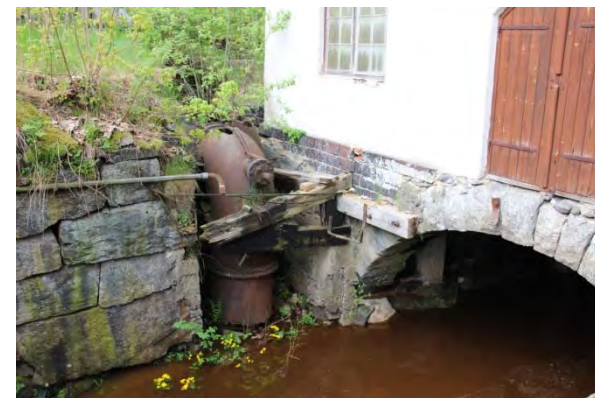
Rest av turbin vid blåsmaskinshuset sydöstra gavel
