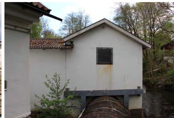
Nordvästra gaveln med tubens infästning
