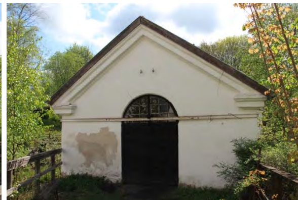
Nordvästra gaveln med entré
