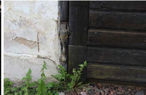
Lagning på dörr och putssläpp på fasad
