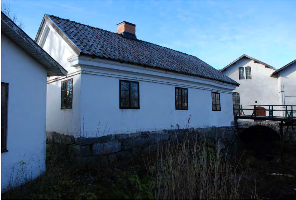
Figur 14. Klensmedjans nordöstra fasad med kraftstationen till vänster och hammarsmedjan till höger i bild. Foto: Tobias Mårud.
