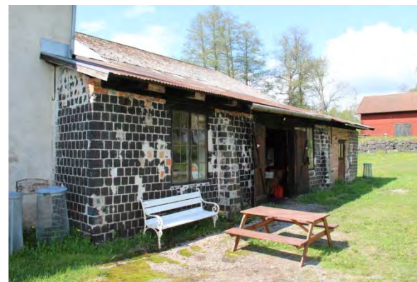
Östra inlastningsrummet sett från öster
