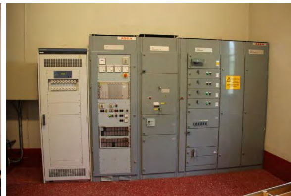
Del av kontorsdelens nordvästra vägg
