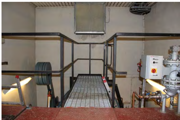
Turbindelens nordvästra vägg
