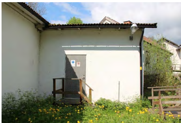
Kontorsdelens sydöstra fasad
