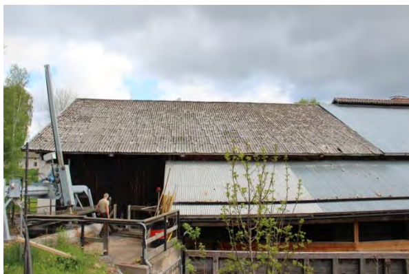
Asbestcementplattor, sydvästra takfallet
