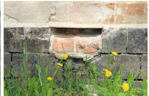
Lagning med tegel i skorstenens kondenskanal
