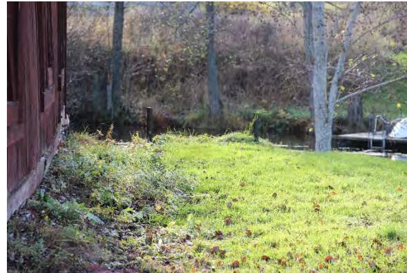
Tågstopp vid kolhusets nordvästra fasad
