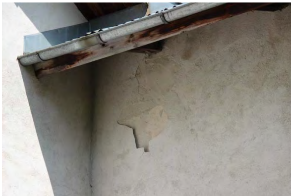
Putsen släpper, sydöstra gavelns sydvästra fasad
