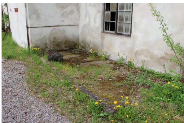
Gjuten platta vid sydöstra gaveln
