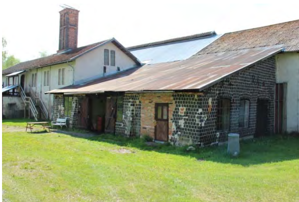
Östra inlastningsrummet sett från norr
