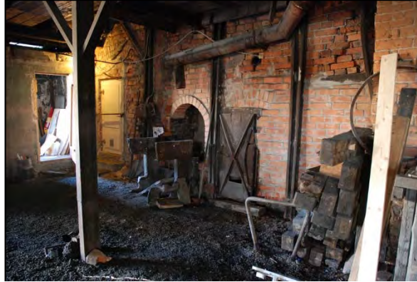
Gnisterkammarens norra vägg med resterna av en av de två lancashirehårdarna från 1899
