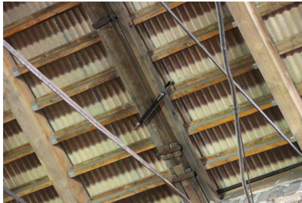
Förstärkning av bevarad polonceau-takstol
