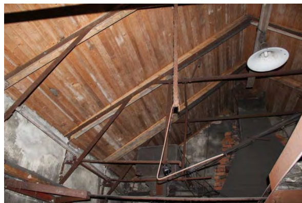
Nytt undertak, takstolar av bandjárn och trä
