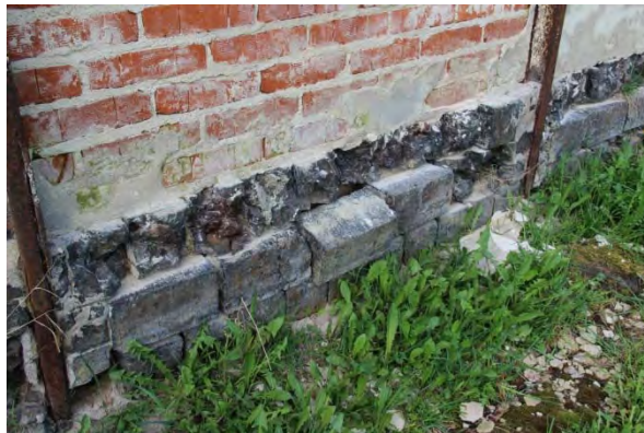
Slaggsten på väg ut ur grundmuren
