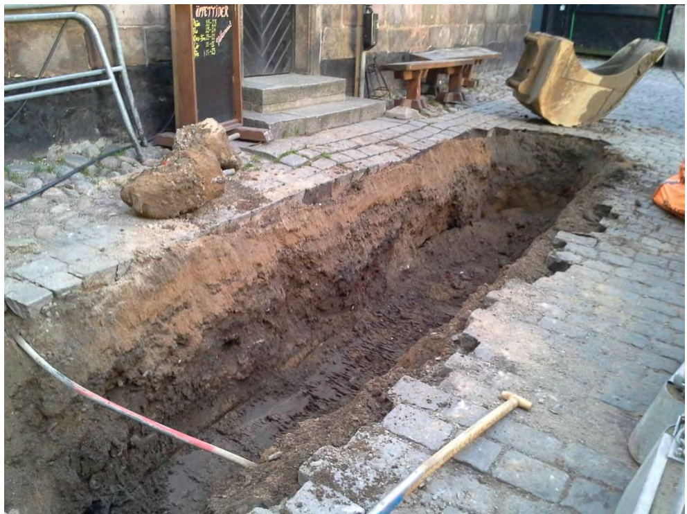
Figur 4. Schakt längs museets sydsida. Foto mot O av Kristina Jonsson.
