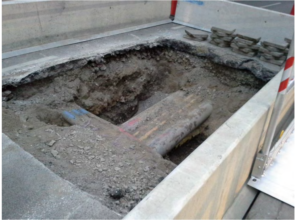
Figur 3. Schakt i Sibyllegatan. Foto mot N av Kristina Jonsson.
