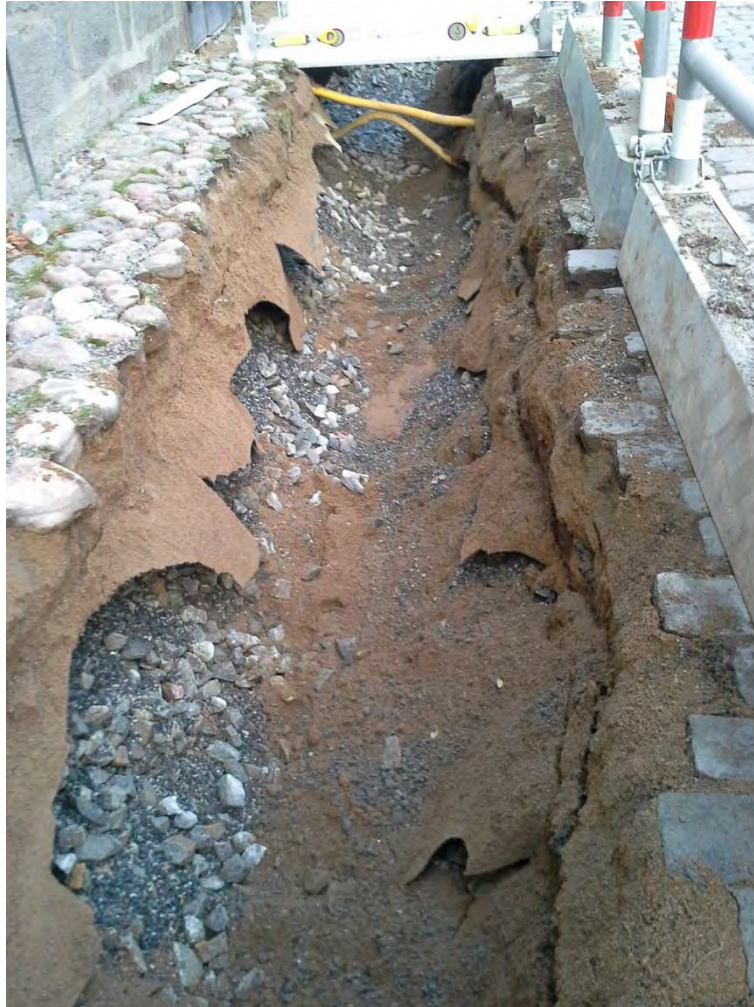
Figur 5. Schakt längs museets östra vägg. Foto mot NNO av Kristina Jonsson.
