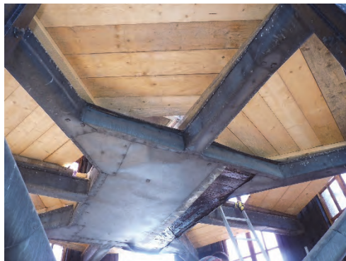
Figur 38. Demonterad plåt från plattform. Virket har tjärats efter demontering. Foto: Helén Sjökvist.
