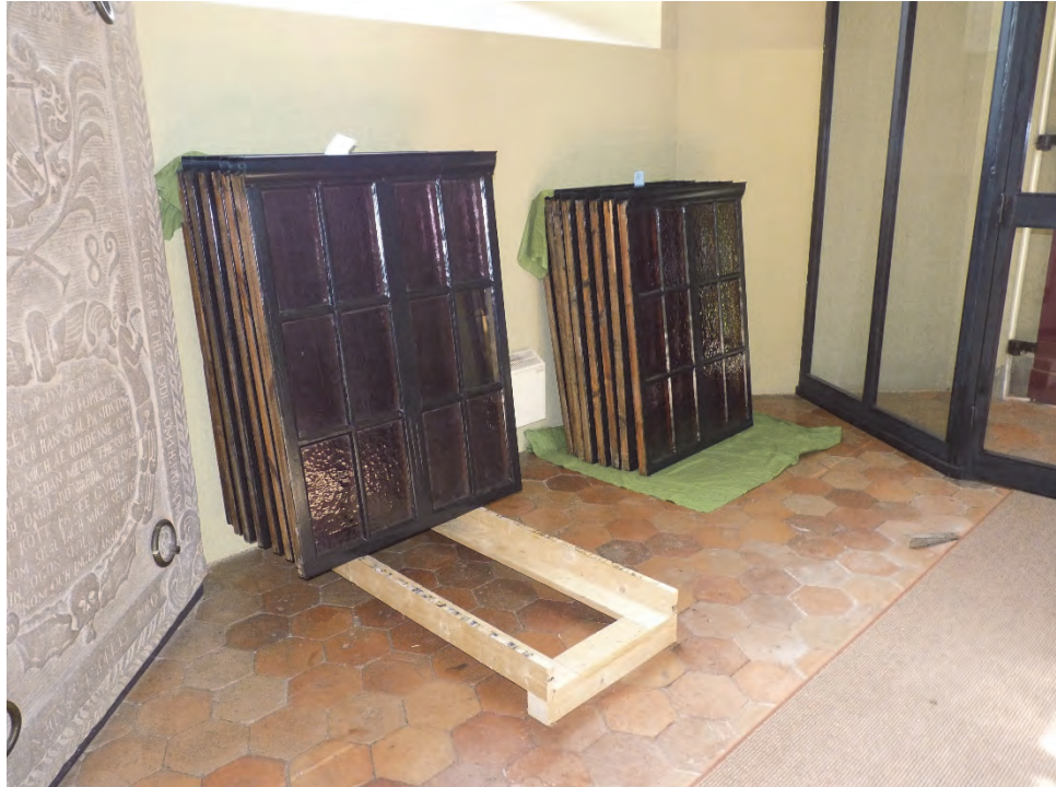
Figur 24. Färdigstrukna fönsterbågar inför återmontering. Foto: Helén Sjökvist.
