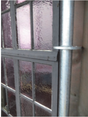
Figur 31. Tidigare befintliga droppbleck mellan bågarna. Foto: Helén Sjökvist.
