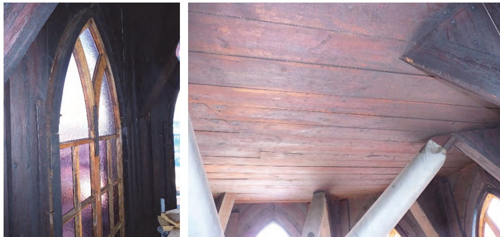
Figur 29. Färdigställt fönster. Foto: Helén Sjökvist.
