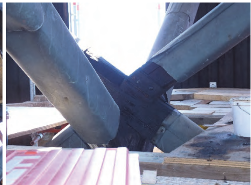
Figur 38. Demonterad plåt från plattform. Virket har tjärats efter demontering. Foto: Helén Sjökvist.
