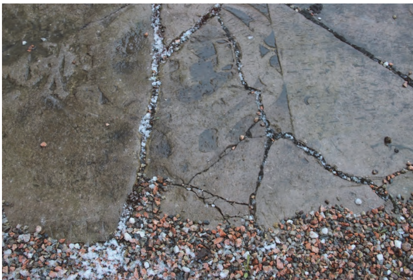
Figur 8. Hällen sedd från öster före åtgärder. Delar av stenen har ett tätt sprickmönster. Foto: Helén Sjökvist.
