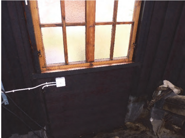
Figur 19. Renoverad fönsterbåge och tjärad panel. Foto: Helén Sjökvist.
