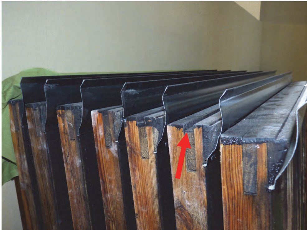
Figur 18. Spår för eklisten, samt nya droppbleck i plåt. Foto: Helén Sjökvist.
