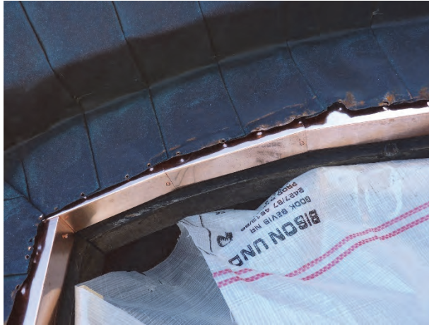
Figur 31. Tidigare befintliga droppbleck mellan bågarna. Foto: Helén Sjökvist.
