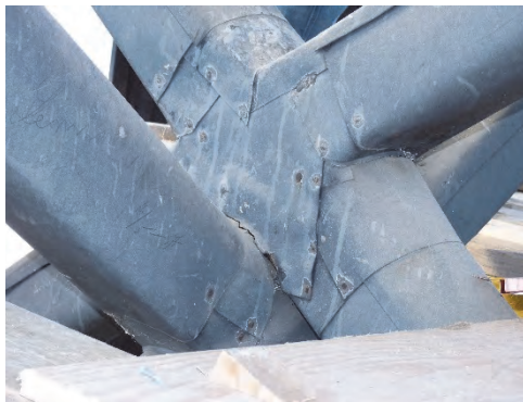
Figur 34. Plåtklädd plattform före åtgärder. Foto: Helén Sjökvist.
