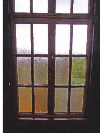
Figur 20. Renoverad fönsterbåge med en klarglasruta. Foto: Helén Sjökvist.
