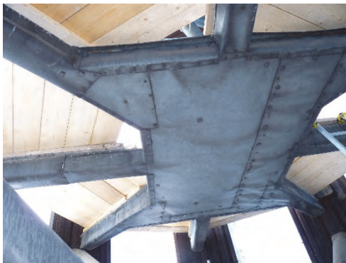
Figur 34. Plåtklädd plattform före åtgärder. Foto: Helén Sjökvist.
