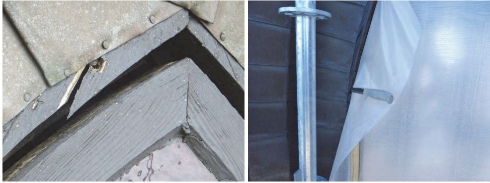
Figur 14. Spricka i karmens övre del. Foto: Helén Sjökvist.
