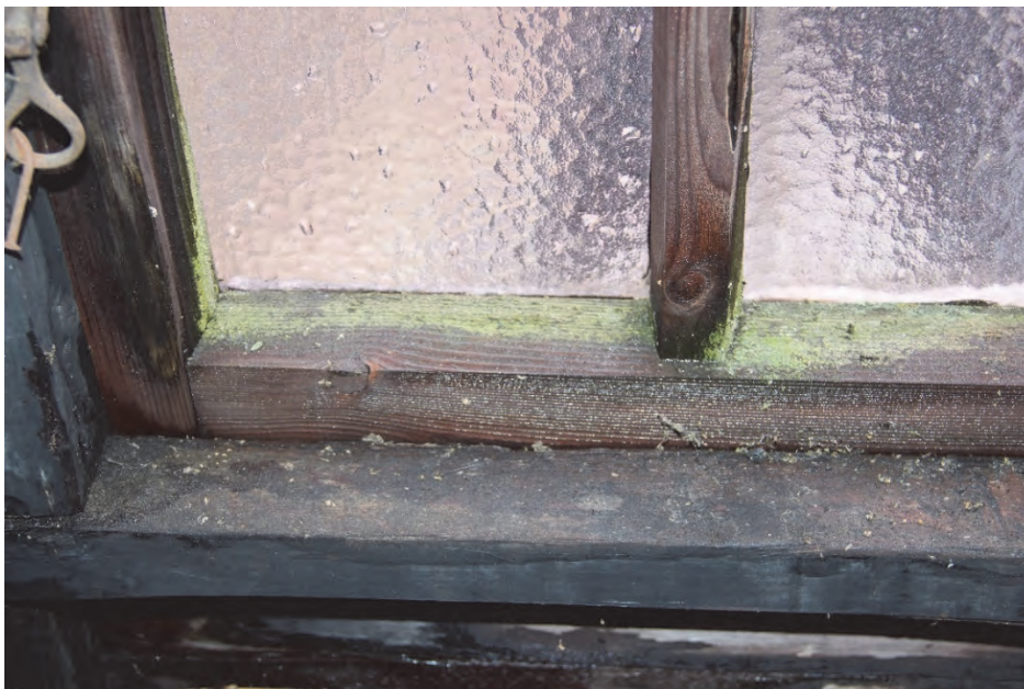
Figur 13. Fukthalten var mycket hög och det fanns omfattande påväxt av alger. Foto: Helén Sjökvist.
