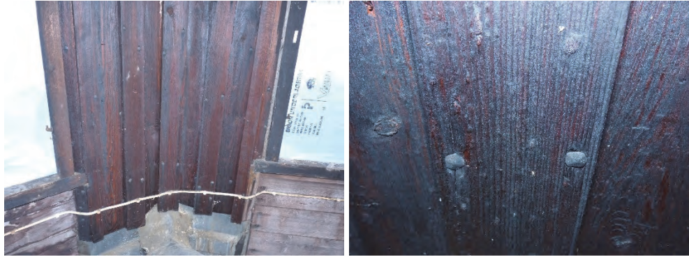
Figur 27. Tjärstruken panel före åtgärder. Foto: Helén Sjökvist.
