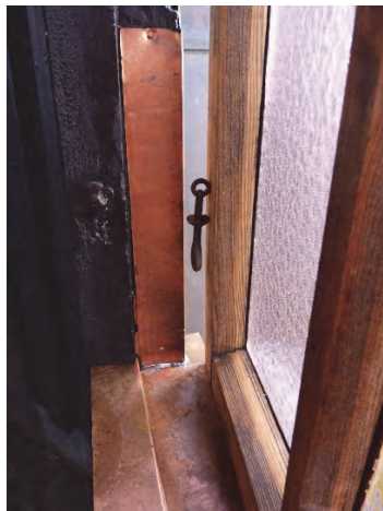
Figur 40. Ny koppertäckning av karmens bottenstycke. Foto: Helén Sjökvist.
