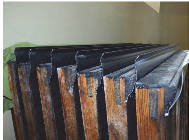
Figur 40. Ny koppertäckning av karmens bottenstycke. Foto: Helén Sjökvist.
