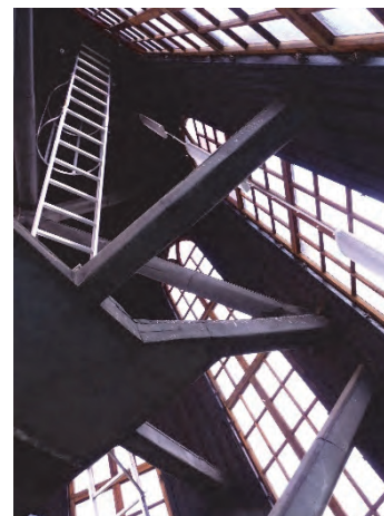
Figur 21. Bågens övre del efter renovering med extra säkring i överkanten. Foto: Helén Sjökvist.
