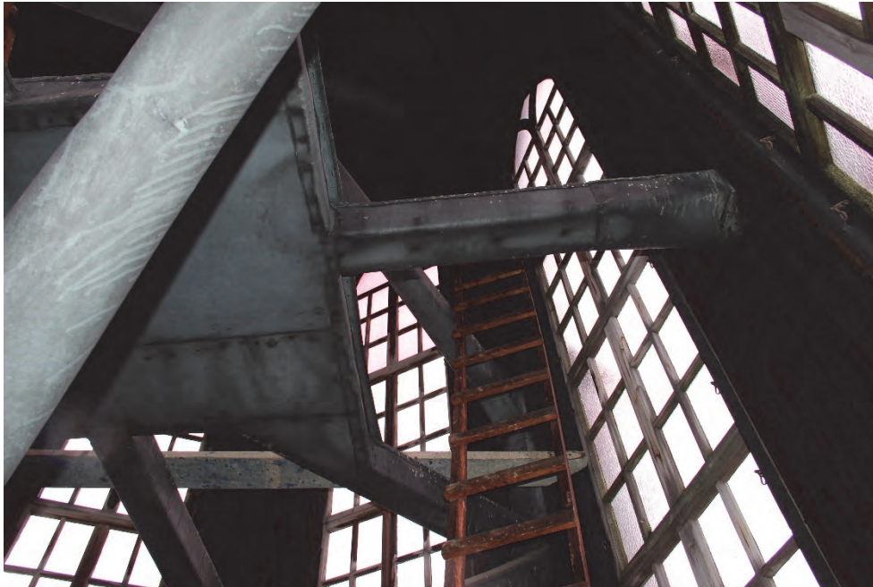
Figur 33. Den invändiga konstruktionen är plåtklädd p.g.a. att konstruktionen ursprungligen var öppen, utan fönsterbågar. Foto: Helén Sjökvist.
