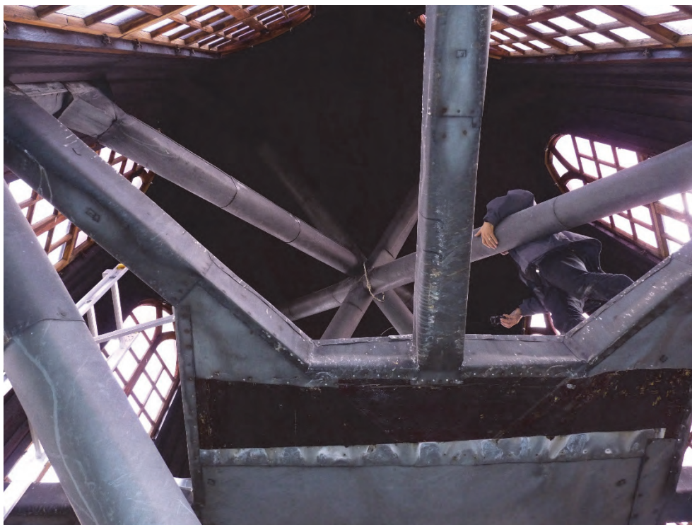
Figur 42. Den zinkplåtklädda konstruktionen efter åtgärder. Foto: Helén Sjökvist.
