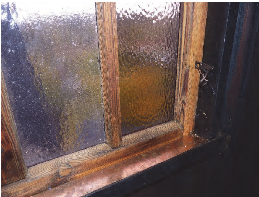
Figur 23. Fönsterhakarna var tänkta att bytas, men sparades av antikvariska skäl. Foto: Helén Sjökvist.
