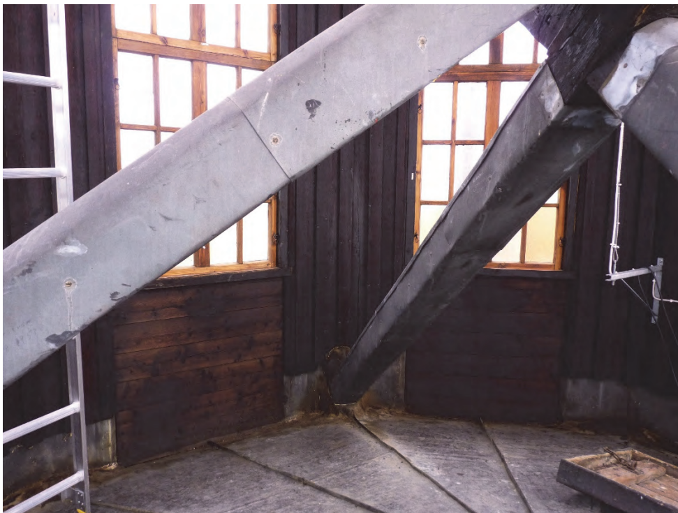
Figur 26. Området under fönstren efter åtgärder. Foto: Helén Sjökvist.
