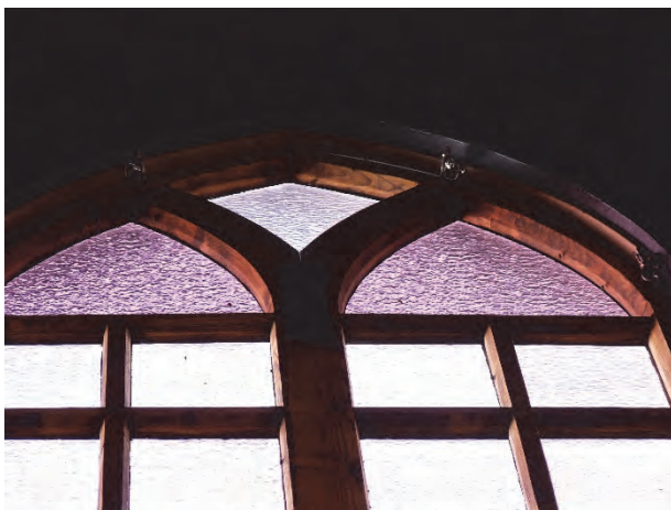
Figur 21. Bågens övre del efter renovering med extra säkring i överkanten. Foto: Helén Sjökvist.
