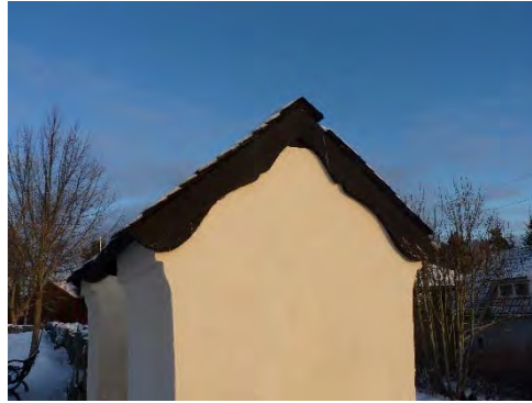
Figur 33 & 34. Grindstolparnas trädetaljer var delvis skadade. Exempel innan åtgärd. Foto: Tobias Mårud.
