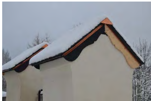
Figur 35 & 36. Huvarna åtgärdades på samma sätt som kyrktaket, resultatet blev en mer påtaglig visuell förändring då ytan på respektive huv är så liten. På bilderna har de bytta trädetaljerna ännu inte tjärats. Foto: Tobias Mårud.
