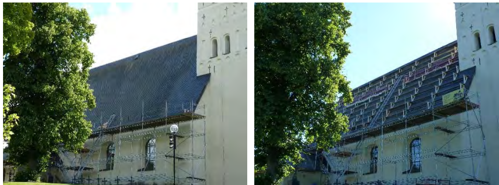
Figur 10 & 11. Ställning reses inför nedplockning av skiffer, arbetet påbörjades först på norra sidan. Foto: Tobias Mårud.
