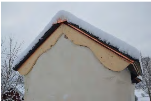
Figur 35 & 36. Huvarna åtgärdades på samma sätt som kyrktaket, resultatet blev en mer påtaglig visuell förändring då ytan på respektive huv är så liten. På bilderna har de bytta trädetaljerna ännu inte tjärats. Foto: Tobias Mårud.
