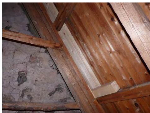
Figur 16 & 17. Även södra takfallets östra del uppvisade rötskador i underbrädningen, dock inte i samma omfattning. Infästningen av underbrädningens ersatta råspont fick stödjas med balkar. Foto: Tobias Mårud.
