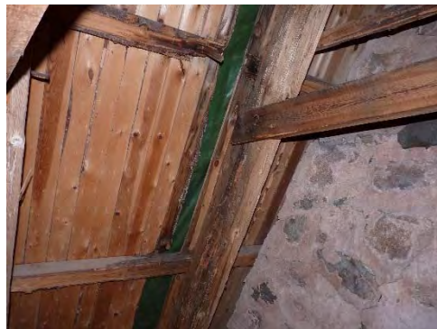
Figur 14 & 15. Rötskada i norra takfallets östra del. Skadad råspont avlägsnades och området täcktes i väntan på beslut om hur den delvis rötskadade takstolen skulle åtgärdas. Foto: Tobias Mårud.
