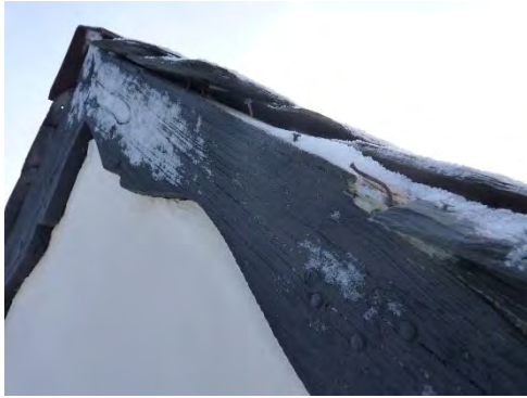
Figur 33 & 34. Grindstolparnas trädetaljer var delvis skadade. Exempel innan åtgärd. Foto: Tobias Mårud.
