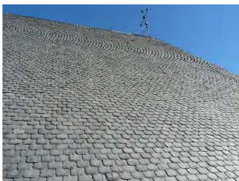
Figur 6. Södra takfallet innan åtgärd. Foto: Tobias Mårud.
