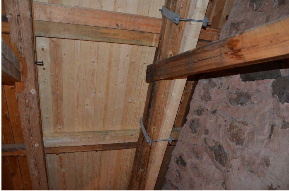
Figur 31. Två åsar fick delvis bytas, en förstärktes. Åsen i övre delen av bilden är bytt, kapad över andra takstolen österifrån, men även förstärkt. Den i bildens nedre del är förstärkt, huvudsakligen för att kunna fästa skarven för råsponten öster om högbenet. Foto: Tobias Mårud.
