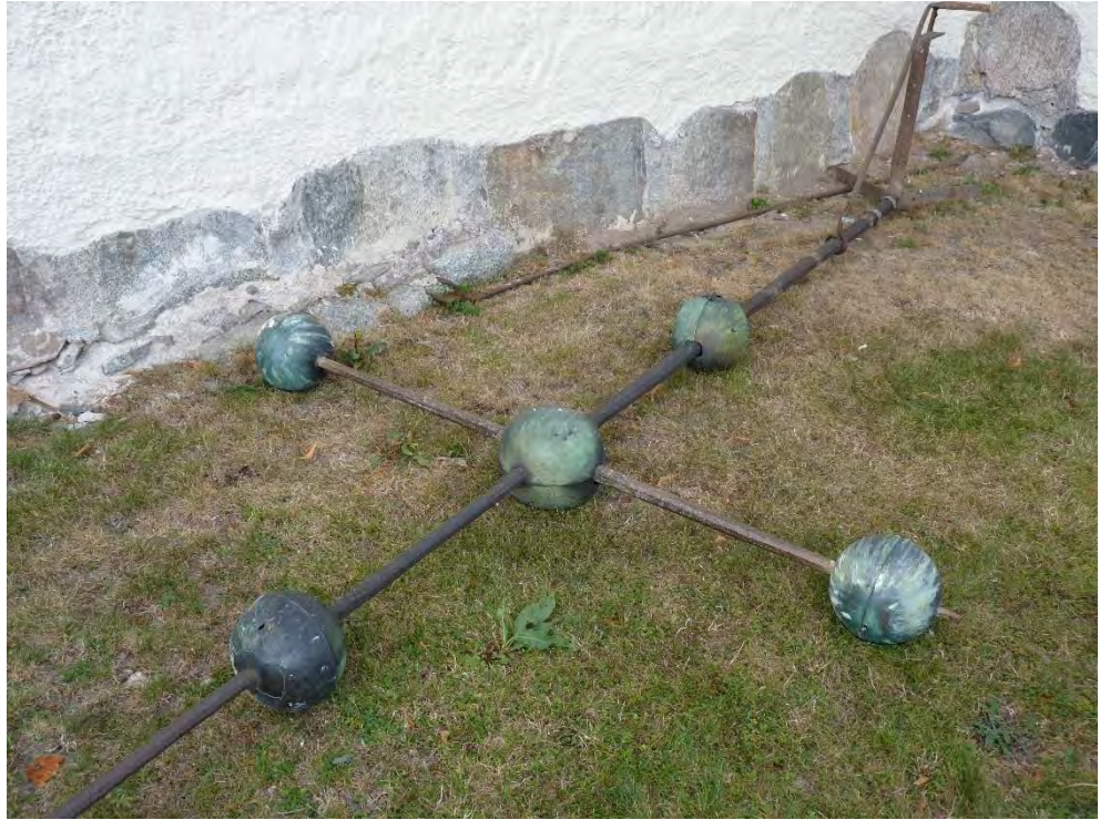
Figur 18. Nockprydnaden nedmonterad. Foto: Tobias Mårud.
