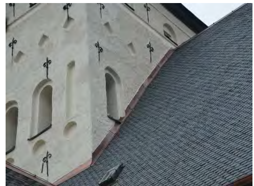
Figur 21 & 22. Den befintliga plåten ersattes med ny, här ståndplåten mot sydöstra delen av tornet. Foto: Tobias Mårud.
