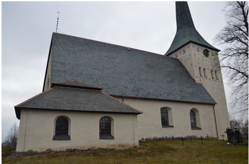
Figur 27. Takomläggningen är utförd, de nya koppardetaljerna är ännu tydliga med sin avvikande kulör men har redan börjat ärga och kommer snart att ha en mörkare, till taket bättre anpassad ton. Foto: Tobias Mårud.
