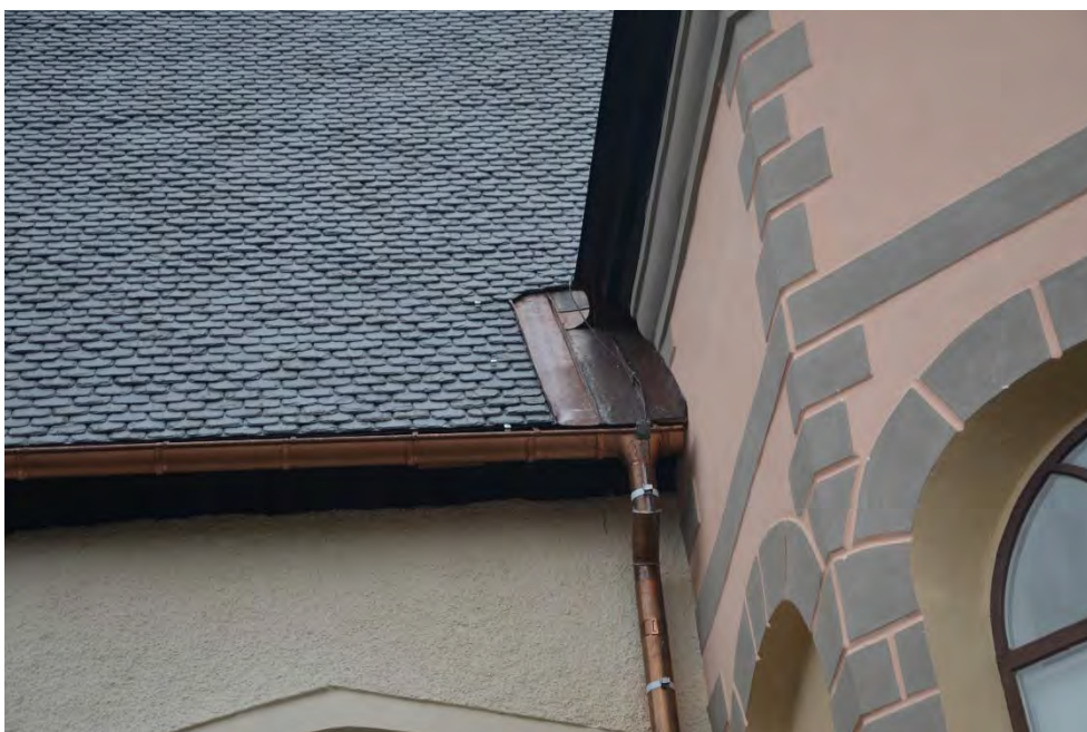
Figur 25. Den tillkommande plåten vänster om de ursprungliga, på västra sidan av gravkoret. Foto: Tobias Mård.
