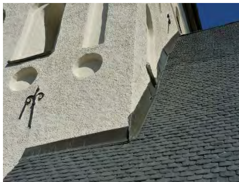
Figur 21 & 22. Den befintliga plåten ersattes med ny, här ståndplåten mot sydöstra delen av tornet. Foto: Tobias Mårud.
