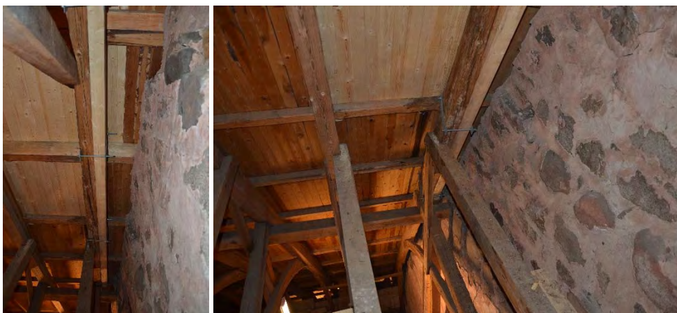
Figur 29 & 30. Skadad råspont har kapats vid närmaste ås för att kunna fästas. Foto: Tobias Mårud.
