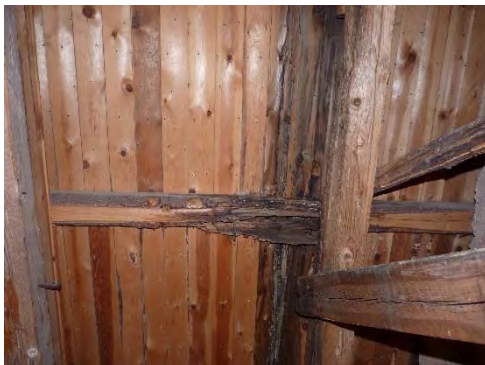
Figur 14 & 15. Rötskada i norra takfallets östra del. Skadad råspont avlägsnades och området täcktes i väntan på beslut om hur den delvis rötskadade takstolen skulle åtgärdas. Foto: Tobias Mårud.
