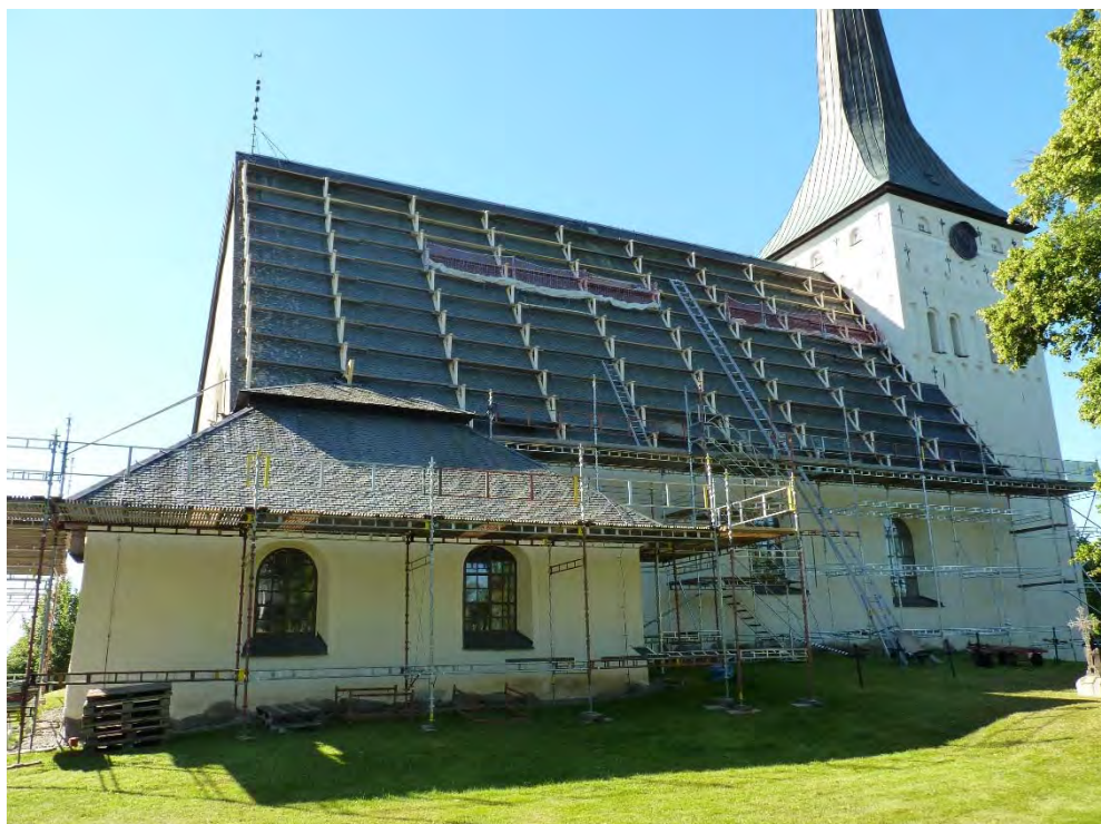
Figur 12. Ställningen färdigställd på norra takfallet. Foto: Tobias Mårud.
