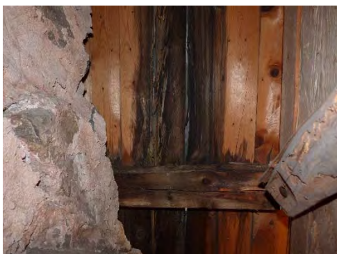
Figur 16 & 17. Även södra takfallets östra del uppvisade rötskador i underbrädningen, dock inte i samma omfattning. Infästningen av underbrädningens ersatta råspont fick stödjas med balkar. Foto: Tobias Mårud.
