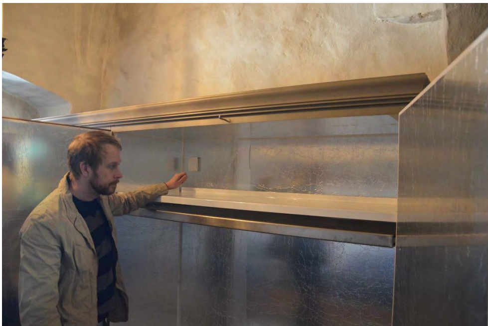
Figur 9. Henrik går igenom skåpets konstruktion och funktion. Spärrfolien täcker samtliga ytor invändigt. Foto: Tobias Mårud.
