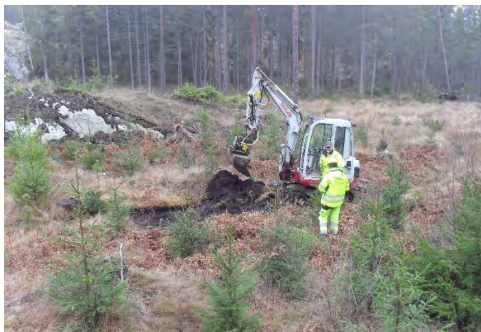
Figur 3. Dokumentation av schakt nr. 9. Fotograf H. Runeson
