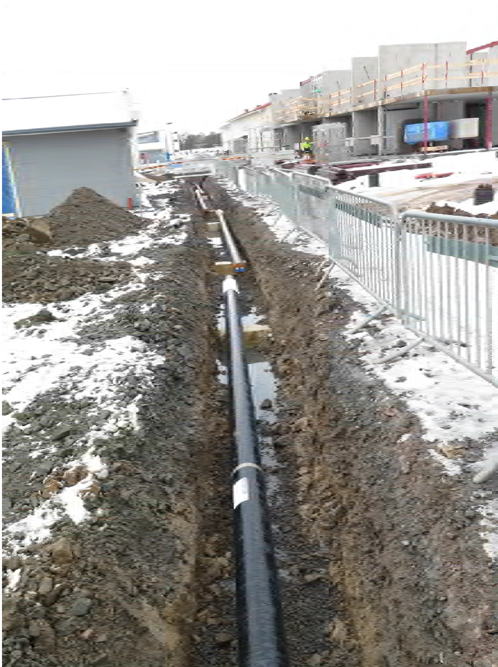
Figur 6. Västra halvan av den öst-västligt orienterade delen av fjärrvärmeschaktet från öster, vid efterkontrollen. Fjärrvärmeledningen har nu lagts ner i schaktet. Schaktet saknar här helt matjordslager. Foto: Mattias Johansson.
