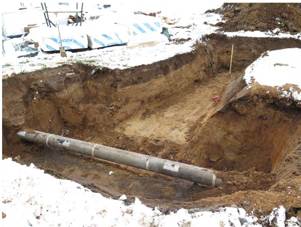
Figur 4. Den östra änden delen av fjärrvärmeschaktet från nordost. Närmast den framrensade befintliga fjärrvärmeledningen, där bortom schakt med bevarat matjordslager. Foto: Mattias Johansson.
