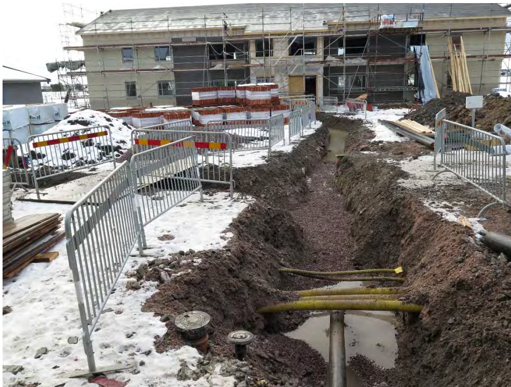
Figur 3. Den nord-sydligt orienterade, västra delen av fjärrvärmeschaktet från norr. Fotograferad från nordväst. Schaktet saknar här helt matjordslager. Foto: Mattias Johansson.
