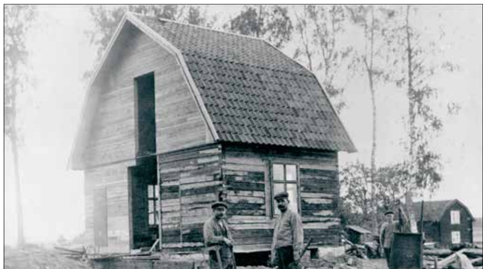
Figur 7. Det nya boningshuset under uppförande, troligen 1918. I mitten syns Oskar Ehn och till höger i bakgrunden skymtar det äldre torpet. Foto Emil Wjgård. Tillhör Badelunda hembygdsförening.
