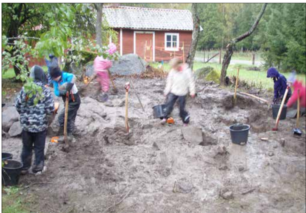
Figur 21. Grävning i full gång!
