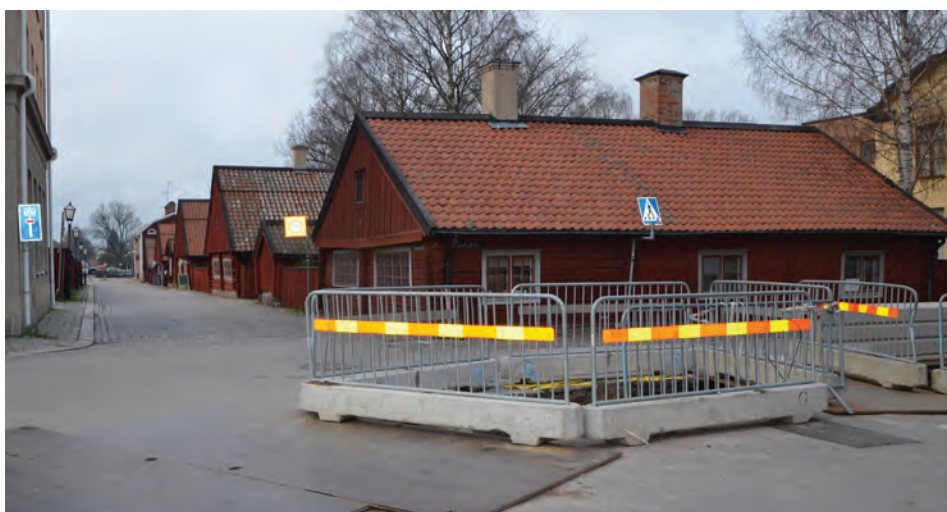
Figur 3. Det togs upp ett schakt i Bruksgatan intill Rademachersmedjorna. Den röda byggnaden närmast gatan är "Bergska smedjan". Fotograferat från sydöst av Jonas Ros.
