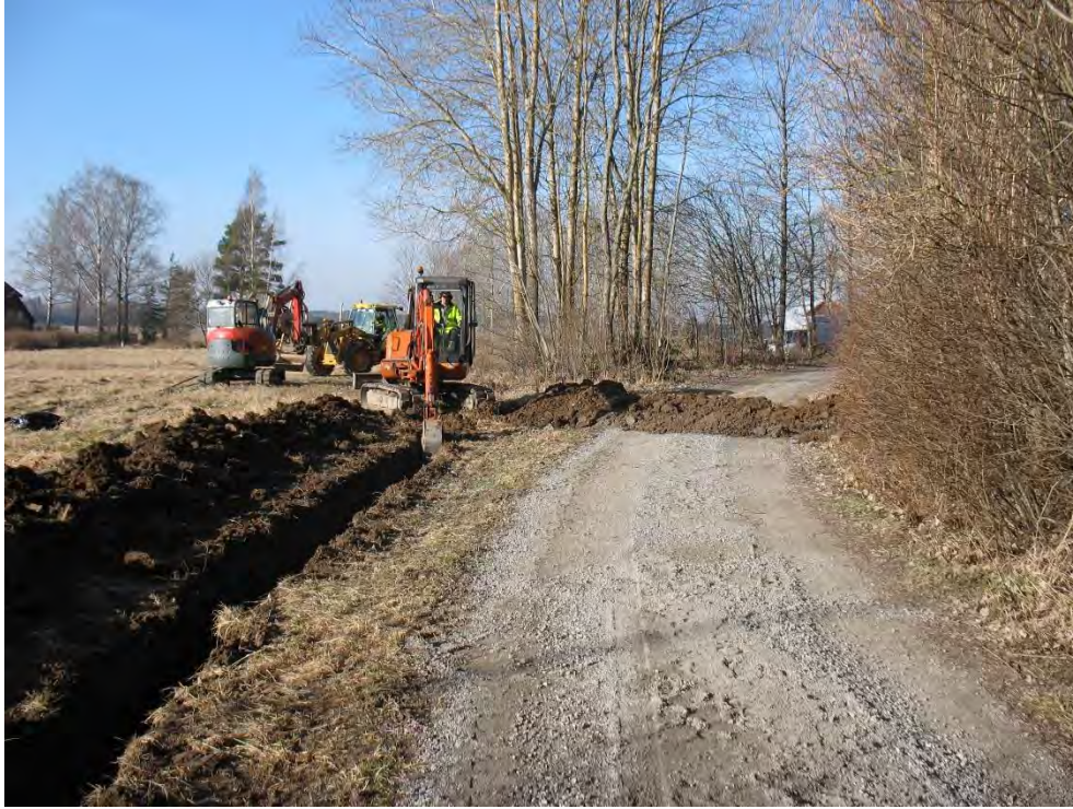
Figur 4. Schaktning för telekabel. Vy från NNO. Foto: Christian Gatti.
