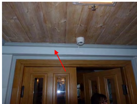
Figur 40. Ny träläda döljer kabeldragningar på västväggen. Foto: Helén Sjökvist.
