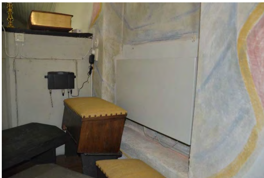
Figur 16. Radiator i predikstol, före åtgärder. Foto: Tobias Mårud.
