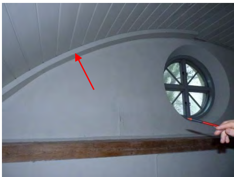
Figur 40. Ny träläda döljer kabeldragningar på västväggen. Foto: Helén Sjökvist.
