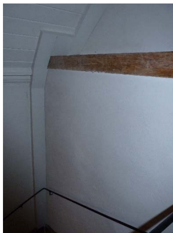
Figur 46. Ny kabelkanal från elcentralen. Foto: Helén Sjökvist.
