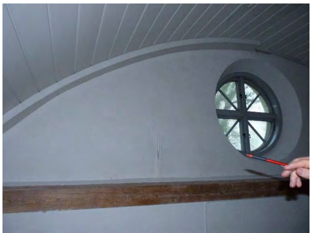
Figur 46. Ny kabelkanal från elcentralen. Foto: Helén Sjökvist.
