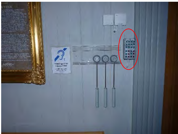
Figur 42. Manöverpanelen kom att placeras lite olyckligt vid omfattningen till västra entrén.. Foto: Helén Sjökvist.
