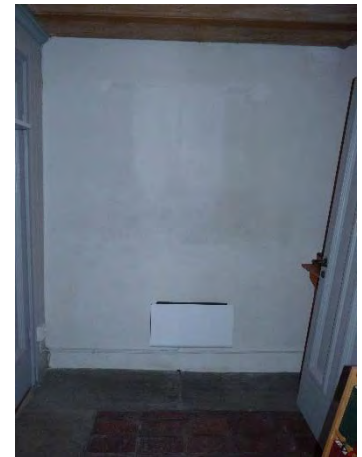
Figur 26. Ny radiator under läktaren, södra väggen. Foto: Helén Sjökvist.
