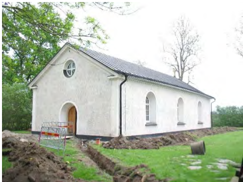
Figur 10. Schaktning omkring kyrkan. Foto: Jonas Ros.
