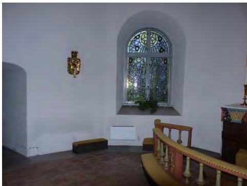
Figur 30. Ny radiator korets norra sida. Foto: Helén Sjökvist.
