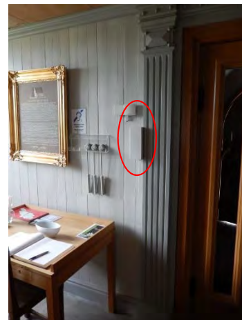
Figur 42. Manöverpanelen kom att placeras lite olyckligt vid omfattningen till västra entrén.. Foto: Helén Sjökvist.
