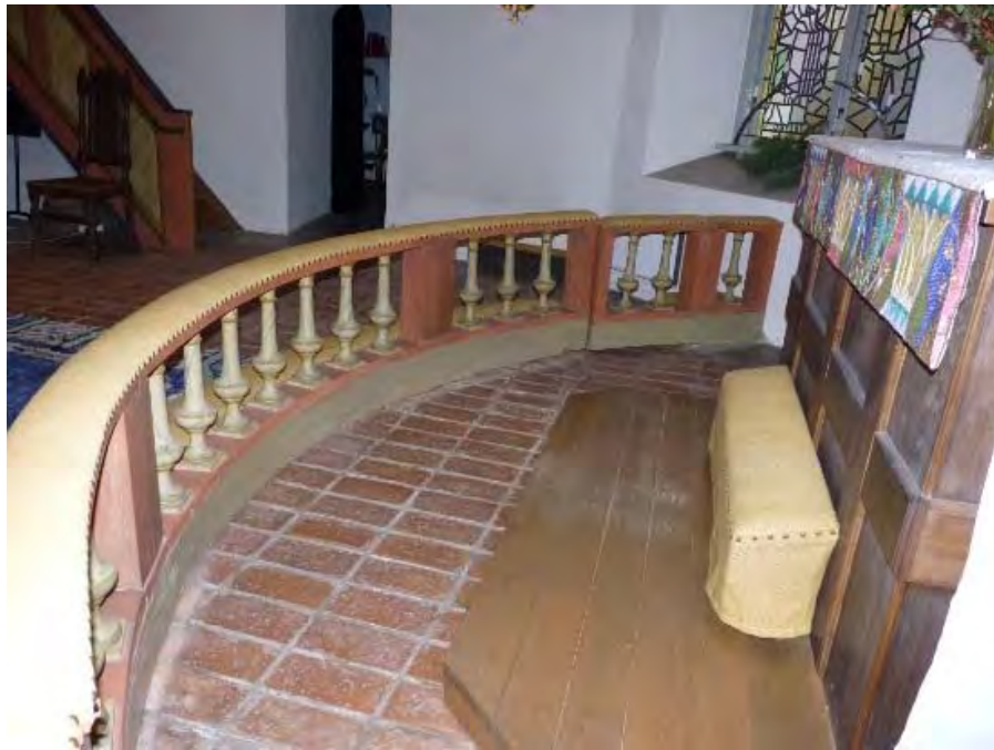
Figur 15. Altarringen med återställd yta. Foto: Helén Sjökvist.
