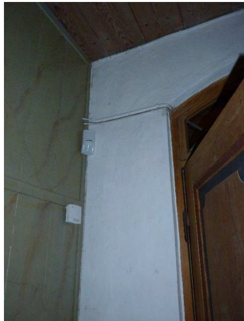
Figur 16. En av dörrarna under norra läktartrappan. Vid pilen syns ett ingrepp för dörrstängaren. Foto: Helén Sjökvist.
