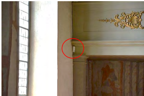
Figur 22 och 23. Tidigare placeringar av rörelsedetektorer. Foto: Tobias Mårud.
