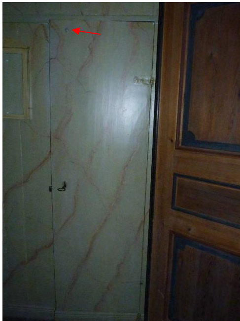
Figur 16. En av dörrarna under norra läktartrappan. Vid pilen syns ett ingrepp för dörrstängaren. Foto: Helén Sjökvist.
