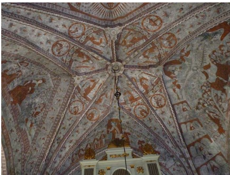
Figur 19. Västvalv före åtgärder. Helén Sjökvist.
