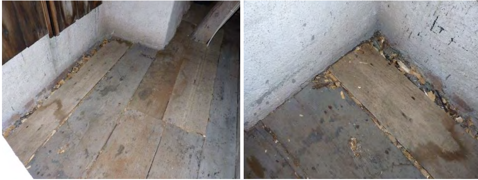
Figur 45. Lagning av golv vid östra ljudluckan. Foto: Helén Sjökvist.
