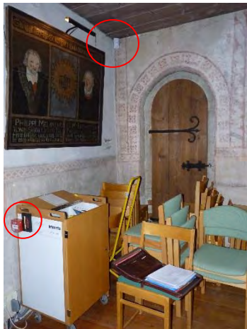
Figur 24. Installation av detektor under läktarens norra del efter åtgärder. Detektorn är monterad på ett vinkeljärn. På styrpulpeten är larmknappen monterad. Helén Sjökvist.
