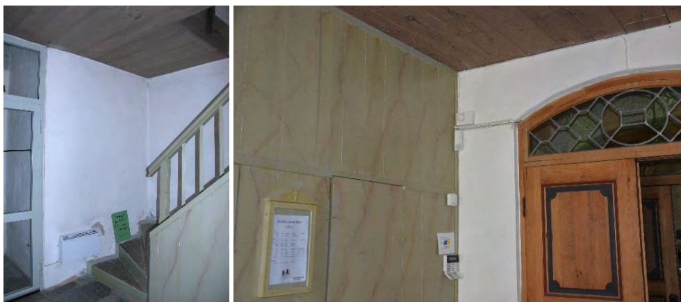
Figur 4. Norra läktartrappan före åtgärder. Foto: Helén Sjökvist.
