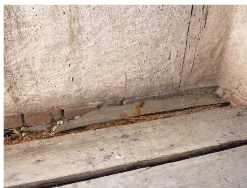
Figur 41. Brädan närmast östra ljudluckan var mycket rötskadad. Foto: Helén Sjökvist.
