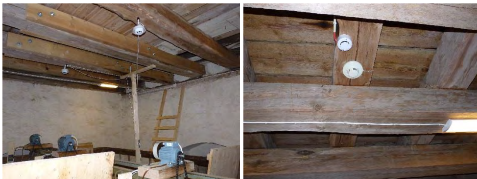
Figur 35. Snett sänkbar detektor över klockorna. Foto: Helén Sjökvist.
