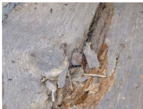
Figur 43. Rötskador i golv vid östra ljudluckan. Foto: Helén Sjökvist.
