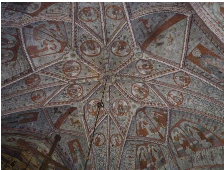
Figur 18. Östvalv före åtgärder. Helén Sjökvist.
