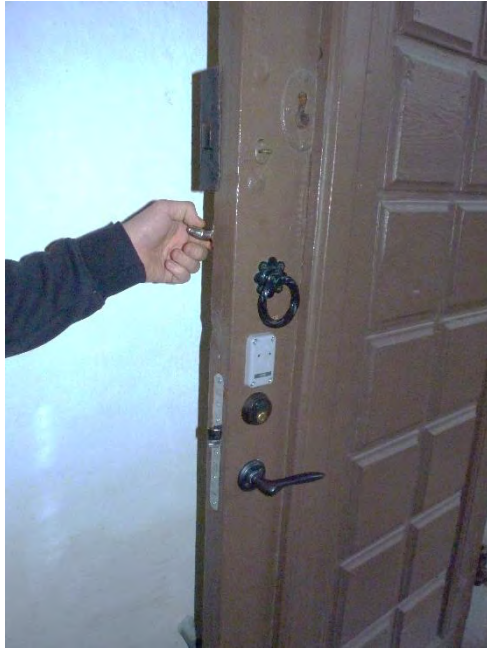
Figur 14. Västportens utsida efter åtgärder. Den ljusgrå läsaren skall målas in i samma bruna kulör som dörrbladet. Foto: Helén Sjökvist.
