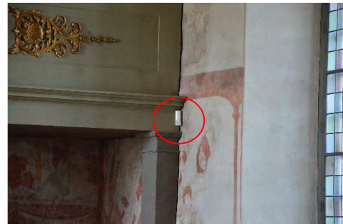
Figur 22 och 23. Tidigare placeringar av rörelsedetektorer. Foto: Tobias Mårud.
