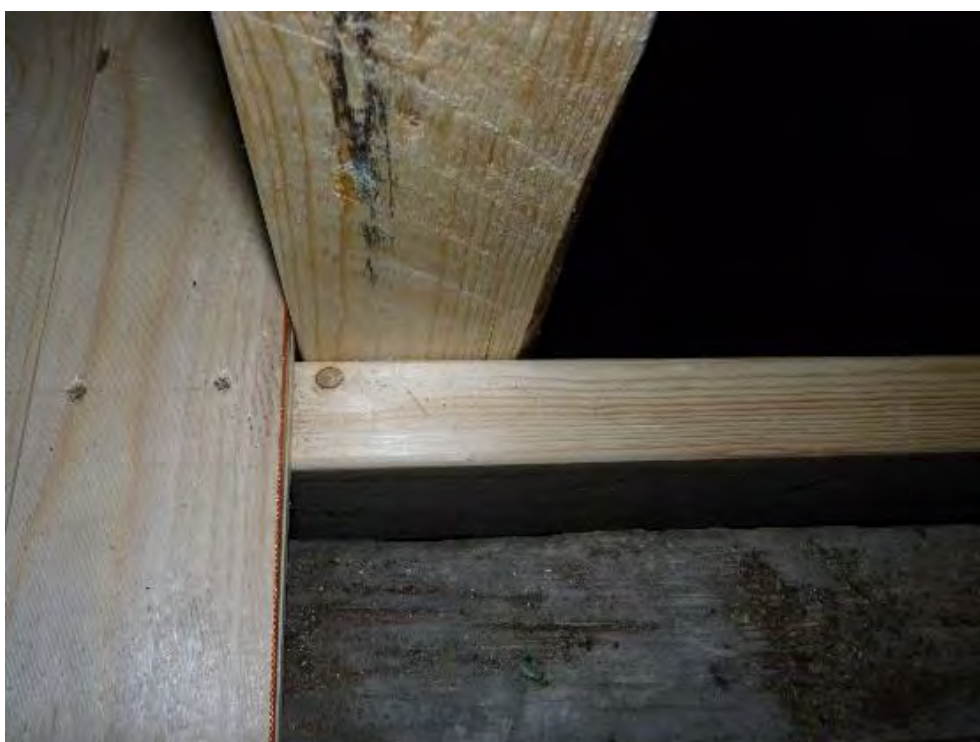
Figur 53. Landgängen hängs över takstolen och spänns fast utan infästningar i äldre virke. Foto: Helén Sjökvist.
