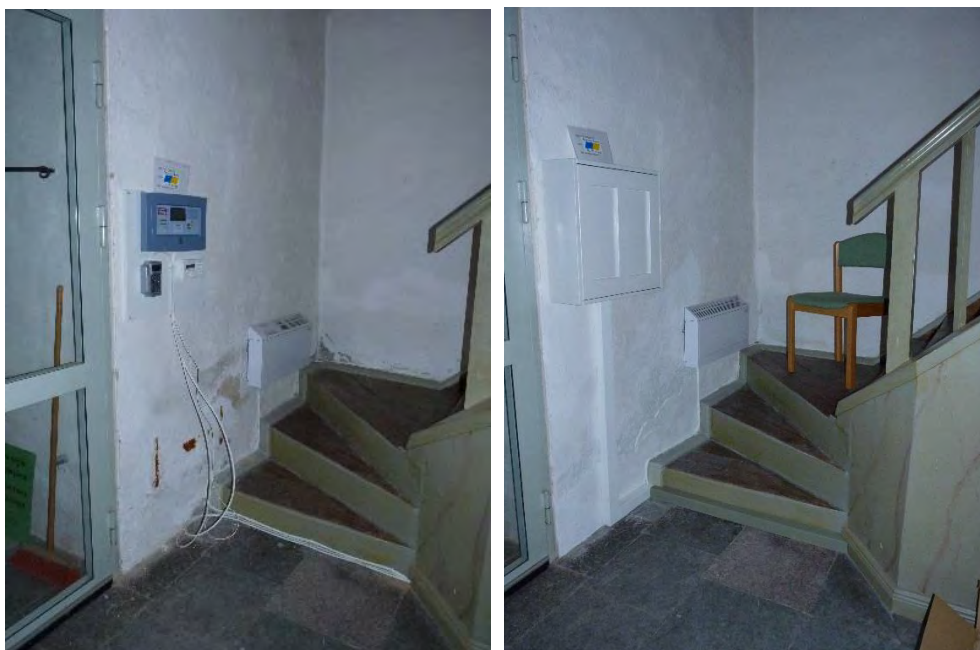
Figur 6. Pågående installation i vapenhusets nordvästra del. eldragning gjord utmed nedersta sättsteget. Radiator flyttad. Foto: Helén Sjökvist.
