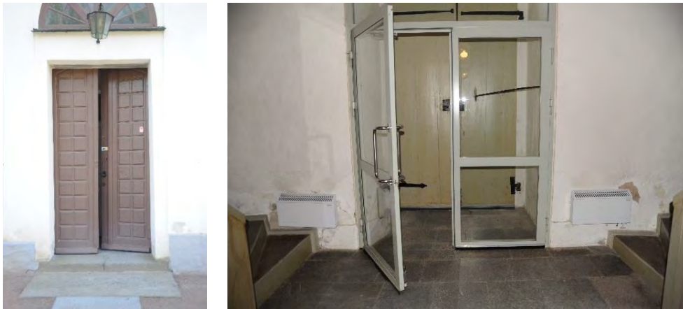
Figur 10. Västportens utsida före åtgärder. Foto: Svensk Klimatstyrning.
