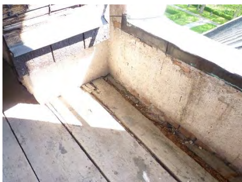
Figur 41. Brädan närmast östra ljudluckan var mycket rötskadad. Foto: Helén Sjökvist.
