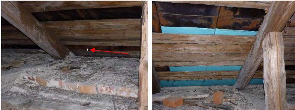
Figur 54. Vid pilen anas en ljusstrimma från ett hål i tornkransens plåttak. Foto: Helén Sjökvist.
