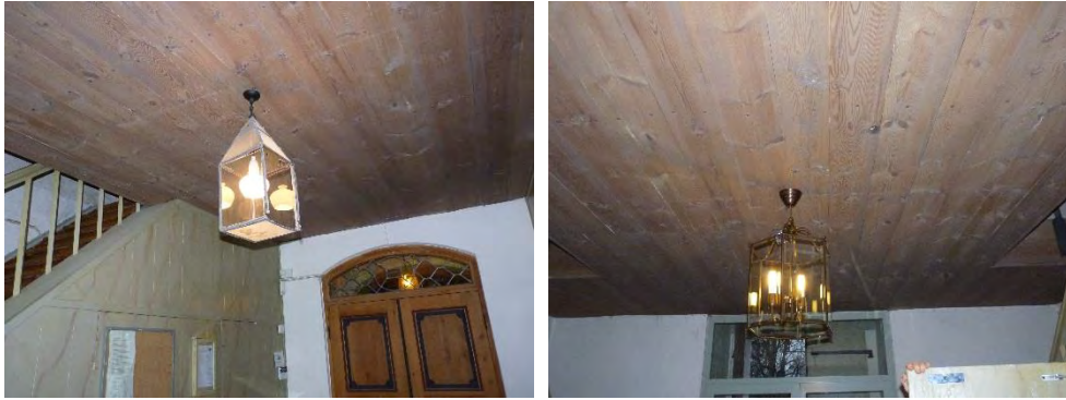
Figur 8. Äldre armatur i sakristian med förkomna glas och uppbrutna blyinfattningar. Foto: Helén Sjökvist.
