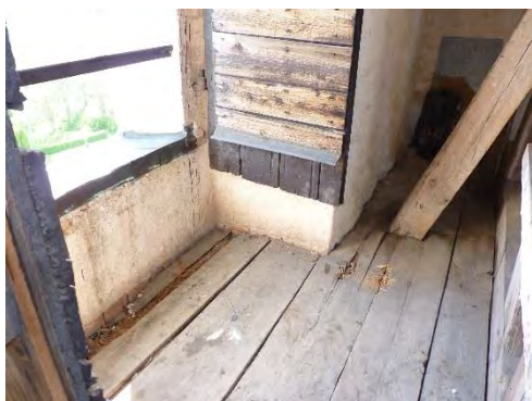
Figur 43. Rötskador i golv vid östra ljudluckan. Foto: Helén Sjökvist.
