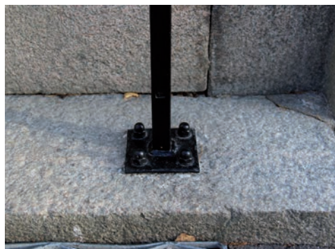
Figur 8. Trappräckets stolpar är fästa i stentrappan med kvadratiska plattjärn... Foto: Tobias Mårud.
