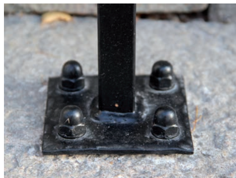
Figur 8. Trappräckets stolpar är fästa i stentrappan med kvadratiska plattjärn... Foto: Tobias Mårud.
