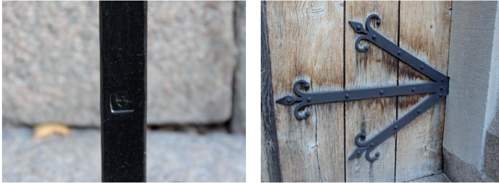
Figur 15. Smeden har satt sin stämpel på trappräckets stolpar. Foto: Tobias Mårud.
