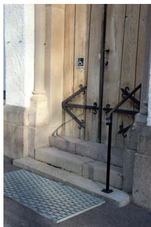
Figur 10. Trappräcket följer portalens södra nisch. Foto: Tobias Mårud.
