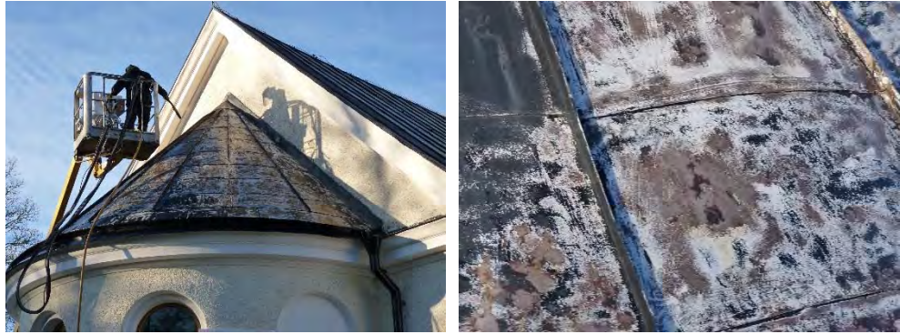
Figur 51. Blästring av taket. Foto: Helén Sjökvist.
