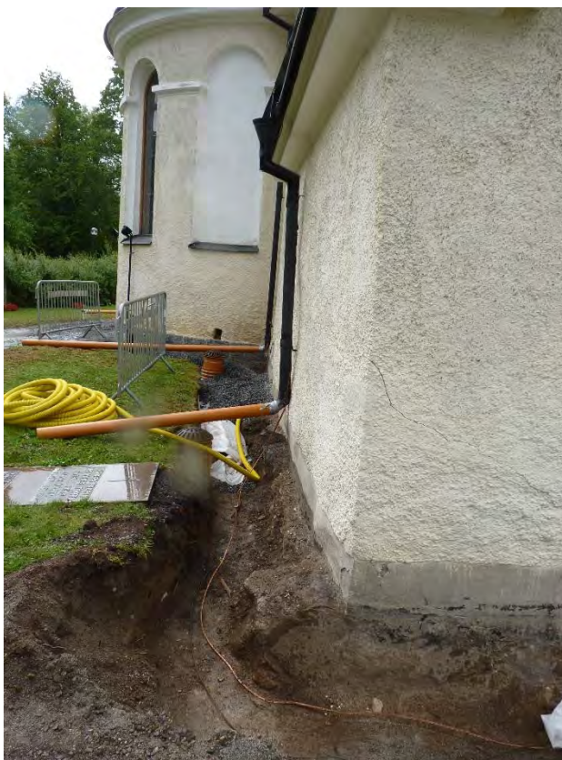
Figur 41. Grunden under sättningsprickan tycks vara relativt stabil. Man anar även den tjärning och stenkolsbetrykning av grunden som nämns i historiken. Foto: Helén Sjökvist.
