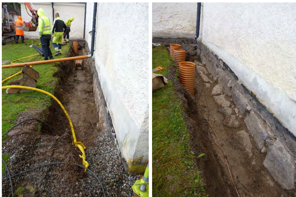
Figur 6 och 7. Långbusets norra vägg med underliggande äldre murverk. Foto: Helén Sjökvist.
