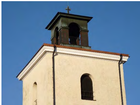
Figur 35. Färdigställd torngesims. Foto: Helén Sjökvist.
