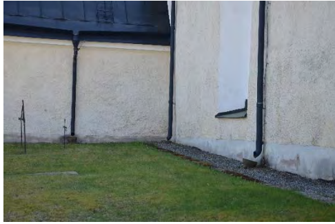
Figur 11. Långbusets norra sida samt sakristians västra sida. Runda böjar på stuprören. Foto: Tobias Mårud.
