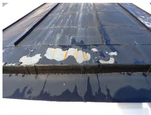
Figur 49. Färgbortfall, vita rinningar och rostangrepp på kortaket. Foto: Helén Sjökvist.
