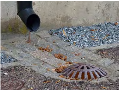
Figur 20. Ny kupolsil samt ränna av smågatsten. Foto: Helén Sjökvist.
