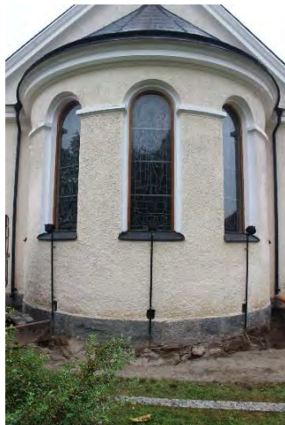
Figur 44. Tidigare strålkastare monterade under fönstren på koret. Foto: Tobias Mårud.
