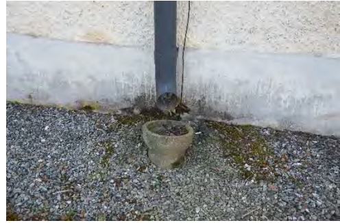
Figur 11. Långbusets norra sida samt sakristians västra sida. Runda böjar på stuprören. Foto: Tobias Mårud.
