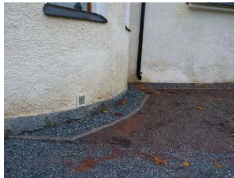
Figur 20. Ny kupolsil samt ränna av smågatsten. Foto: Helén Sjökvist.
