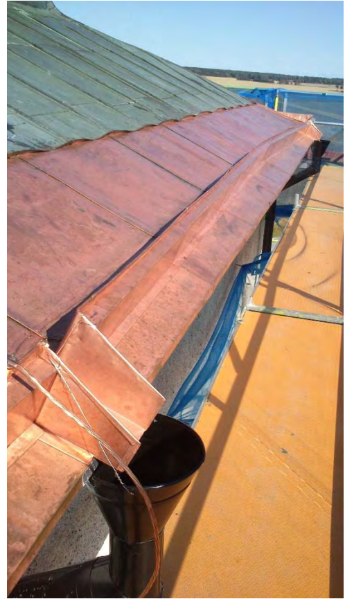
Figur 33. Västra delen av taket med ny ståndränna. Foto: Helén Sjökvist.
