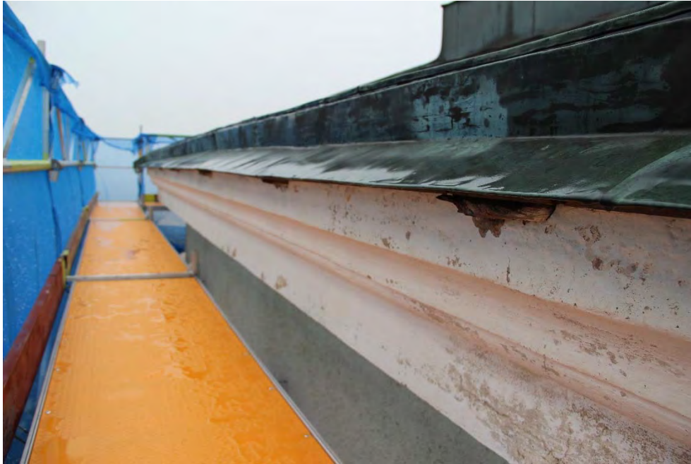
Figur 31. Befintlig ståndränna på tornets östra sida. Foto: Tobias Mårud.
