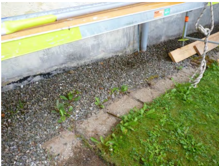
Figur 10. Äldre avgränsning mellan gräsyta och singeldike med betongplattor, tornets norra sida.
