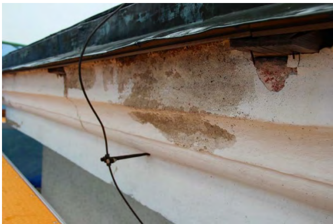
Figur 25. Puts- och färgsläpp från tornets gesims. Foto: Tobias Mårud.
