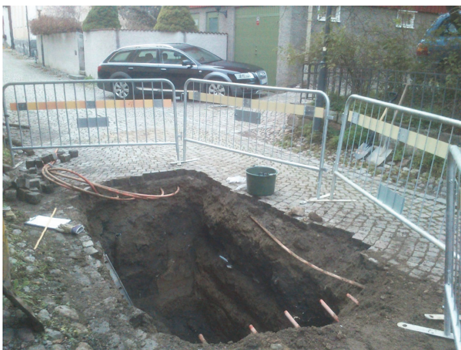
Figur 5. Schakt 2 sett från nordöst. I den högra schaktväggen ses kulturlager. Skärnsleven visar läget för botten av kulturlagret. Fotograferat av Jonas Ros.
