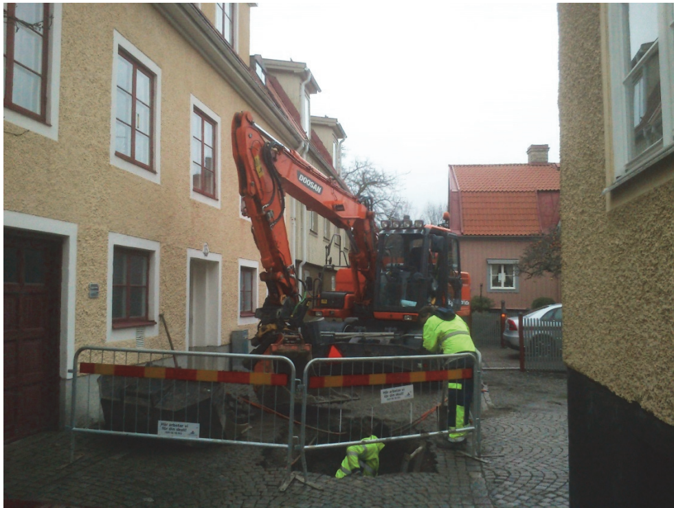
Figur 8. Schakt 1 sett från söder. Fotograferat av Jonas Ros.
