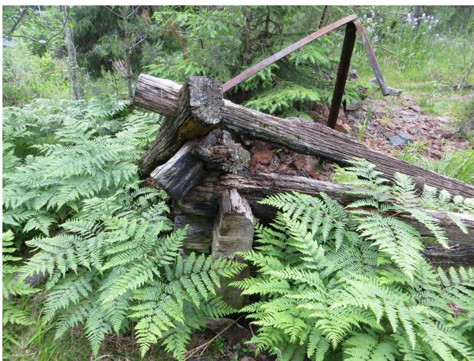
Figur 12. Timmerhuset. På bilden syns den nordvästra gaveln och den återstående delen av väggarna. Spismursröset i bakgrunden. Fotograf Ellinor Sabel
