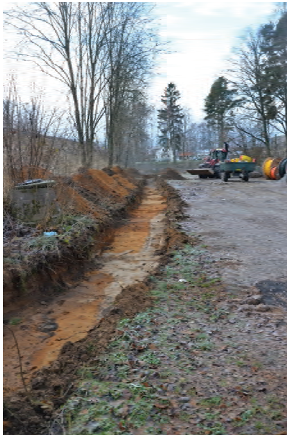
Figur 4. Del av schakt O100, ledningsschaktet, fotograferat från nordost. Foto: Mattias Jobansson.
