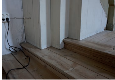
Figur 10 Kabelldragning vid skarven till predikstolens trappa. Foto: Helén Sjökvist.
