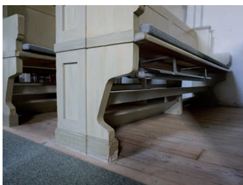
Figur 38. De nya kablarna har dragits i befintliga rör. På bilden syns bl.a. en lös, kvarlämnad, bygel för den tidigare kabeln. Foto: Tobias Mårud.
