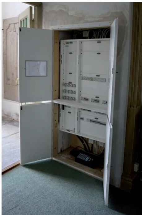
Figur 18 (Vänster). Den nya elcentralen på plats i det äldre skåpet. Putslagningar kring skåpet kommer anläggas. Foto: Tobias Mårud.
