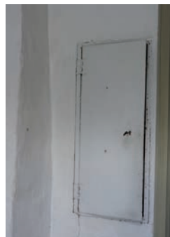
Figur 18 (Vänster). Den nya elcentralen på plats i det äldre skåpet. Putslagningar kring skåpet kommer anläggas. Foto: Tobias Mårud.
