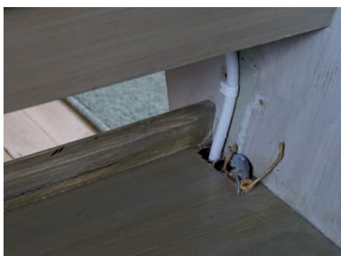
Figur 38. De nya kablarna har dragits i befintliga rör. På bilden syns bl.a. en lös, kvarlämnad, bygel för den tidigare kabeln. Foto: Tobias Mårud.
