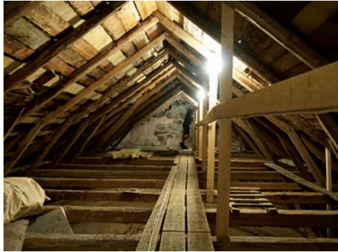
Figur 16. Över vinden löper kablar dels på liggande kabelbräda, parallellt med spång, dels under bräda som även fungerar som handledare. Foto: Tobias Mårud.
