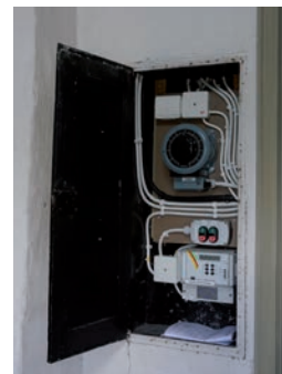
Figur 18 (Vänster). Den nya elcentralen på plats i det äldre skåpet. Putslagningar kring skåpet kommer anläggas. Foto: Tobias Mårud.
