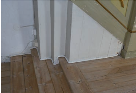
Figur 10 Kabelldragning vid skarven till predikstolens trappa. Foto: Helén Sjökvist.
