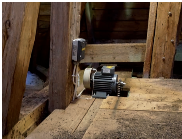
Figur 26. Nytt styr- eller automatskåp installerades i tornet. Foto: Tobias Mårud.
