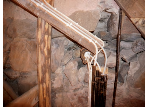
Figur 16. Över vinden löper kablar dels på liggande kabelbräda, parallellt med spång, dels under bräda som även fungerar som handledare. Foto: Tobias Mårud.
