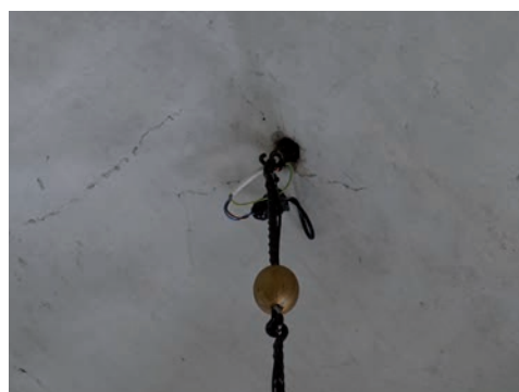
Figur 30. Ovandelen på en av pendlarna till kyrkans takkronor, innan åtgärd. Foto: Tobias Mårud.
