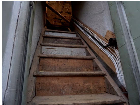
Figur 12 (Vänster). Kabelbräda i trapp till vind, innan åtgärd. Foto: Helén Sjökvist.
