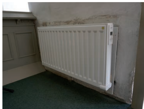
Figur 32. Radiatorn på orgelläktarens södra del har monterats ned. I nederkanten på bildens vänstra sida kan man se spåren av den demonterade sparkbrädan. Foto: Tobias Mårud.
