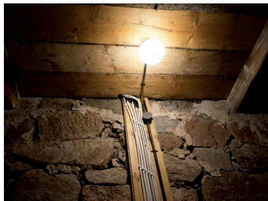
Figur 14 (Vänster bild). Befintlig kabelbräda i torn, innan åtgärd. Foto: Helén Sjökvist.
