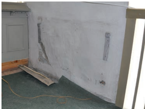
Figur 32. Radiatorn på orgelläktarens södra del har monterats ned. I nederkanten på bildens vänstra sida kan man se spåren av den demonterade sparkbrädan. Foto: Tobias Mårud.
