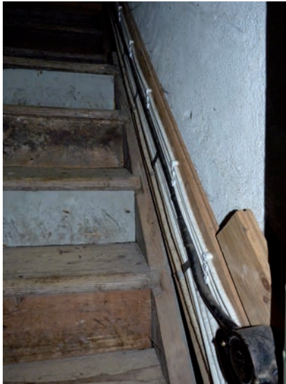
Figur 12 (Vänster). Kabelbräda i trapp till vind, innan åtgärd. Foto: Helén Sjökvist.
