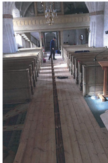
Figur 7 (Höger bild). Kabelkanalen löper i mittgångens hela längd. Foto: Eskilssons El AB.
