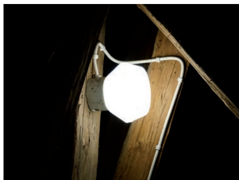
Figur 29. Ny armatur i opakt glas, rund med vulst och plan framsida. Foto: Tobias Mårud.
