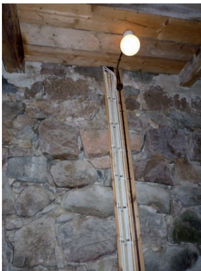
Figur 14 (Vänster bild). Befintlig kabelbräda i torn, innan åtgärd. Foto: Helén Sjökvist.
