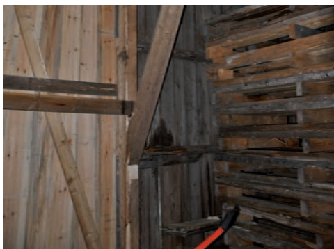
Figur 9. Ny stolpe och nytt stödben. Foto: Tobias Mårud.
