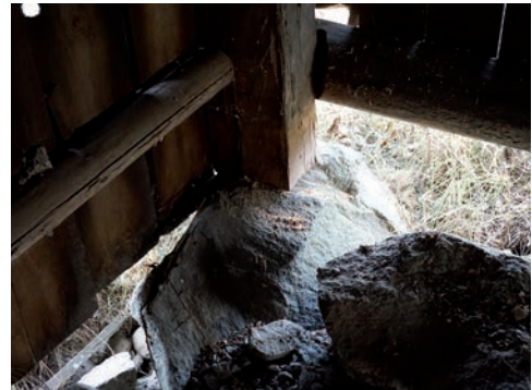
Figur 17. Mittenstolpen på norra gaveln efter åtgärd. Foto: Tobias Mårud.
