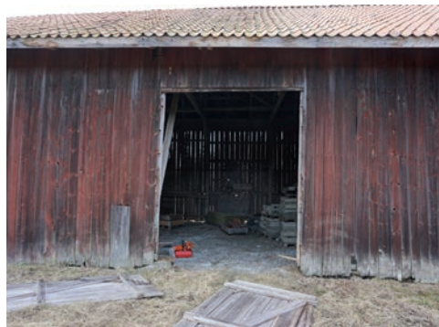
Figur 5. Ena portöppningen i östra fasaden, själva porten ligger på marken utanför. Foto: Tobias Mårud.
