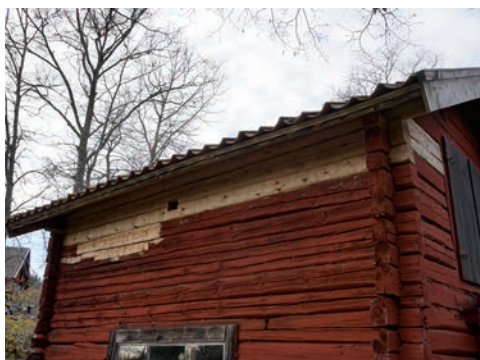
Figur 30. Tidigare ersatt, omålat timmer i sydöstra fasaden. Foto: Tobias Mårud.
