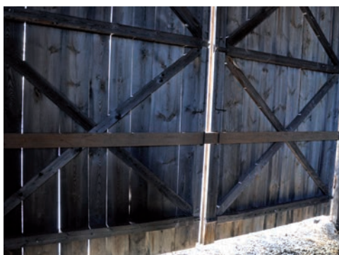
Figur 13. Bom monterad på insidan för att låsa och styva upp porten i södra gaveln. Foto: Tobias Mårud.
