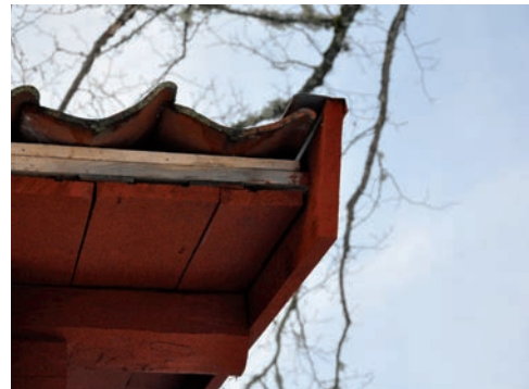
Figur 34. Vindskivorna ersattes och överliggarna komplettrades. Foto: Tobias Mårud.
