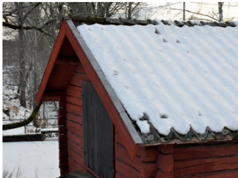
Figur 34. Vindskivorna ersattes och överliggarna komplettrades. Foto: Tobias Mårud.
