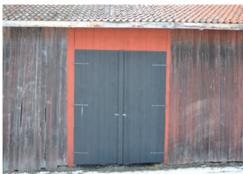
Figur 11. Östra fasadens södra port efter åtgärd. Foto: Tobias Mårud.
