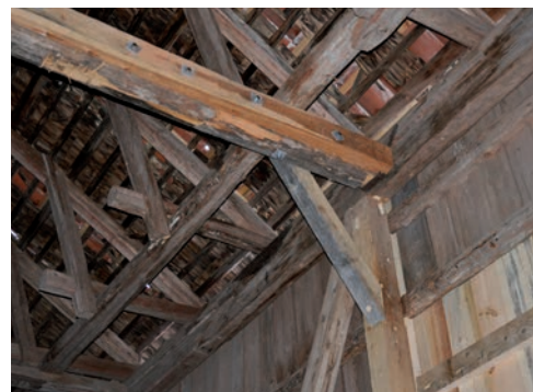
Figur 7. Här har den rötskadade stolpen i fig. 6 ersatts. Foto: Tobias Mårud.
