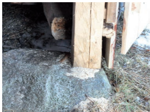
Figur 7. Här har den rötskadade stolpen i fig. 6 ersatts. Foto: Tobias Mårud.
