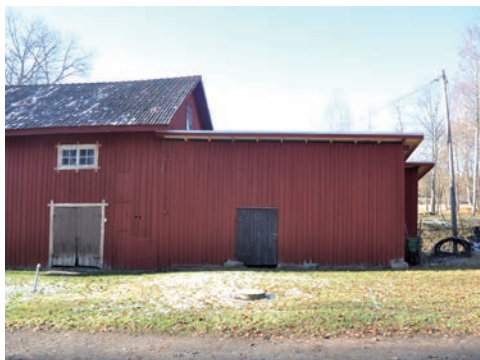
Figur 19. Norra fasaden innan åtgärd. Foto: Tobias Mårud.
