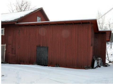
Figur 23. Norra fasaden efter åtgärd. Foto: Tobias Mårud.
