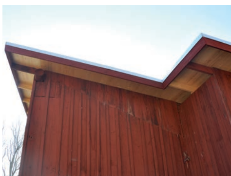
Figur 21. Östra delen av takfallet innan åtgärd. Metallsargen tillkom 2013. Foto: Tobias Mårud.
