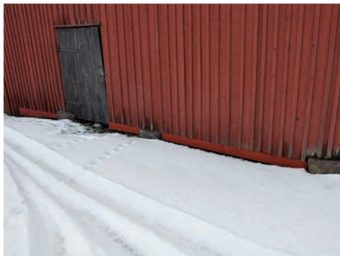
Figur 27. Sockelbrädan på norra fasaden har bytts. Foto: Tobias Mårud.
