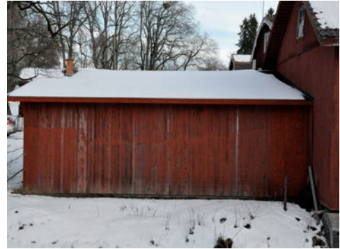
Figur 24. Södra fasaden efter åtgärd, bl.a. så har panelen på östra delen av fasaden målats. Foto: Tobias Mårud.
