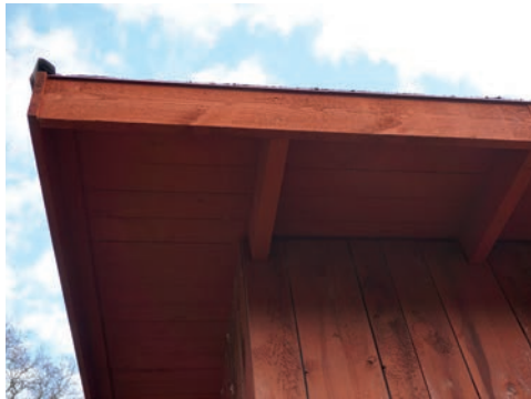
Figur 25. Takfoten målad och ny fotbräda och fotplåt på plats. Foto: Tobias Mårud.
