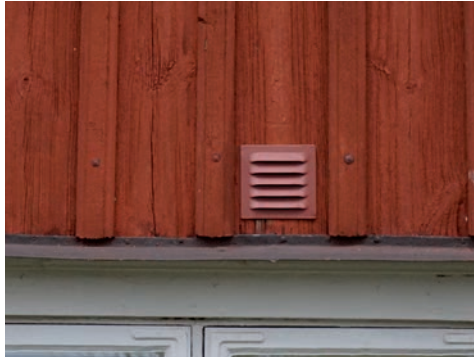
Bild 24. Samma hål med monterad väntil och väntilgaller. Foto: Tobias Mårud.
