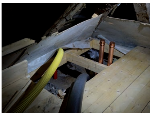
Bild 19. Rör och slangar dragna genom samma golvvippen. Foto: Tobias Mårud.
