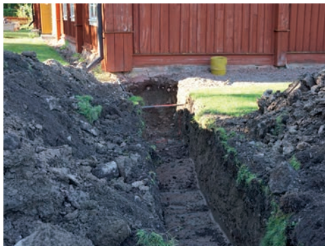
Bild 13. Huvudschaktet sett från norr, med en ordentlig sten i förgrunden (stenen fick spräckas och avlägsnas). Foto: Tobias Mårud.
