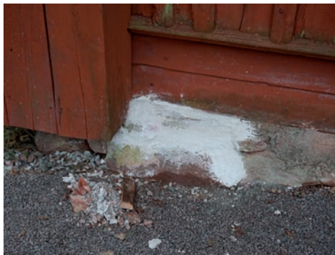
Bild 25. Fogen i östra delen av norra gavelns sockel uppvisade kraftiga sprickor. Foto: Tobias Mårud.
