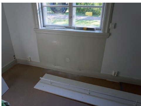
Bild 21. Håltagning utförd för rördragning. Foto: Tobias Mårud.
