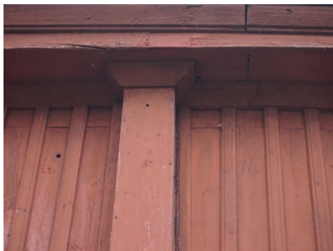
Bild 27. Misspdydande kabeldragning och håltagning på norra gaveln. Foto: Tobias Mårud.
