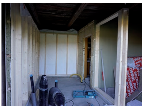
Bild 11. Utbyggnad av teknikrummet pågår, golv är gjutet och väggar reglas. Foto: Tobias Mårud.
