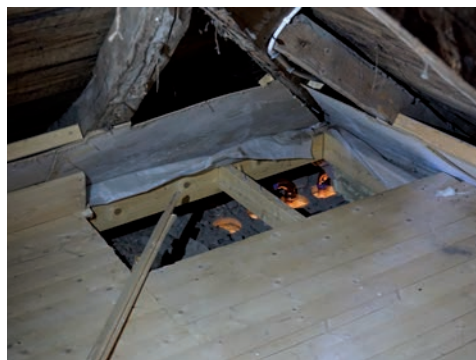
Bild 17. Rördragning mellan våningsplan, senare täckt av garderob. Foto: Tobias Mårud.
