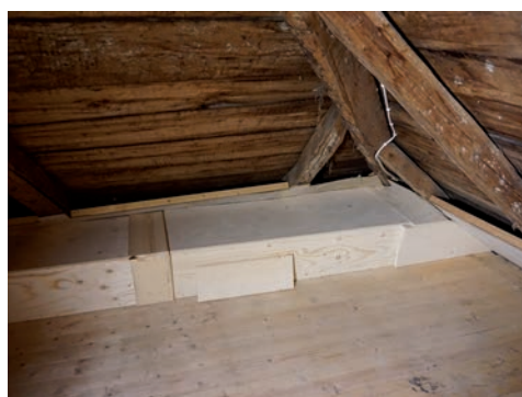
Bild 19. Rör och slangar dragna genom samma golvvippen. Foto: Tobias Mårud.
