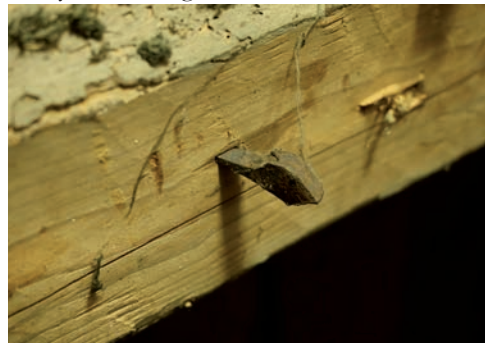
Bild 31. Rester av nät eller tyg, här med träplugg, på en av takstolarna. Foto: Tobias Mårud.
