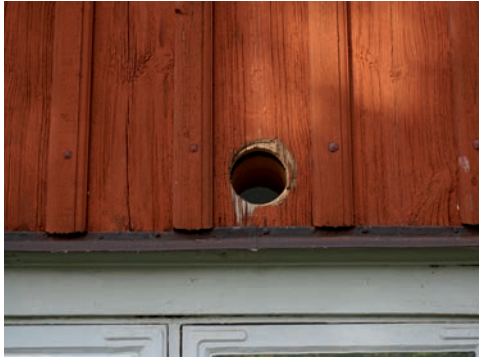
Bild 23. Håltagning för friskluftsväntil i fasad. Foto: Tobias Mårud.
