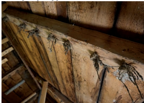
Bild 31. Rester av nät eller tyg, här med träplugg, på en av takstolarna. Foto: Tobias Mårud.
