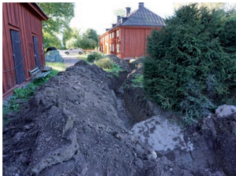
Bild 13. Huvudschaktet sett från norr, med en ordentlig sten i förgrunden (stenen fick spräckas och avlägsnas). Foto: Tobias Mårud.
