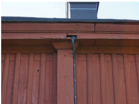
Bild 27. Misspdydande kabeldragning och håltagning på norra gaveln. Foto: Tobias Mårud.
