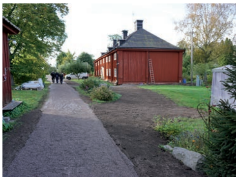
Bild 15. Schaktet mellan Pagebyggnaden och hus 204 har lagts igen. Foto: Tobias Mårud.
