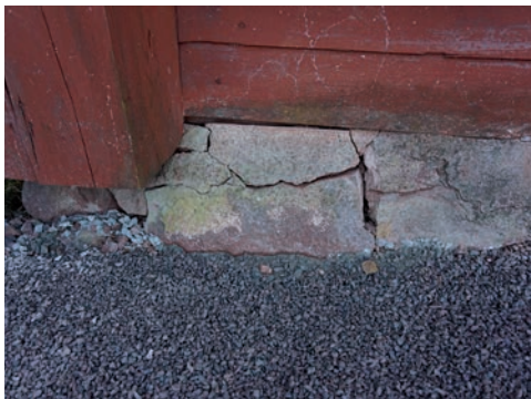
Bild 25. Fogen i östra delen av norra gavelns sockel uppvisade kraftiga sprickor. Foto: Tobias Mårud.
