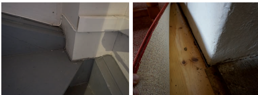
Figur 22. Synlig kabel anpassades efter bakgrundskulör (grå mikrofonsladd vid trappa). Foto: Tobias Mårud.
