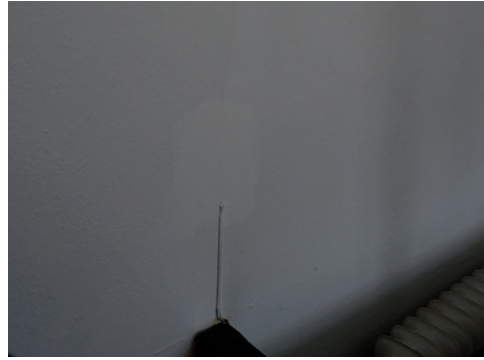
Figur 8. Plasten för högtalaren på södra väggen, märken från tidigare infästning kan skönjas mellan tavlan och fönstret. Foto: Tobias Mårud.
