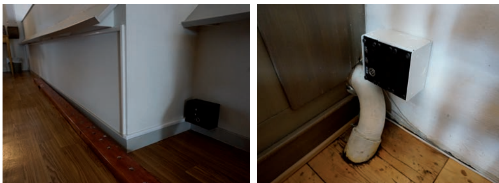
Figur 24. Box för mikrofonuttag på orgelläktare, lämnades svart. Foto: Tobias Mårud.
