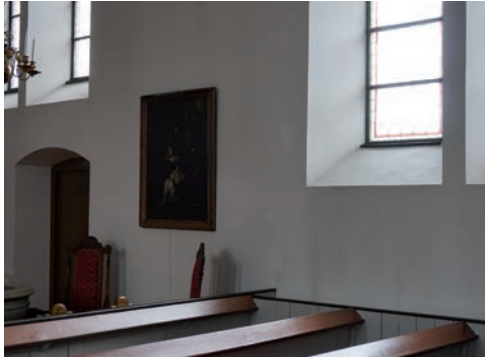
Figur 8. Plasten för högtalaren på södra väggen, märken från tidigare infästning kan skönjas mellan tavlan och fönstret. Foto: Tobias Mårud.
