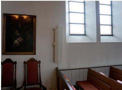
Figur 10. Den nya högtalaren monterad, på södra väggen. Foto: Tobias Mårud.
