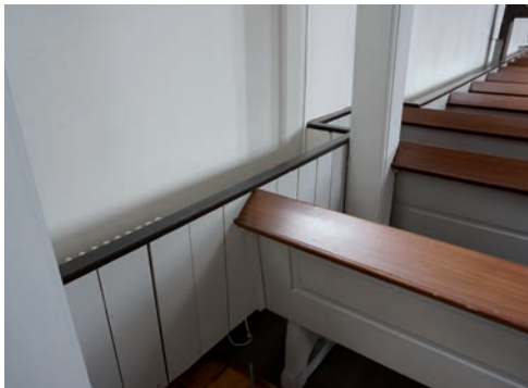
Figur 12. Kabeldragningen kunde till stor del förläggas bakom bänkkvarterens sidoväggar. Foto: Tobias Mårud.
