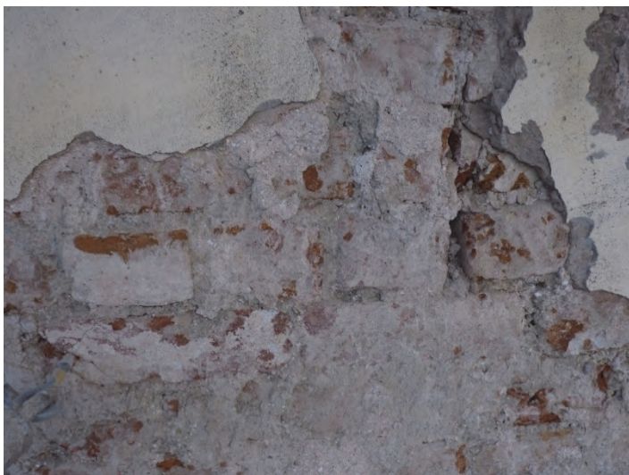
Figur 46 Södra fasaden, över fönster 4 från väster. 123 cm över karmen ligger en rad med liggande kopp. Foto: Helén Sjökvist.
