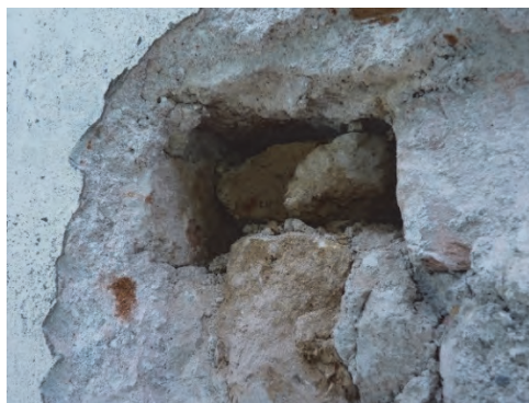
Figur 26. Norra fasaden, 2:a våningen, till vänster om mittfönstret finns en igensatt öppning efter ett äldre bomlag. Foto: Helén Sjökvist.
