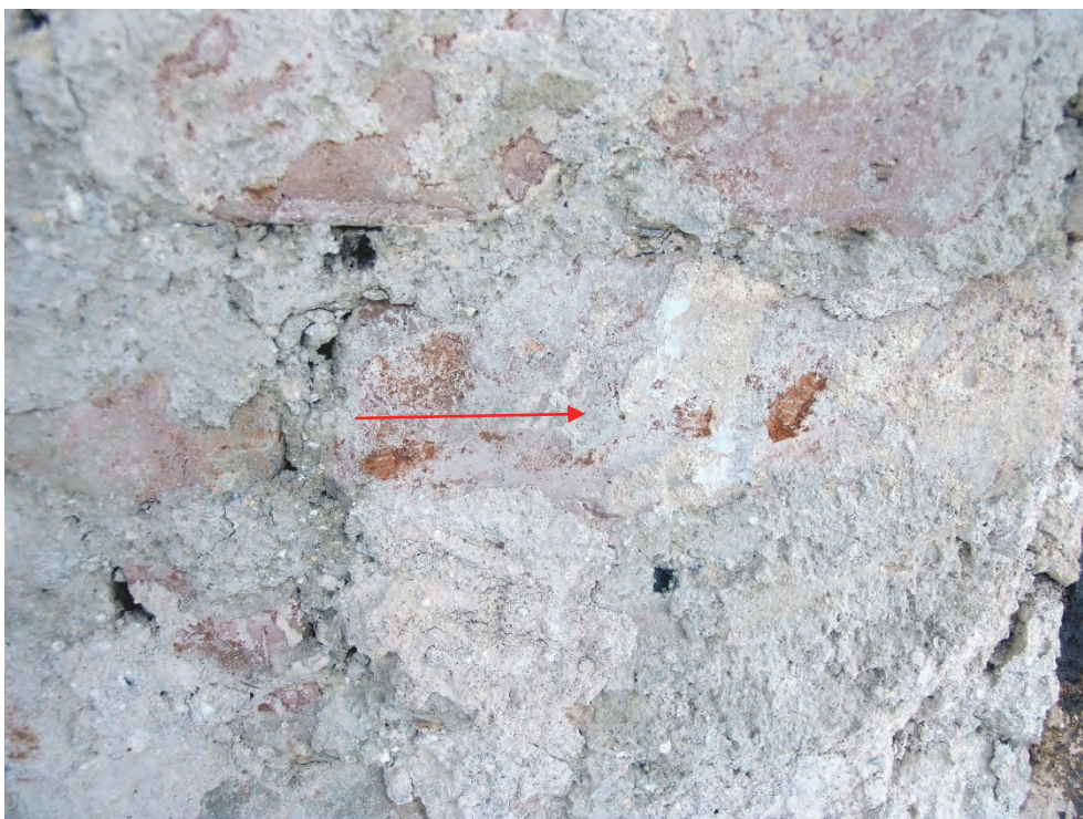
Figur 60. Mellan 2:a och 3:e fönster även rosaaktig kulör på äldre putslager, men även där mycket osäkert om det verkligen är en medvetet pålagd kulör. Foto: Helén Sjökvist.
