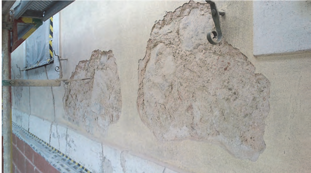
Figur 56. Större inslag av natursten i murverket över sockelväningen på västra fasaden. Foto: Helén Sjökvist.
