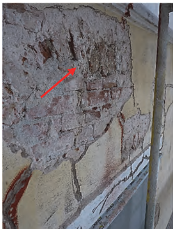
Figur 38. Södra fasaden, tredje våningen, över fönster fyra från vänster. Vålning över igensättning, se pilen. Foto: Helén Sjökvist.
