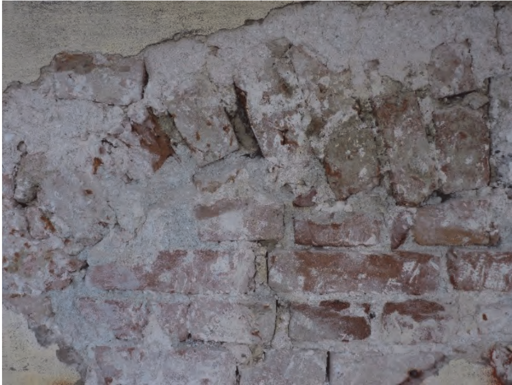
Figur 40. Över fönster fyra från väster, tredje våningen. Tydlig välvning över igensättning. Foto: Helén Sjökvist.
