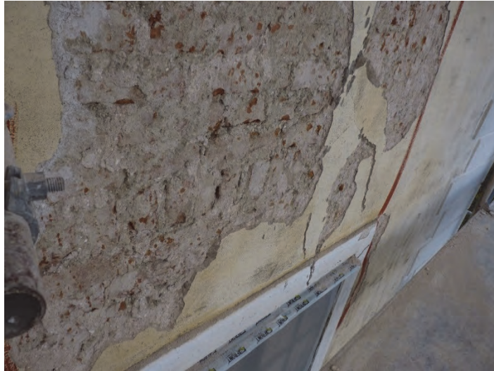
Figur 47. Andra våningen, över östligaste fönstret. Lätt välvt parti. Högsta punkten ligger 64 centimeter över befintligt karmöverstycke. Mycket flack. Stående tegel. Foto: Helén Sjökvist.
