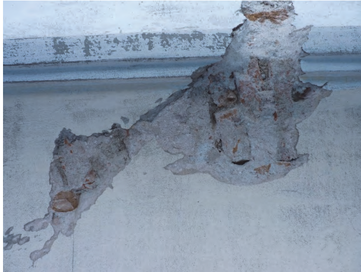
Figur 23. Norra fasaden, under mittgesims, Spår av igensatt, äldre stickebågig öppning våning tre. Foto: Helén Sjökvist.
