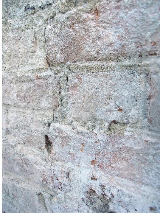
Figur 51. Parti med åsfog på västra fasaden. Foto: Helén Sjökvist.
