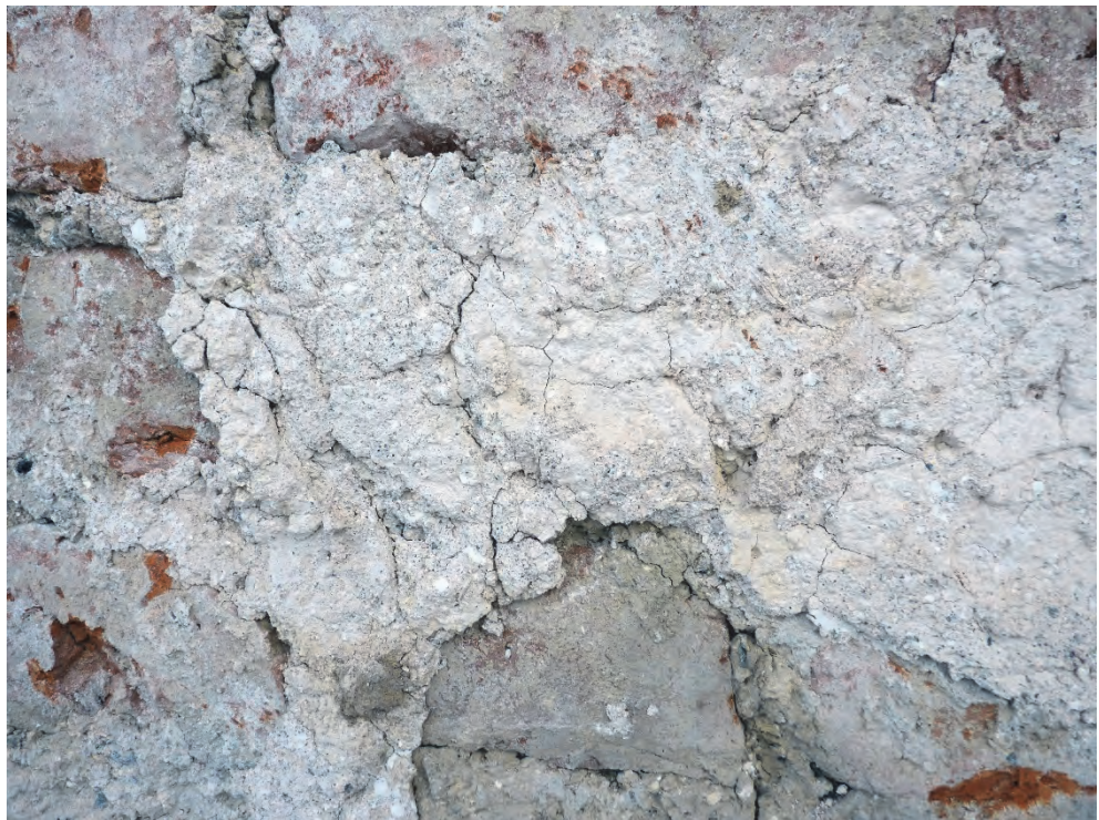
Figur 43. Andra våningen, över första fönstret från väster. Äldre, vitt stockningsbruk. Foto: Helén Sjökvist.
