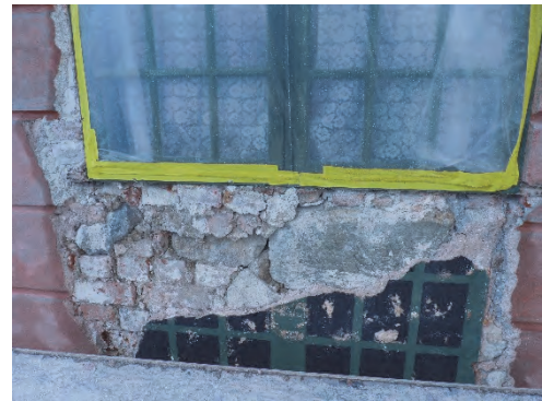
Figur 24 och 25. Omfattande inslag av natursten i sockelvåningen, bl.a. ljus sandsten. Foto: Helén Sjökvist.
