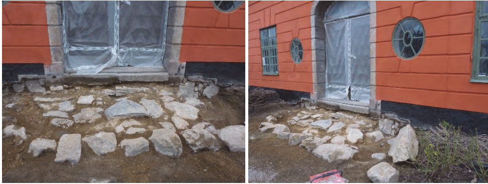
Figur 64. Trappan plockades ned till grundläggningen. Foto: Helén Sjökvist.
