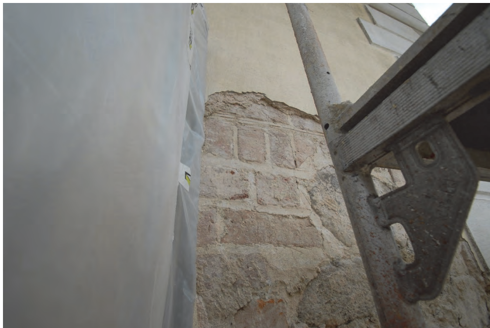
Figur 53. Västra fasadens södra del. Spår av äldre murning med rullförband samt naturstensinslag. Foto: Janusz Grenberger.
