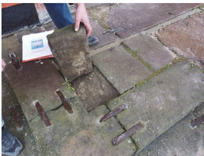
Figur 63. Stenarna låg delvis löst. Foto: Helén Sjökvist.
