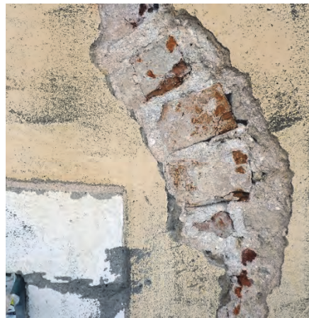
Figur 38. Södra fasaden, tredje våningen, över fönster fyra från vänster. Vålning över igensättning, se pilen. Foto: Helén Sjökvist.
