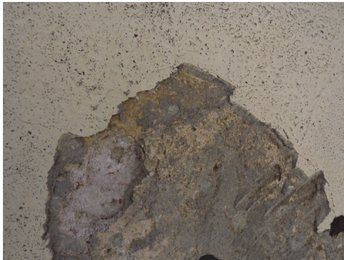
Figur 48. Putsknackat parti direkt över sockeln, under fönster fyra från väster. Två olika gula kulörer återfanns under modern vattrivning. Understa färglagret har kraftigast kulör, motsvarande cirka S2040-Y20R. Övre färglager motsvarar cirka S2020-Y30R. Ytorna är starkt påverkade av övermålning, så ncs-angivelser skall ej ses som exakta. Foto: Helén Sjökvist.
