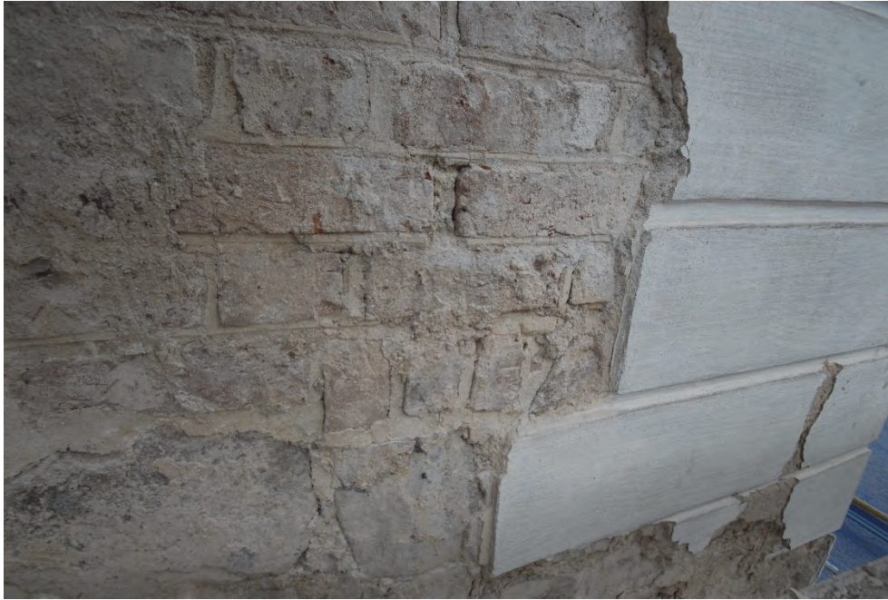
Figur 54. Parti med åsstrukna fogar Foto: Janusz Grenberger.
