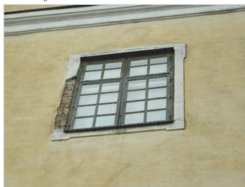
Figur 13. Östra fasaden skada i gesimslist och hörn. Helén Sjökvist.
