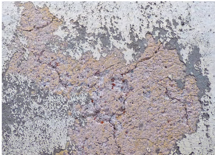
Figur 16. Exempel på rosaaktig 1700-tals puts med inslag av krossat tegel, översta våningen, norra fasaden. Foto: Helén Sjökvist.
