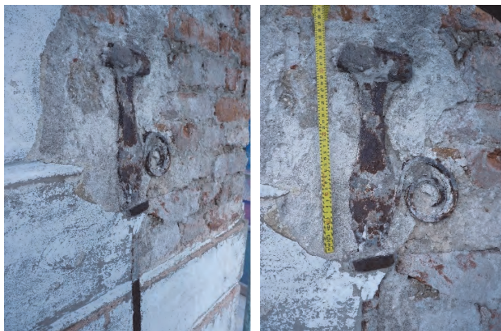
Figur 72. Södra fasaden. 1600-talets ankarjärn ligger försänkta in i putsen. Foto: Helén Sjökvist.
