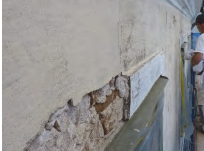
Figur 32. Den putsade omfattningen tunnar ut i borte änden. Foto: Helén Sjökvist.
