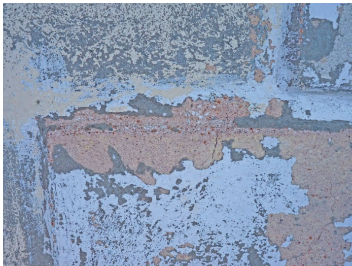
Figur 17. Hörnkedja med rosaaktig puts, nordöstra hörnet. Foto: Helén Sjökvist.
