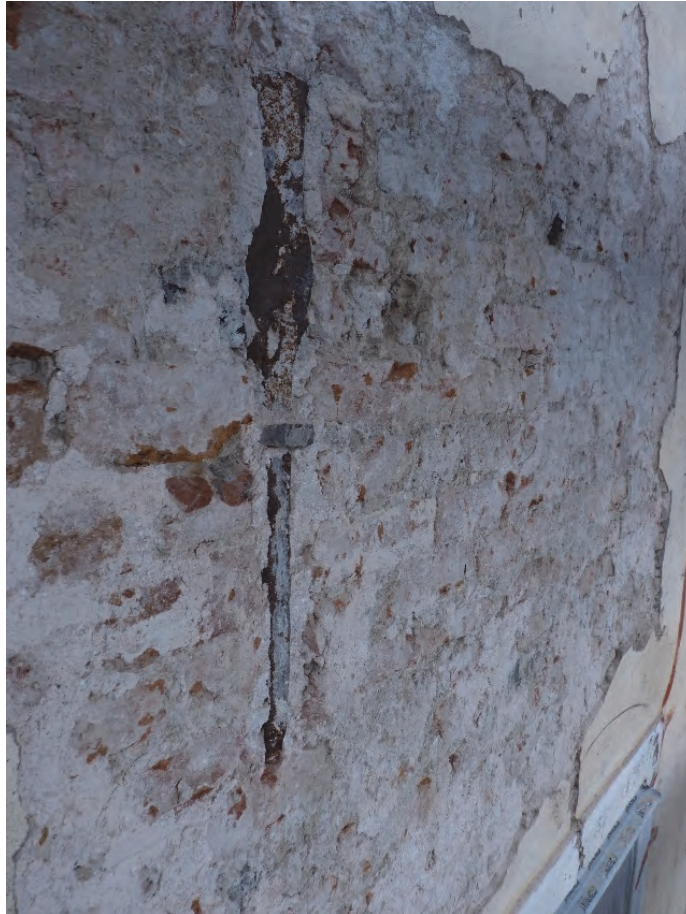
Figur 42. Mellan 2:a och 3:e våningen. Försänkt ankarslut över första fönster från väster. Foto: Helén Sjökvist.
