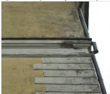
Figur 13. Östra fasaden skada i gesimslist och hörn. Helén Sjökvist.
