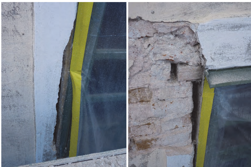
Figur 30 och 31. Fjärde våningen, mittfönster med glipa mellan karm o båge fylld med bruk. Möjligen en senare utbytt karm. Foto: Helén Sjökvist.
