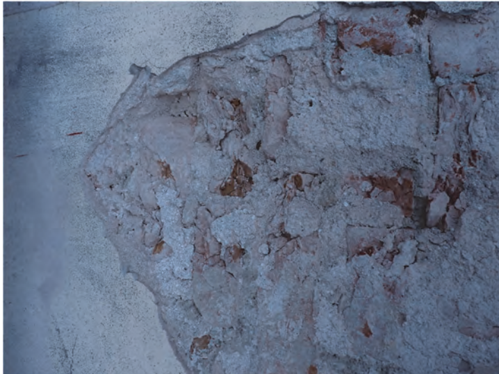
Figur 37. Tredje våningen. Äldre grundning. Foto: Helén Sjökvist.
