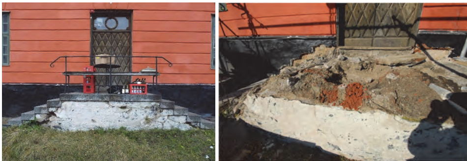
Figur 68. Befintligt utseende östra trappan. Foto: Helén Sjökvist.
