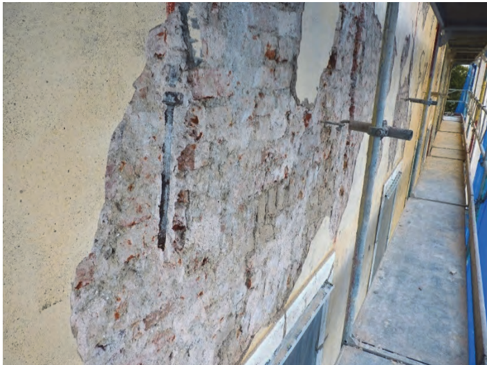
Figur 45. Rullförbandet ans över fönstret. Foto: Helén Sjökvist.
