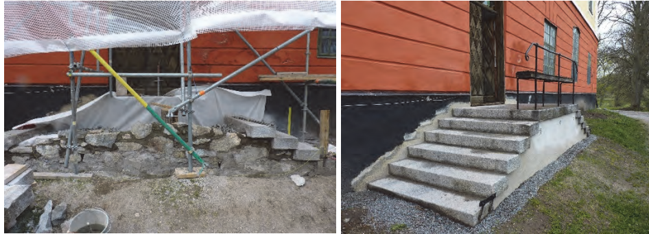
Figur 70. Östra trappan under återuppmurande. Foto: Helén Sjökvist.
