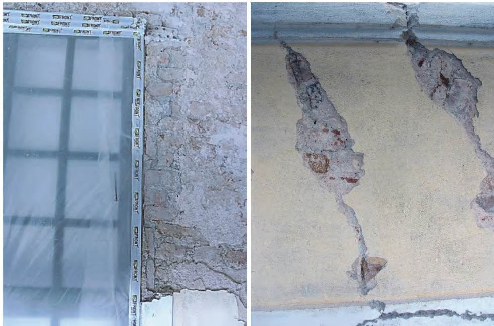
Figur 57. Andra våningen, tredje fönstret från norr. Inmurningen mot fönsterkarmen gör att man kan tro att fönstret är ändrat. Men det kan även ha varit så från början. Foto: Helén Sjökvist.
