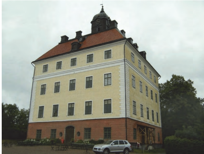
Figur 15. Sydfasad och östfasad före åtgärder. På östfasaden syns det tillfälliga skyddstaket över ingången på östra sidan. Helén Sjökvist.
