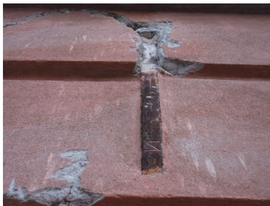
Figur 49. Sockelvåningen, stämpel på dragjärn snett under första fönstret från väster. Foto: Helén Sjökvist.
