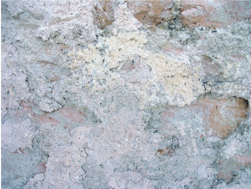
Figur 59. Undre del av fönster på andra våningen, mellan andra och tredje fönstret från norr återfanns en beigetonad puts. Osäkert om det är en pigmentering eller möjligen en naturlig variation i kulör i putsbruket. Ytan ligger under 1700-talsputs. I 1700-tals putsen finns inslag av träflis ibland. Foto: Helén Sjökvist.
