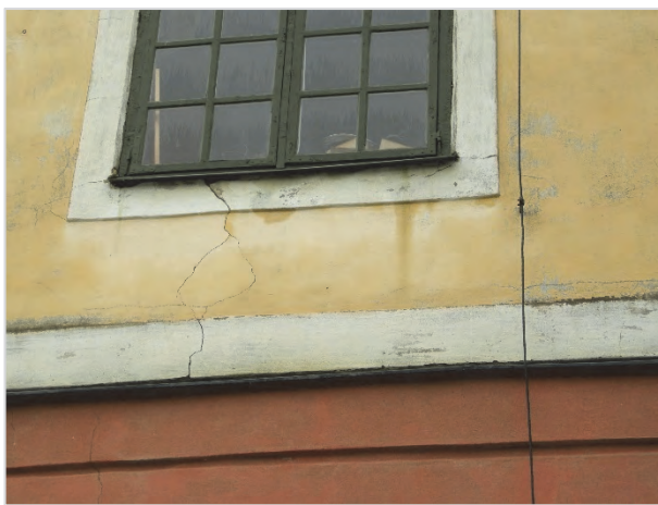
Figur 11. Norra fasaden med puts-skador. Foto: Helén Sjökvist.
