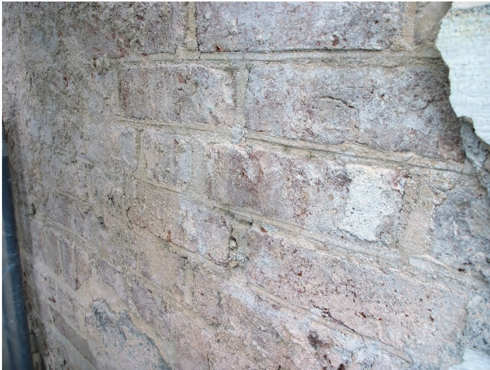
Figur 50. Parti med åsfog på västra fasaden. Foto: Helén Sjökvist.
