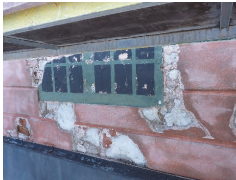
Figur 24 och 25. Omfattande inslag av natursten i sockelvåningen, bl.a. ljus sandsten. Foto: Helén Sjökvist.
