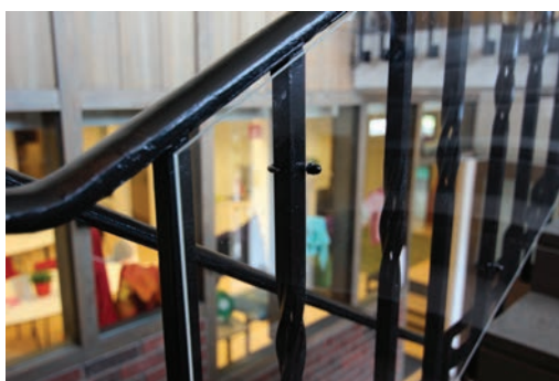
Närbild på glas- och träparti. Brandglasets foliekant är synlig. Bilden till höger visar den reversibla lösningen med plexiglas och krokar på trappräcket. Foto Lisa Skanser.
