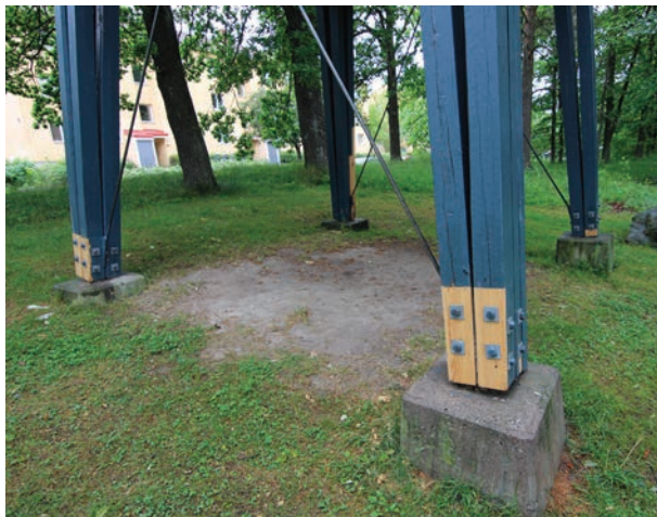
Lagningar av klockstapelns ben. Foto Lisa Skanser.
