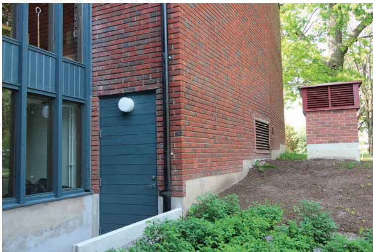
Bilden ovan visar ventilationsgallret innan dörrhål togs upp. Bilden till höger visar ny entré till fläktrum samt nytt galler i fasad och kassun öster om byggnaden. Foto Lisa Skanser.
