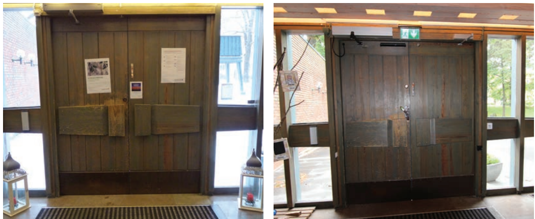
Huvudentré före och efter åtgärder. Foto Tobias Mårud (till vänster) och Lisa Skanser.
