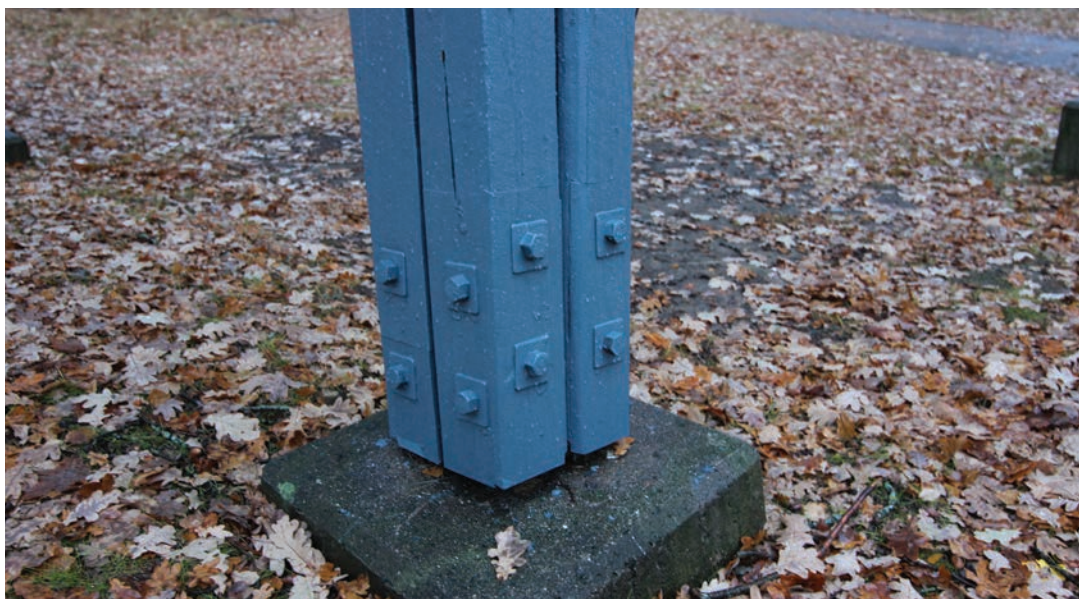
Klockstapelns ben efter reparation och målning samt med nya rektangulära brickor. Foto Lisa Skanser.
