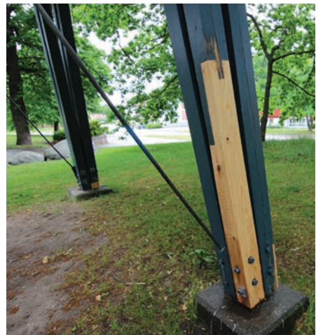
Lagningar av klockstapelns ben. Foto Lisa Skanser.
