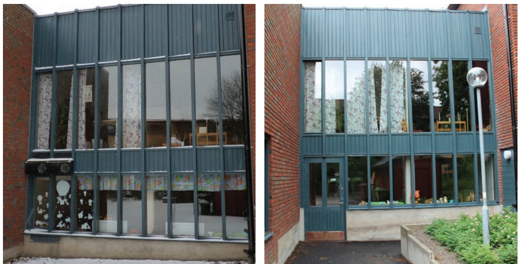
Utrymningsväg genom fönster i rum 013 (barnverksamhet) ändrades till utrymningsdörr. Foto Tobias Mårud (till vänster) och Lisa Skanser.
