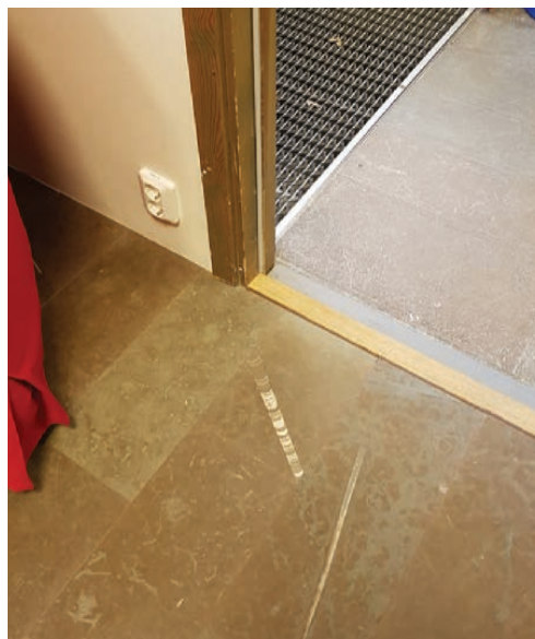
Golv i rum 003 och i entrén efter åtgärd. Foto Lisa Skanser.
