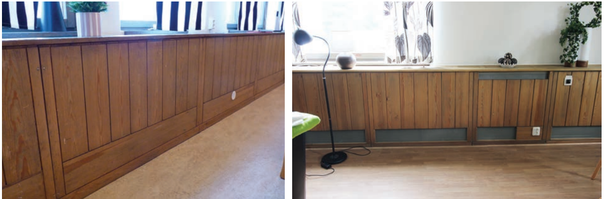
Konvektor-/radiatorskydd före och efter åtgärd. Foto Tobias Mårud (till vänster) och Lisa Skanser.
