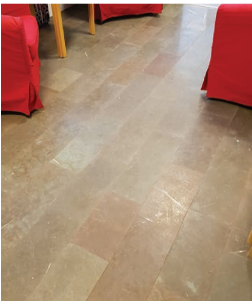
Kalkstensgolv i rum 003 efter åtgärd. Foto Lisa Skanser.
