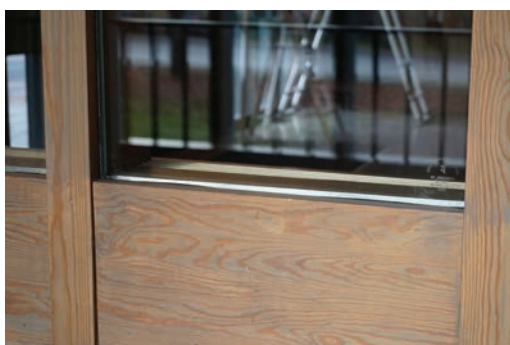
Närbild på glas- och träparti. Brandglasets foliekant är synlig. Bilden till höger visar den reversibla lösningen med plexiglas och krokar på trappräcket. Foto Lisa Skanser.
