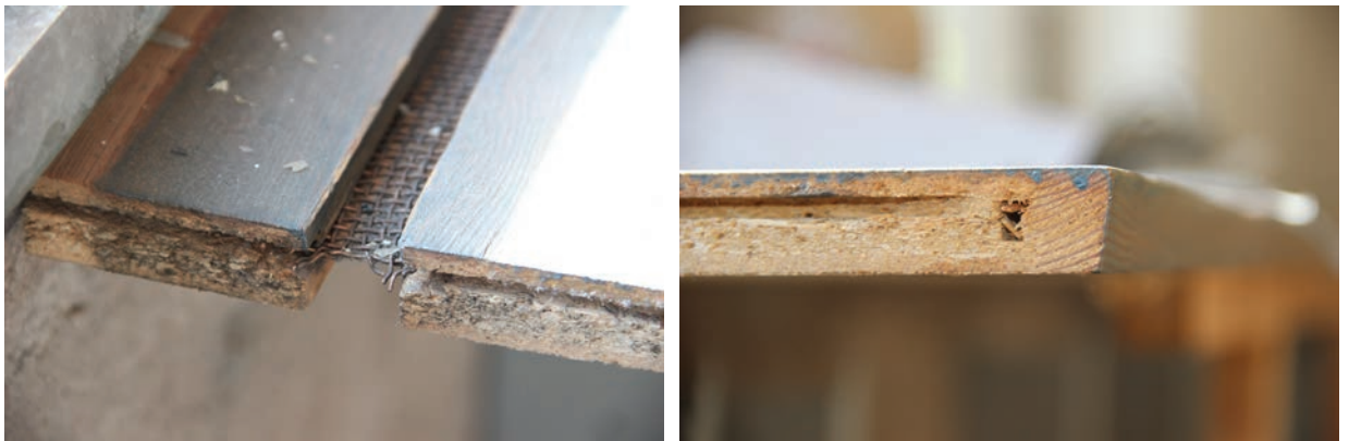
Närbilder på originallocken till konvektorinklädnaderna. Notera den mycket tunna faneren och att även gallerlitsarnas sidor är fanerade. Foto Lisa Skanser.
