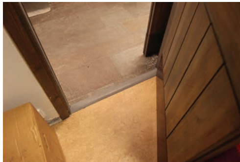
Golv i rum 003 och i entrén före åtgärd. Foto Lisa Skanser.
