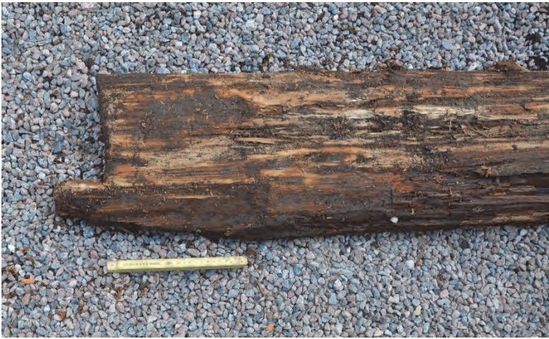
Figur 9. Fotografi som visar del av A9 som utgjorde en byggnadsdetalj. Fotograferat av Jonas Ros.
