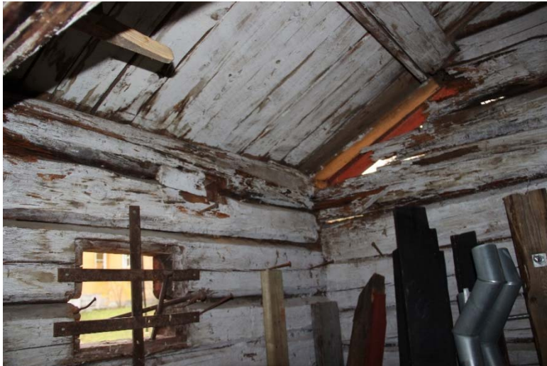
Figur 6. Fotot visar rötskadat timmer i gavelröste och hammarband i sydöstra hörnet.
