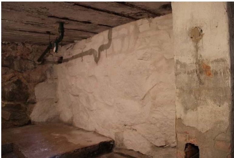
Figur 21. Källarväggen efter reparation och anfärgning.
