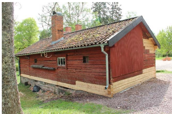
Figur 13. Skarvning av timmer genom halvt i halvt. Figur 14 (till höger) visar ny knutning i sydvästra knutkedjan.
