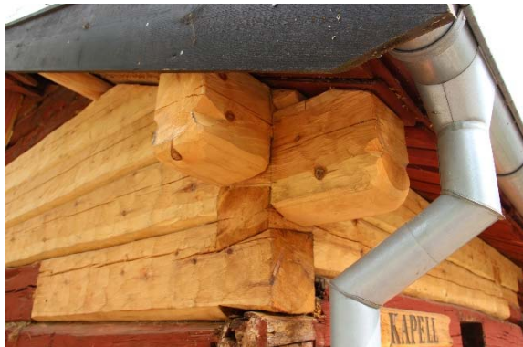
Figur 13. Skarvning av timmer genom halvt i halvt. Figur 14 (till höger) visar ny knutning i sydvästra knutkedjan.
