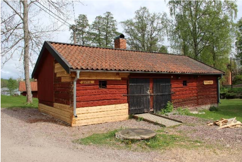
Figur 17. Timmerlagningar i väster och söder.
