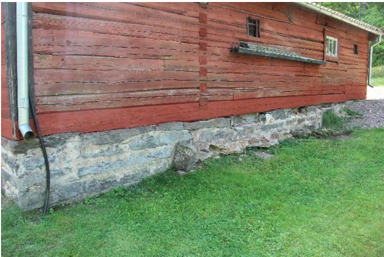
Figur 18. Grunden mot norr innan åtgärd.
