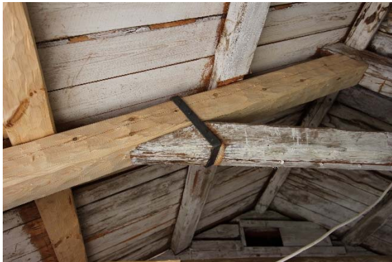
Figur 11 och 12. I mötet mellan bevarad hanbjälke och högben användes ett specialtillverkat smitt järnband. I nocken spikades det nya högbenets förbindning på samma sätt som befintliga takstolar.
