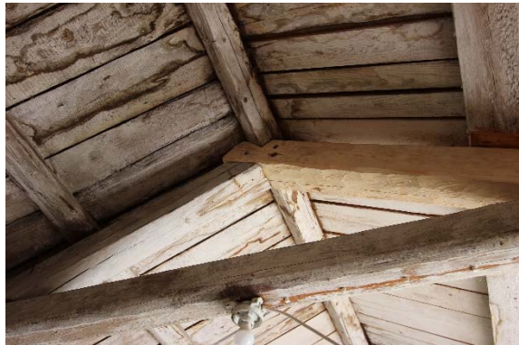
Figur 11 och 12. I mötet mellan bevarad hanbjälke och högben användes ett specialtillverkat smitt järnband. I nocken spikades det nya högbenets förbindning på samma sätt som befintliga takstolar.
