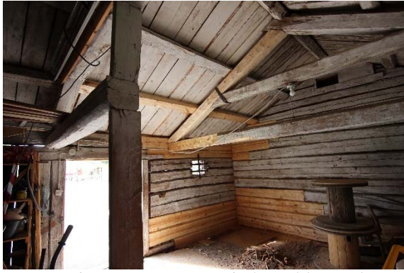
Figur 9 och 10. Reparationer utförda i takkonstruktionen och i väggar.
