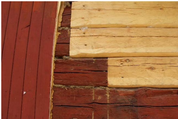
Figur 13. Skarvning av timmer genom halvt i halvt. Figur 14 (till höger) visar ny knutning i sydvästra knutkedjan.
