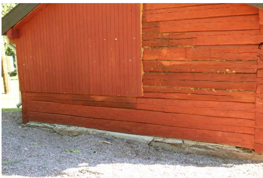
Figur 5. Åtgärder för att snygga till västra fasaden, dess grund och ytterligare sänkning av marknivån kvarstår.
