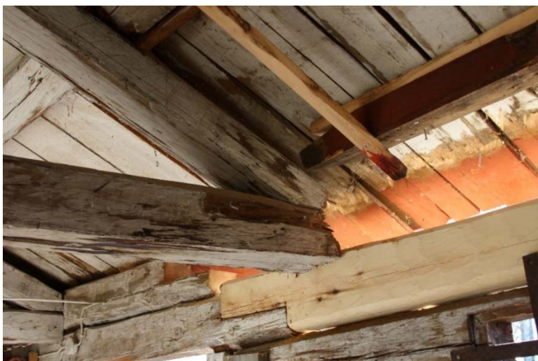
Figur 8. I takstolen längst i väster i södra takfallet hade rötan gått långt in i virket. Del av hammarband och väggtimmer fick skarvas.
