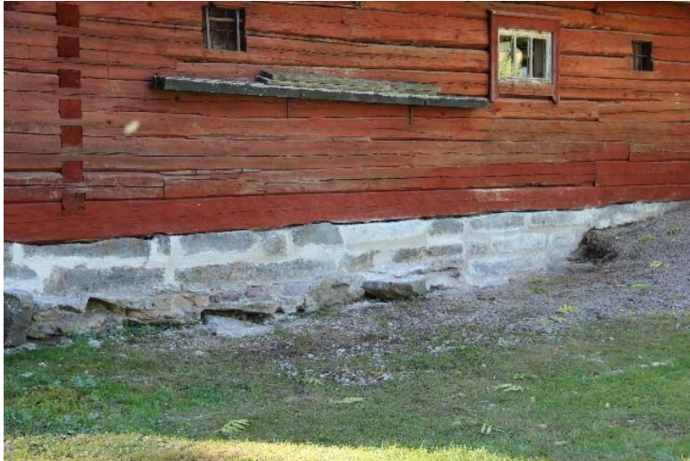
Figur 20. Grunden mot norr efter åtgärd.
