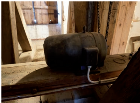
Figur 24. En av de äldre klockmotorerna. Foto: Tobias Mårud.
