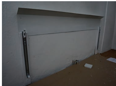
Figur 15. En av de äldre radiatorerna, denna monterad på orgelläktaren. Foto: Tobias Mårud.
