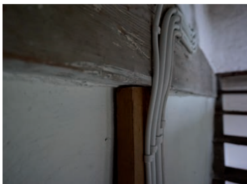
Figur 29. Ny kabelbräda klämd på plats, reversibel montering utan överkan på murverket. Foto: Tobias Mårud.
