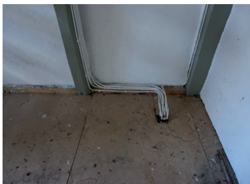
Figur 11. Kabelgenomförning mellan två plan i tornet, innan åtgärd. Foto: Tobias Mårud.
