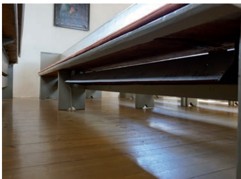
Figur 18. Äldre bänkvärmare. Foto: Tobias Mårud.
