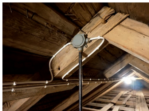
Figur 29. Ny kabelbräda klämd på plats, reversibel montering utan överkan på murverket. Foto: Tobias Mårud.
