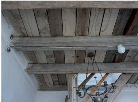
Figur 20. Svåråtkomligt placerad plastarmatur i tornet. Foto: Tobias Mårud.
