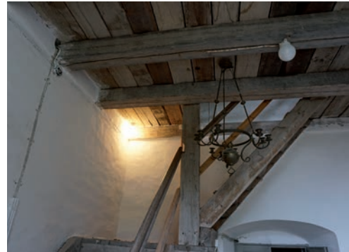
Figur 20. Svåråtkomligt placerad plastarmatur i tornet. Foto: Tobias Mårud.
