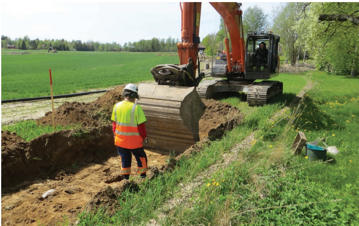
Figur 9. Sökschaktning inom Objekt 13, en boplats. Foto: Örjan Hermodsson, 2016-05-12.
