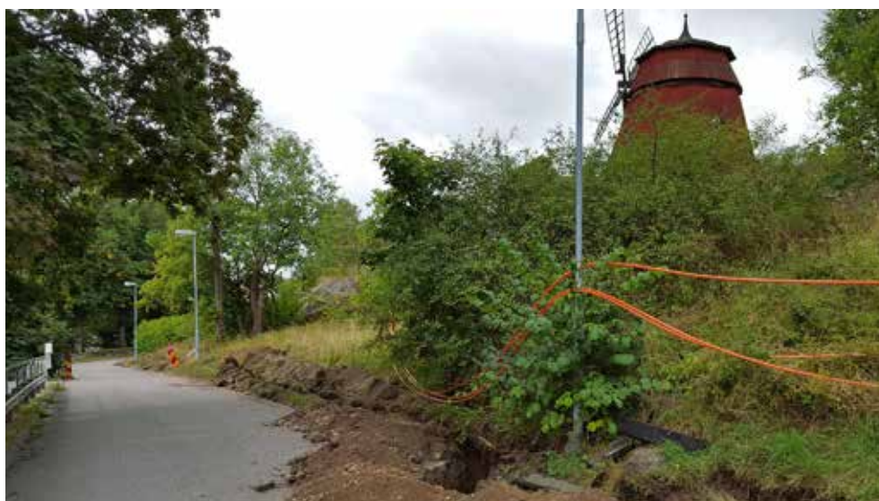
Figur 7. Fortsättningen på Bergsgatan. Den nedre delen av schaktet syns även i figur 6. Fotograferat från norr av Maud Emanuelsson.
