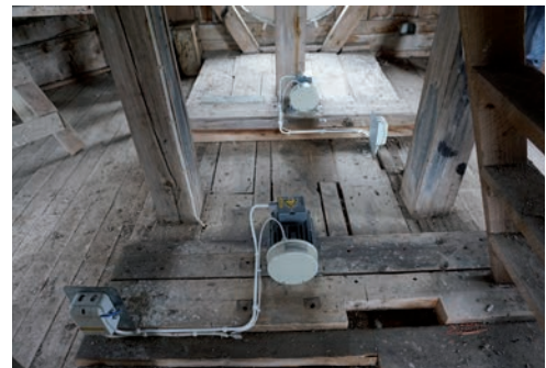
Figur 22. De nya är på plats, säkerhetsbytarna är bevarade men flyttade. Foto: Tobias Mårud.
