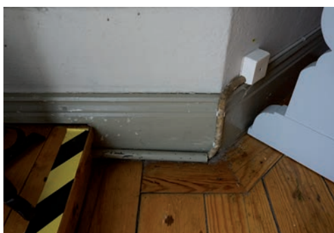
Figur 5. Äldre EDIL-kabel innan åtgärd. Foto: Tobias Mårud.
