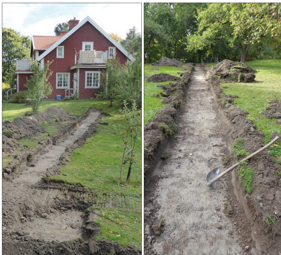
Figur 4–5. Schakt 2 från nordväst (t.v.) och Schakt 3 från nordöst (t.h.). Foto: Britta Kihlstedt.
