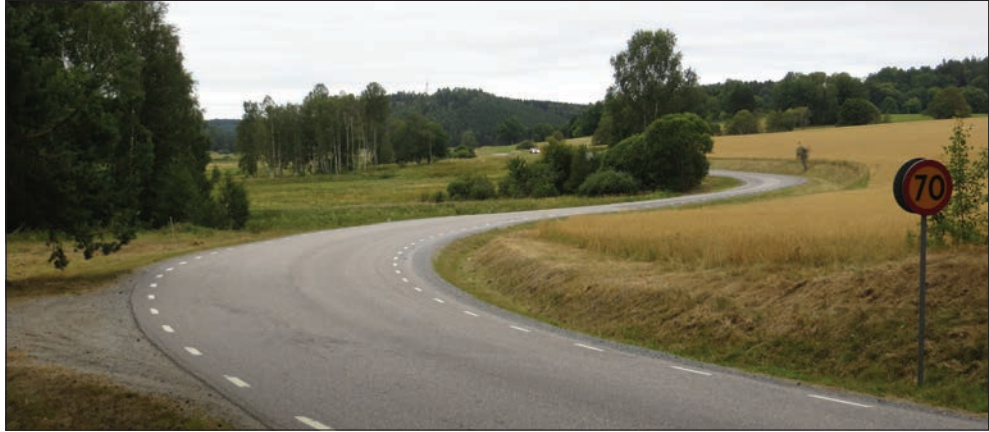
Figur 2. I utredningsområdets mellersta del löper den planerade ledningssträckningen längs väg 569, här söder om Grödinge kyrka. Vägen följer landskapets former och följer övergången mellan äldre odlingsmark och de låglänta markerna i den forna Kyrksjön. Foto från nordöst.
