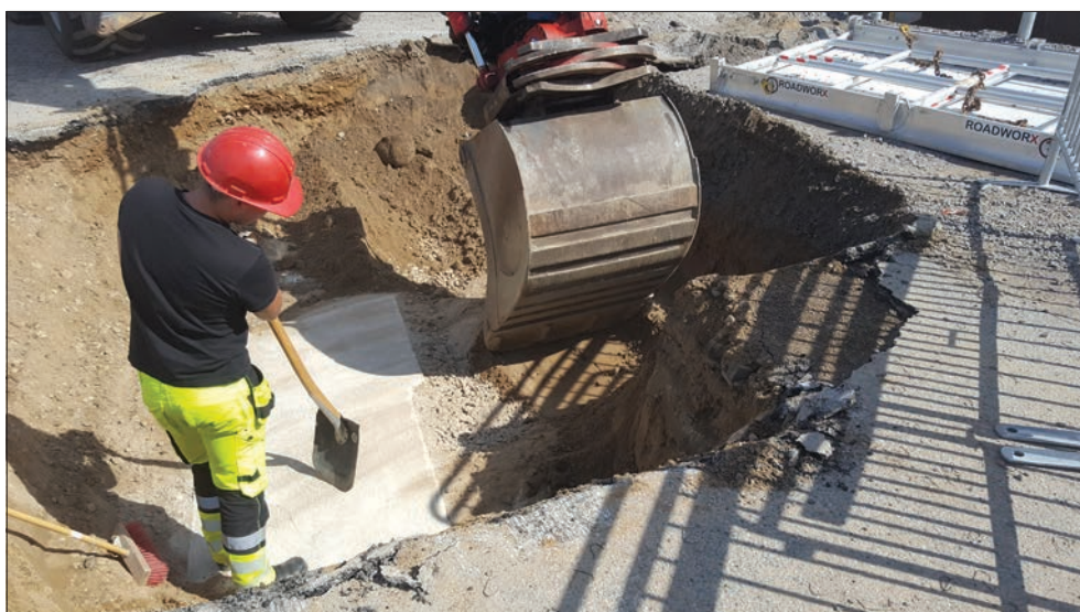
Figur 4. Pågående schaktningsarbete i schakt 1 på Tunnbindaregatan. Foto från sydväst av Josefina Kennebjörk.
