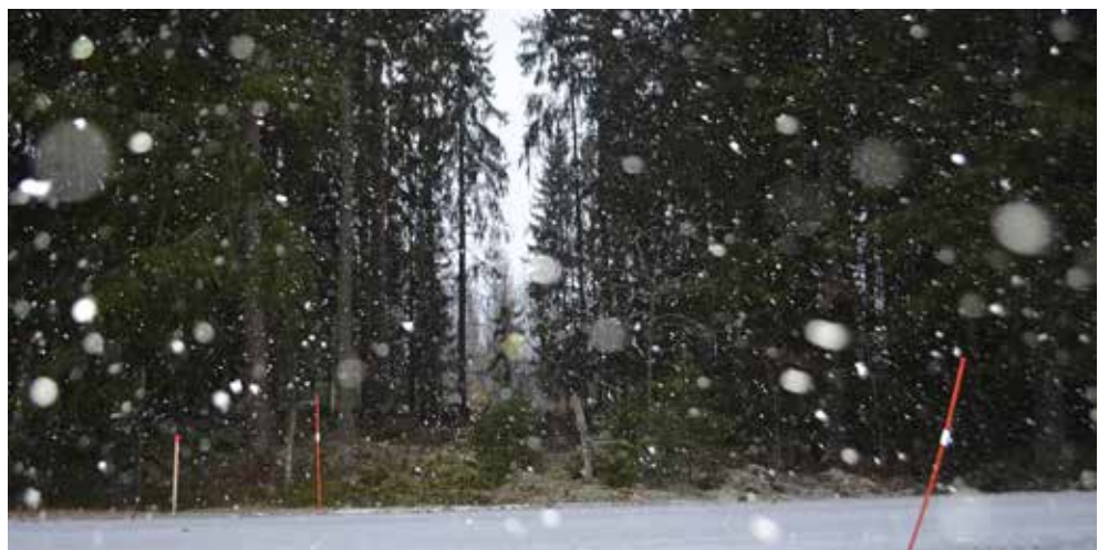
Figur 3. För schaktet söder om den enskilda vägen hade delar av granskogen avverkats för att möjliggöra för grävmaskinen att arbeta. Foto från norr av Maud Emanuelsson.
