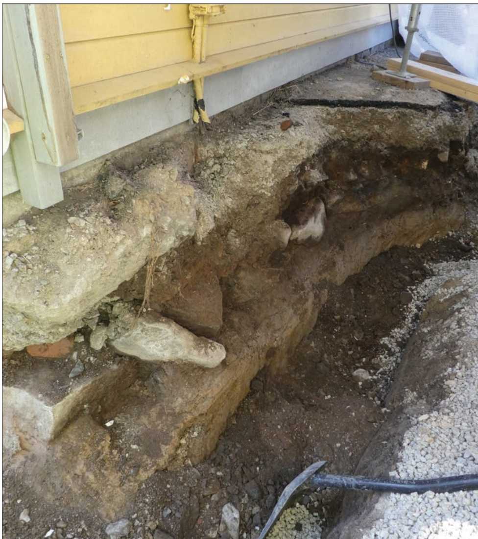
Figur 8. Sektion 3 i schakt 3 sedd från norr. Foto Oskar Spjuth.
