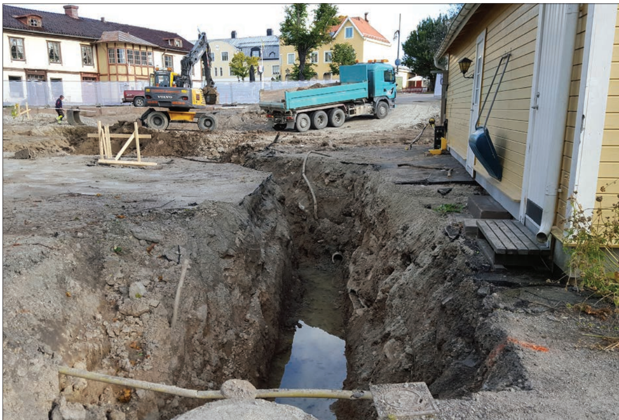
Figur 7. Schakt 2 sett från söder. Foto Maud Emanuelsson.
