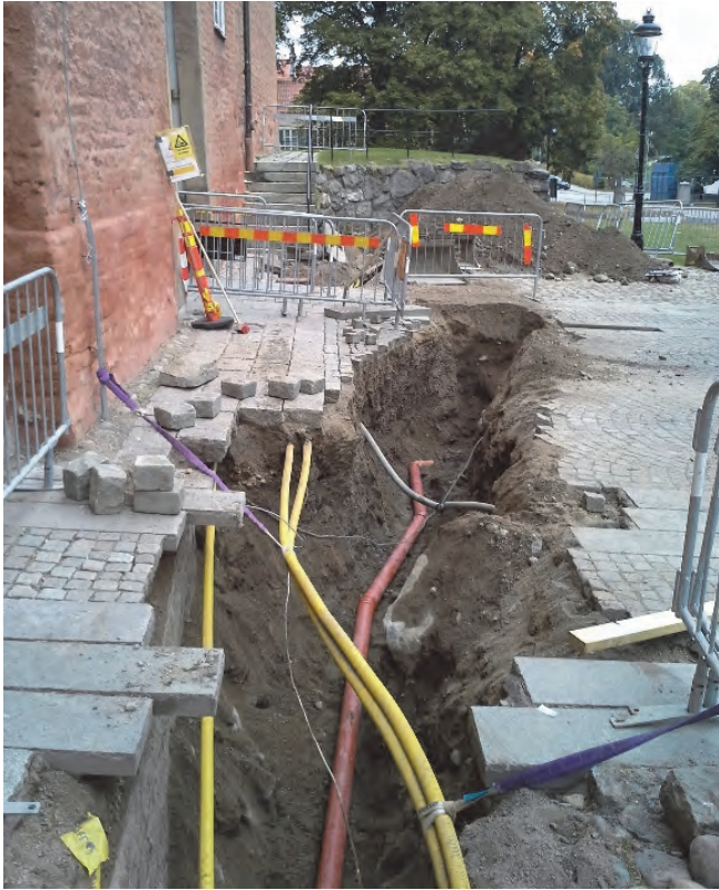
Figur 38a. Schakt 11 togs upp på den östra sidan av slottet. Foto från söder av Jonas Ros.
