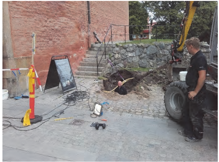
Figur 38b. Schakt 11 var som mest 1,8 meter djupt. I den norra delen av schaktet framkom kulturlager på en punkt (jfr figur 39). I schaktet ses rapportförfattaren. Foto från söder.
