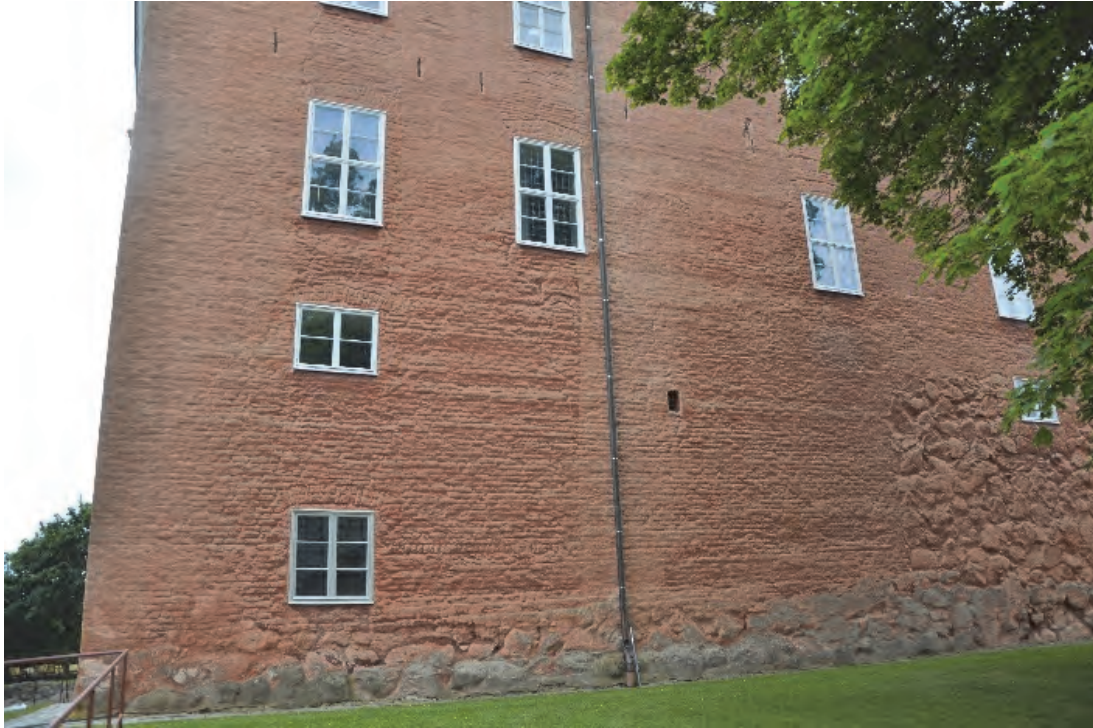
Figur 6. I slottets nordöstra fasad ser man tydligt vilken del som är den äldsta huskroppen. Till höger ser man stora stenar i fasaden, de representerar ett senare byggnadsskede. Foto från nordväst av Jonas Ros.
