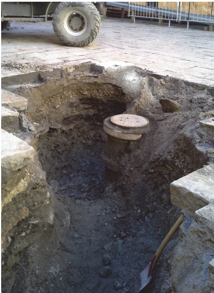
Figur 28. På borggårdens mitt fanns en dagvattenbrunn som byttes ut. Där framkom ett stort antal stenar som tillhört en äldre stensatt brunn. Foto från nordöst av Jonas Ros.
