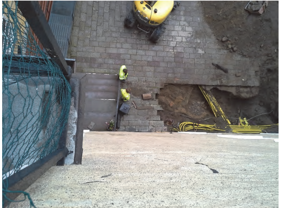
Figur 25. Översikt som visar schakt 7 där delar av den äldre stenlagda borggården framkom. Fotograferat från en balkong i den södra längan av Jonas Ros.
