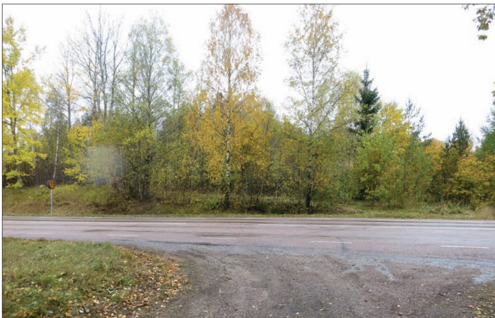
Figur 33. Vägen som löper genom objekt 12 är relativt bred, och då särskilt vid busstationerna. Foto från öster.
