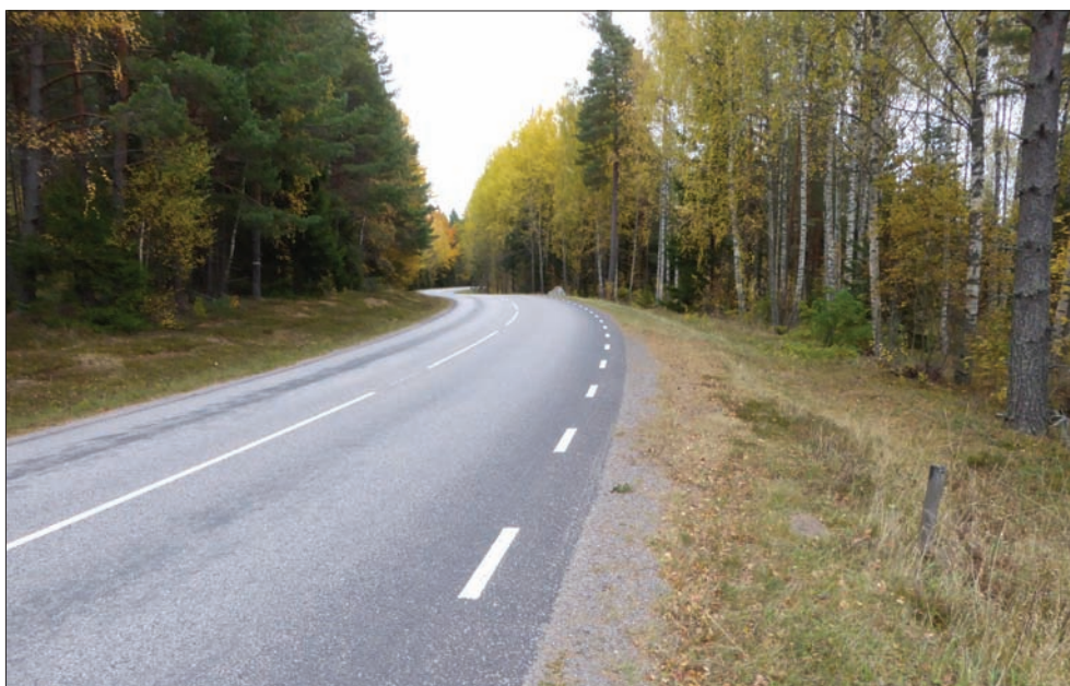
Figur 10. Väg 939 löper genom objekt 5. Åt söder är en svag slänt och åt norr ett mycket grunt dike. Foto från väster.
