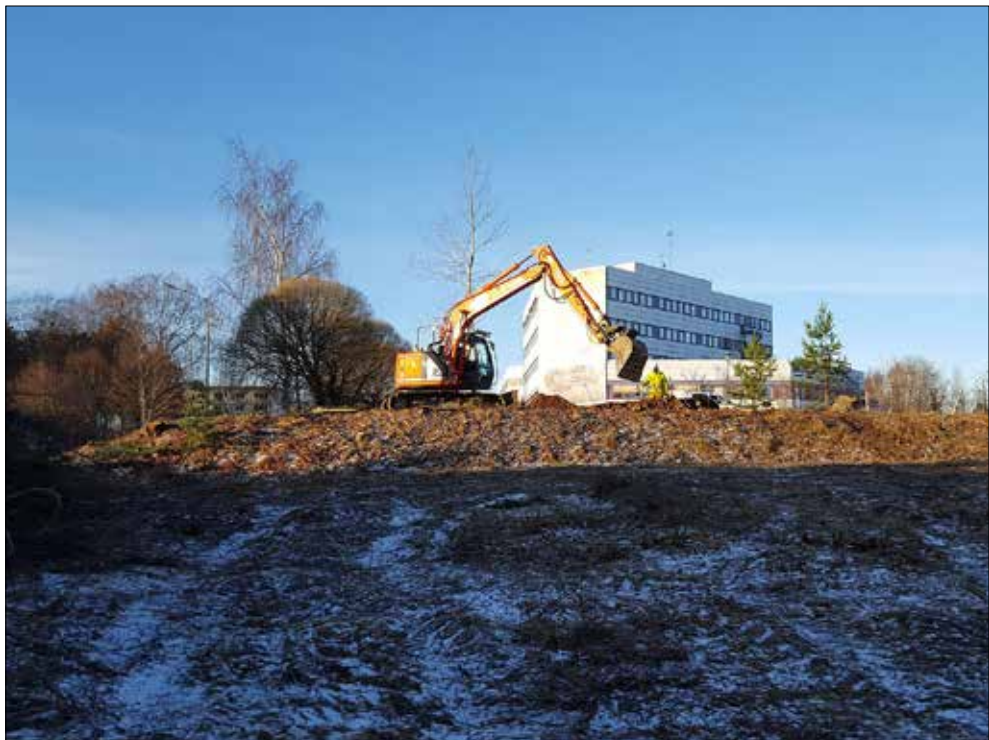
Figur 8. Schakt 22 grävs genom påförda massor. Foto från östsydost av Maud Emanuelsson.
